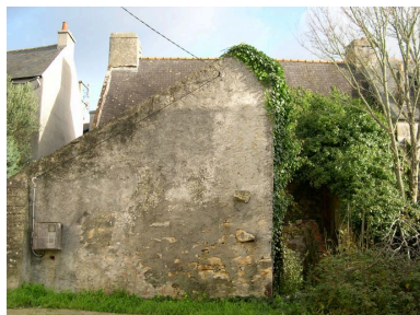
Vue arrière du n° 1 rue Saint-Pol-Roux Phot. Guillaume Marie IVR53_20062908473NUCA
