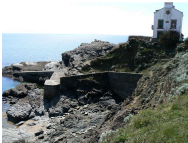
Vue générale de la cale des Grands-Sables Phot. Julien Amghar IVR53_20082908643NUCA
