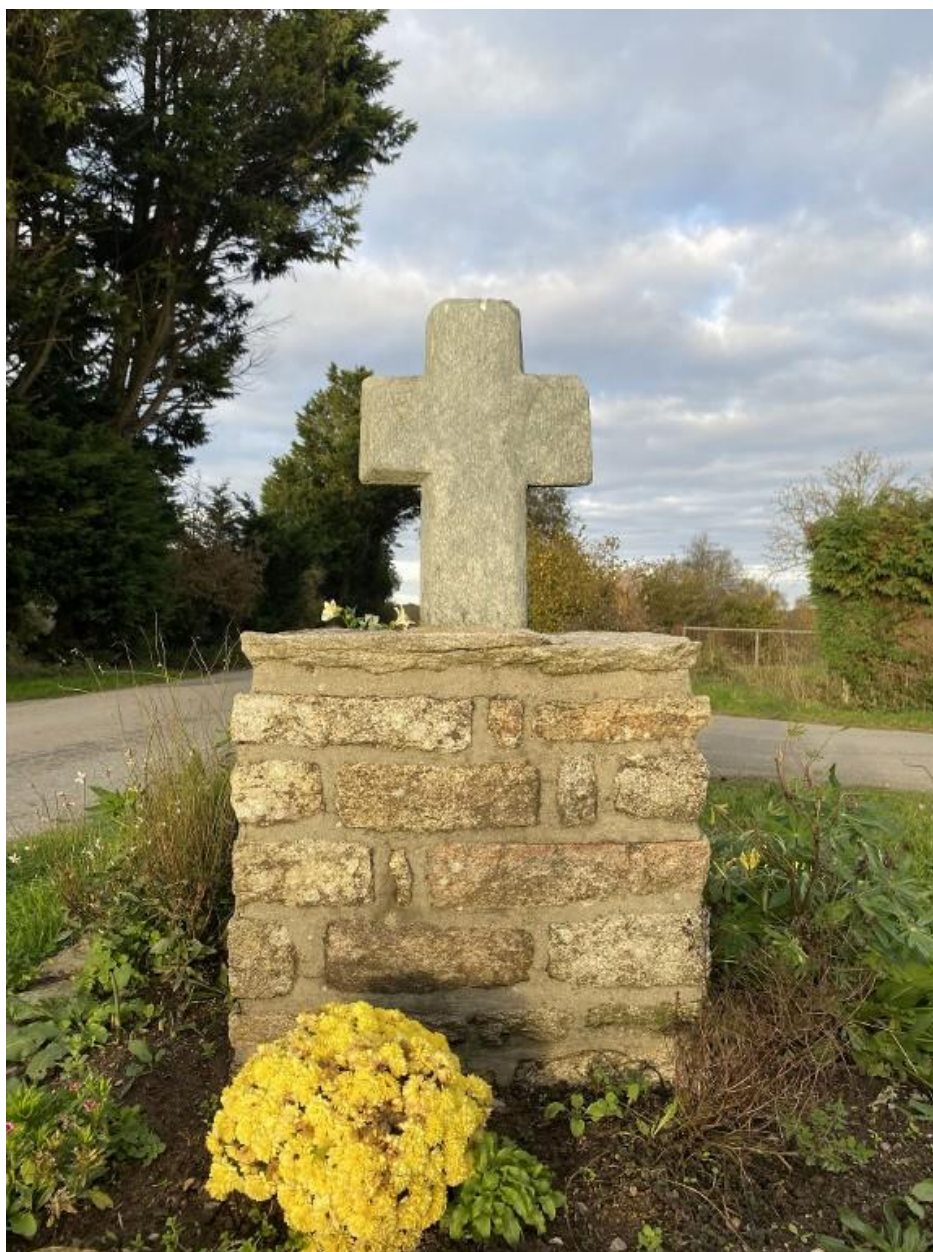
Face sud, vue générale
