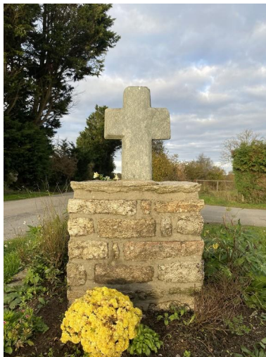
Face sud, vue générale
