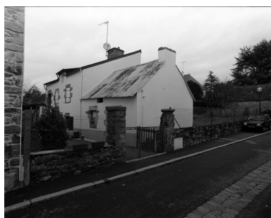
Vue générale nord-ouest Phot. Bernard Bègne IVR53_19975601127X
