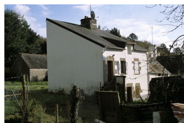
Vue générale sud-ouest Phot. Bernard Bègne IVR53_19995600220ZA
