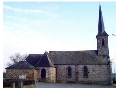
L'église : vue générale nord Phot. Xavier Gilbert IVR53_19993505405NUCA
