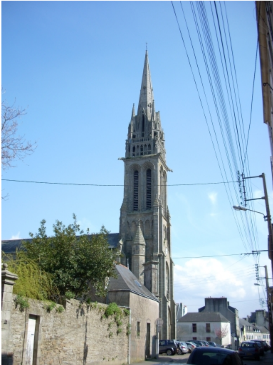
Douarnenez, église du Sacré-Coeur : vue générale nord-ouest
