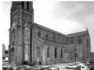
Douarnenez, église du Sacré- Coeur : vue extérieure du sud-ouest, état en 1984
