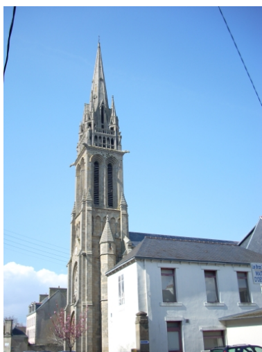
Douarnenez, église du Sacré- Coeur : vue générale sud-ouest
