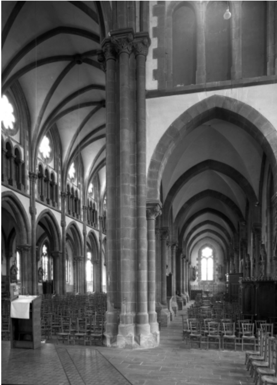
Douarnenez, église du Sacré-Coeur : vue intérieure à partir du transept nord, état en 1984
