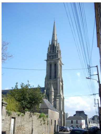
Douarnenez, église du Sacré- Coeur : vue générale nord-ouest
