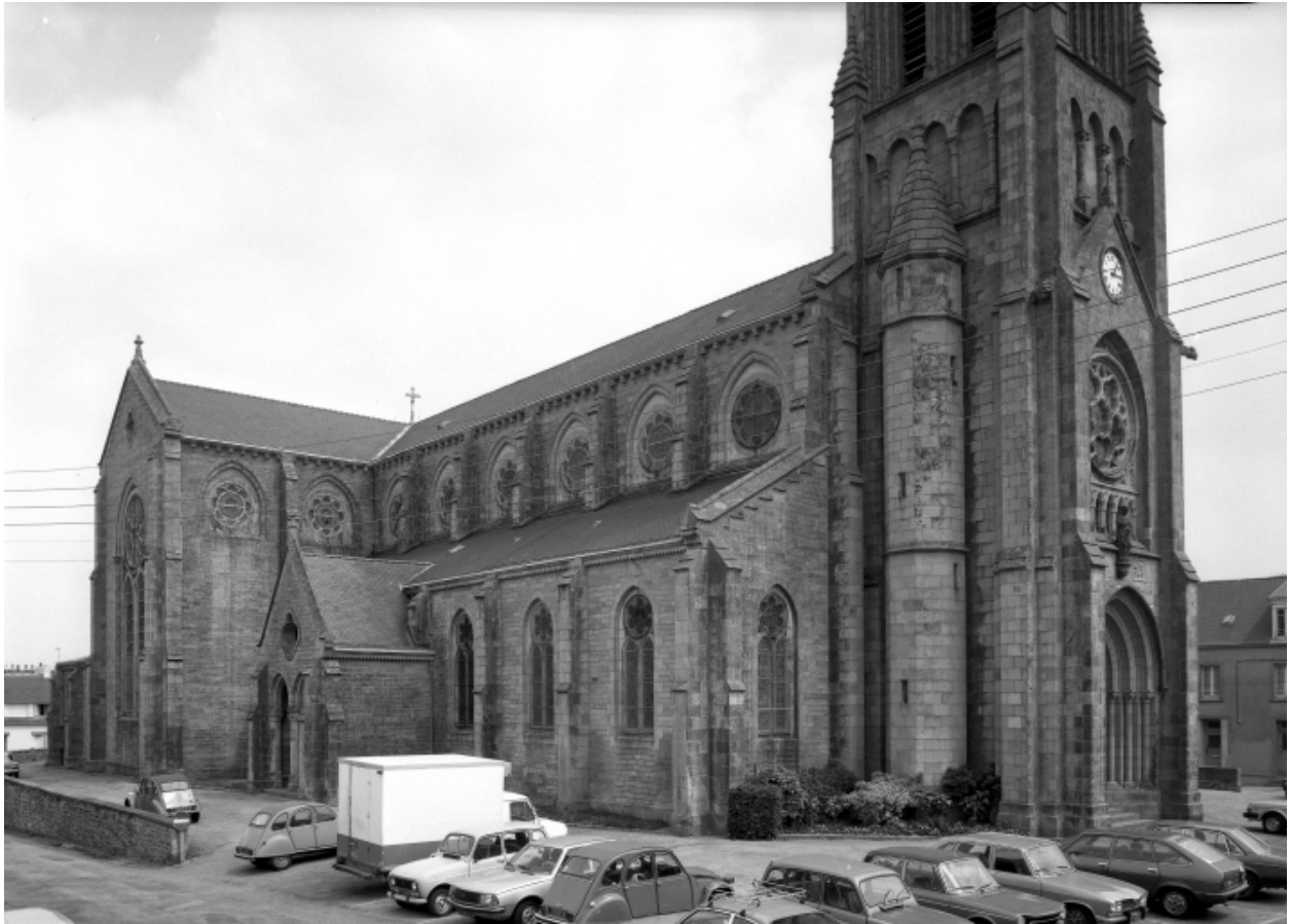
Douarnenez, église du Sacré-Coeur : vue extérieure du nord-ouest, état en 1984
