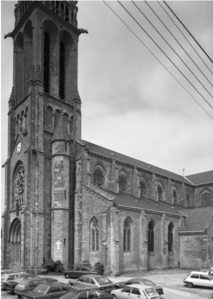
Douarnenez, église du Sacré-Coeur : vue extérieure de détail : clocher, nef, bas-côté sud-ouest, état en 1984
