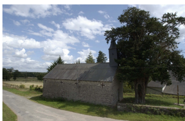
Vue de situation nord-ouest Phot. Guy Artur, Phot. Norbert Lambart IVR53_20023503188NUCA
