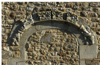
Décor sculpté de l'arc de la porte Phot. Norbert Lambart IVR53_20053502561NUCA
