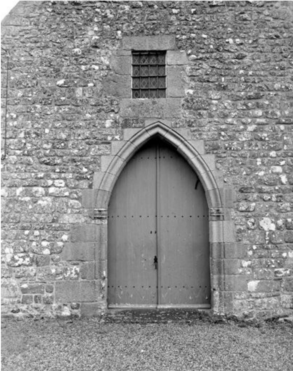
Elévation ouest, porte
