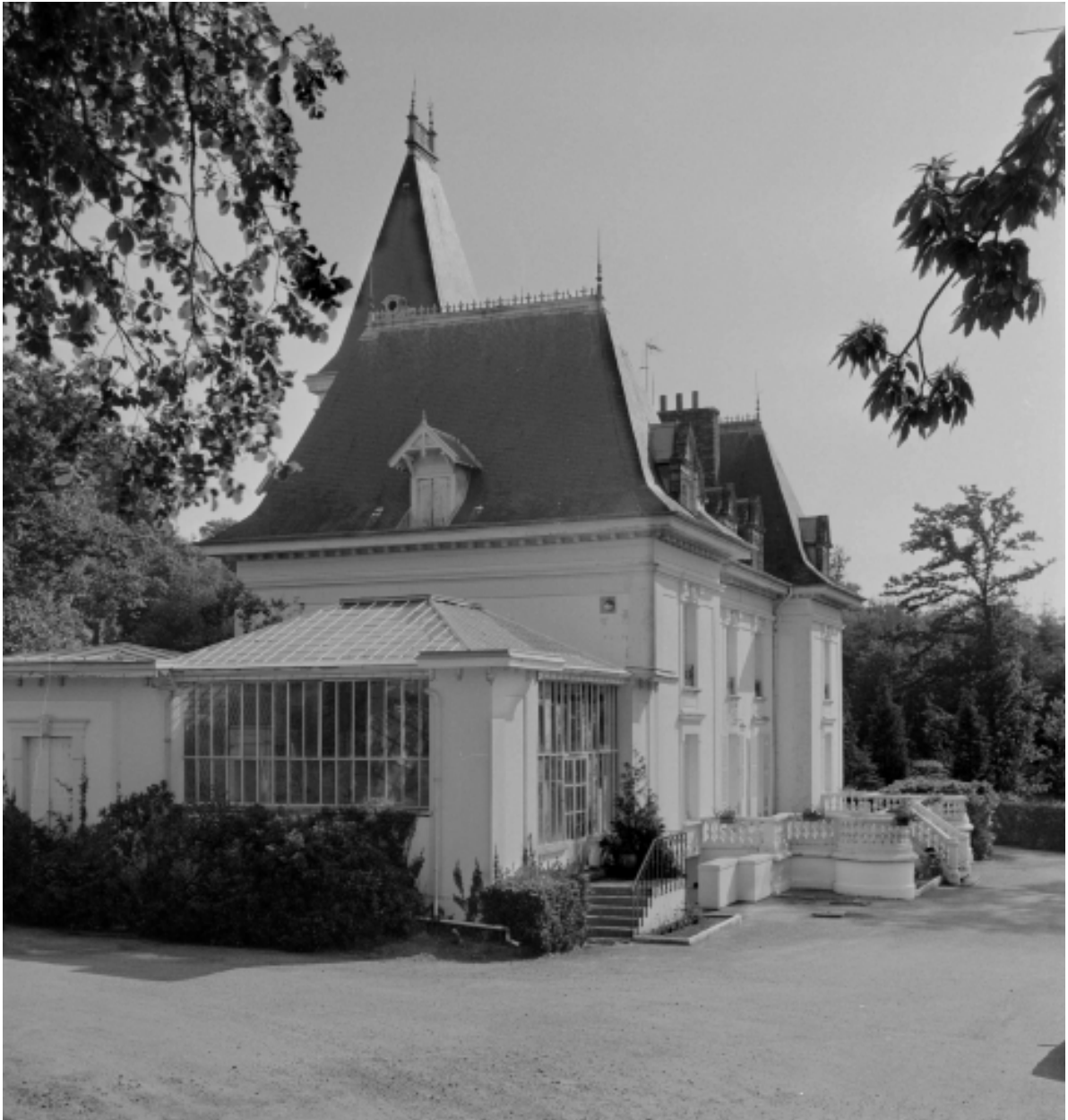
Logis : vue sud ouest
