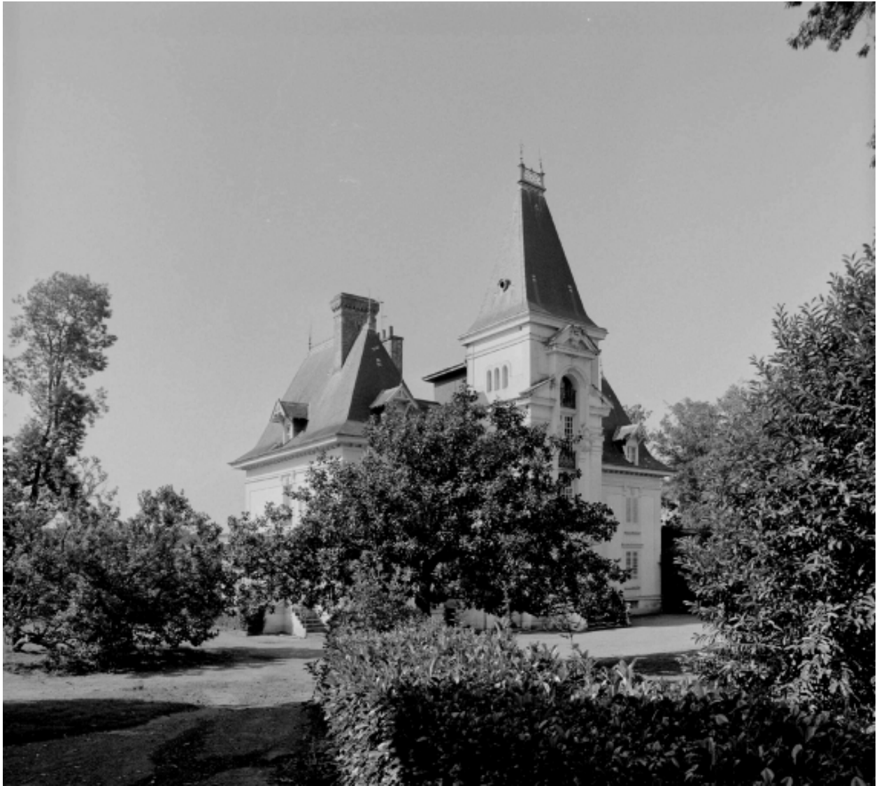
Logis : vue nord est
