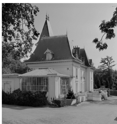
Logis : vue sud ouest Phot. Guy Artur, Phot. Norbert Lambert IVR53_19952200449X
