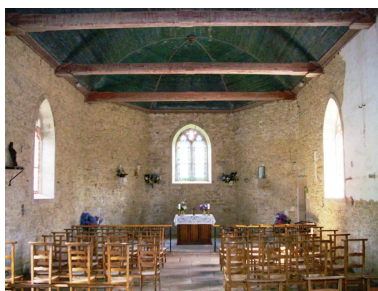
Plougonven, chapelle Saint-Germain : vue axiale est Phot. Gwénaél Fauchille IVR53_20082906651NUCA
