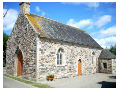
Plougonven, chapelle Saint-Germain : vue générale sud-ouest Phot. Gwénaél Fauchille IVR53_20082906649NUCA
