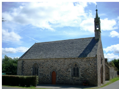
Plougonven, chapelle Saint-Germain : vue générale nord-ouest Phot. Gwénaél Fauchille IVR53_20082906647NUCA
