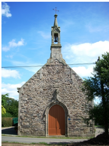
Plougonven, chapelle Saint-Germain : élévation ouest Phot. Gwénaél Fauchille IVR53_20082906648NUCA
