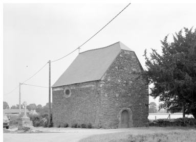
Chapelle vue nord-ouest (état en 1984) Phot. Norbert Lambart IVR53_19845601704X
