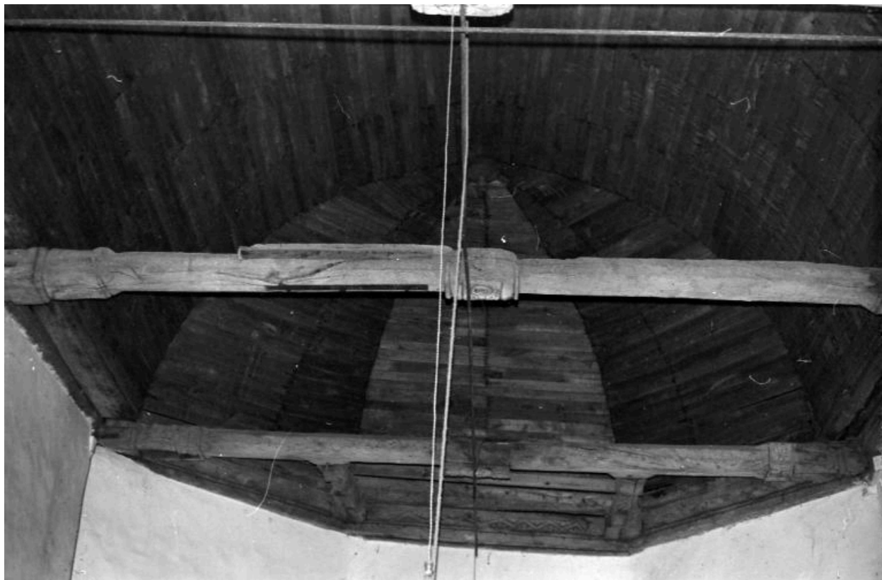
Vue de la charpente
