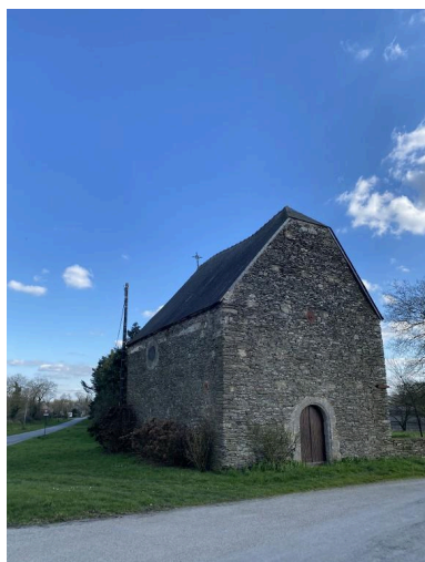
Vue générale nord-ouest Phot. Baptiste Oligo IVR53_20255610390NUCA
