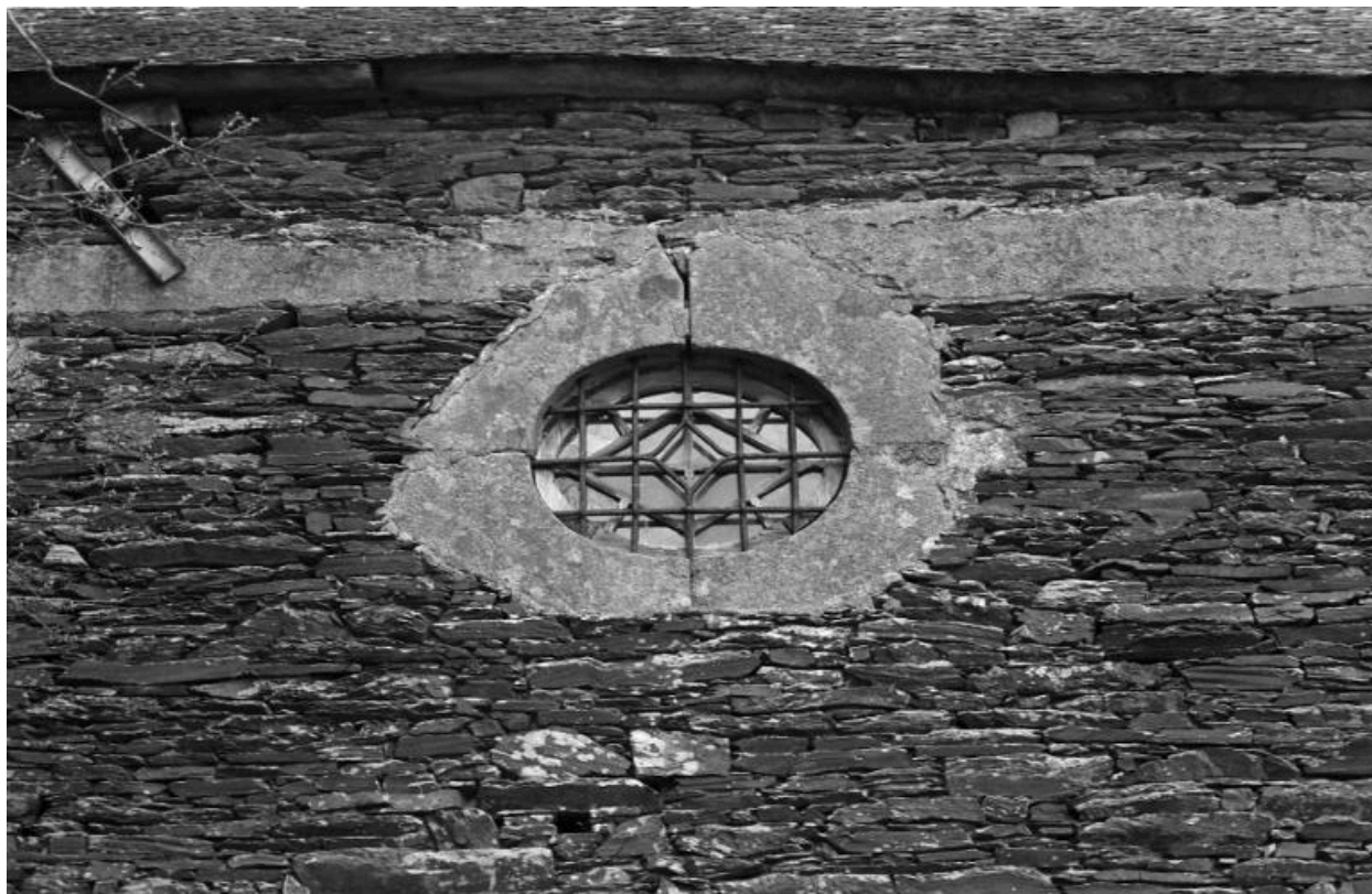
Détail d'une lucarne
