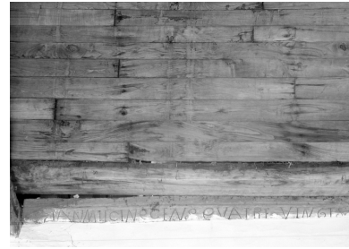
Chapelle : sablière portant l'inscription LAN MIL CINQ CENS E QUATRE VINGTS SEPT (état en 1984) Phot. Norbert Lambart IVR53_19845601709X
