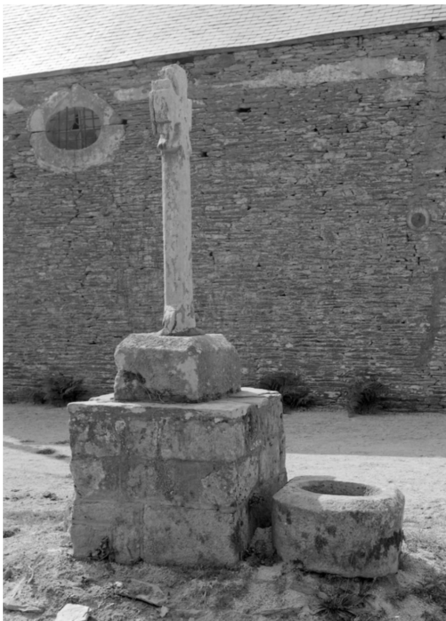
Croix monumentale vue de profil (état en 1984)
