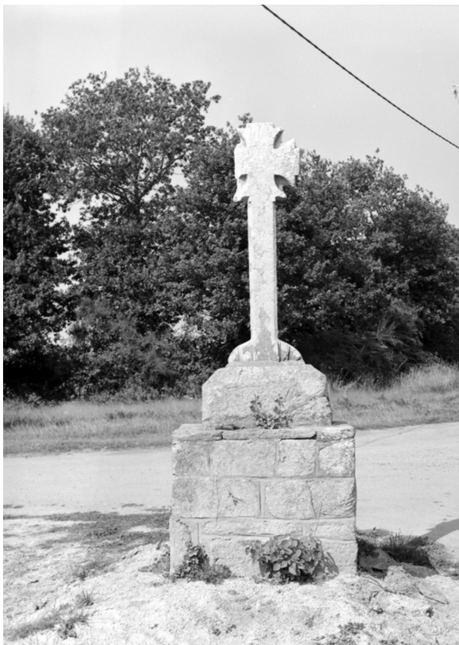
Croix monumentale vue de l'est (état en 1984)
