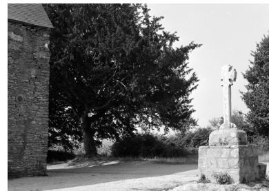
Croix monumentale : vue de situation depuis le nord-est (état en 1984) Phot. Norbert Lambart IVR53_19845601829X
