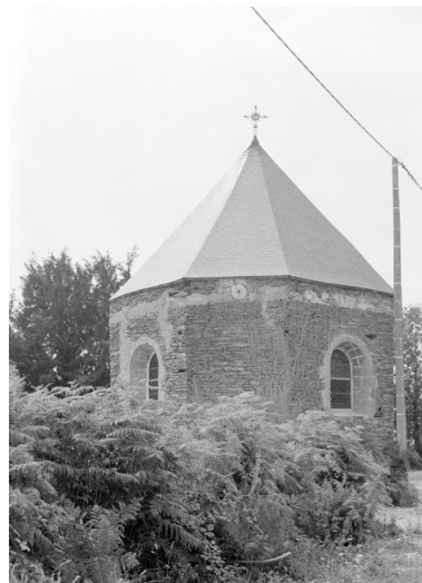
Chapelle : le chevet (état en 1984) Phot. Norbert Lambart IVR53_19845601705X
