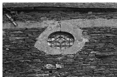
Détail d'une lucarne Phot. Berthou Marie, Phot. Catherine Toscer IVR53_19765606012Z
