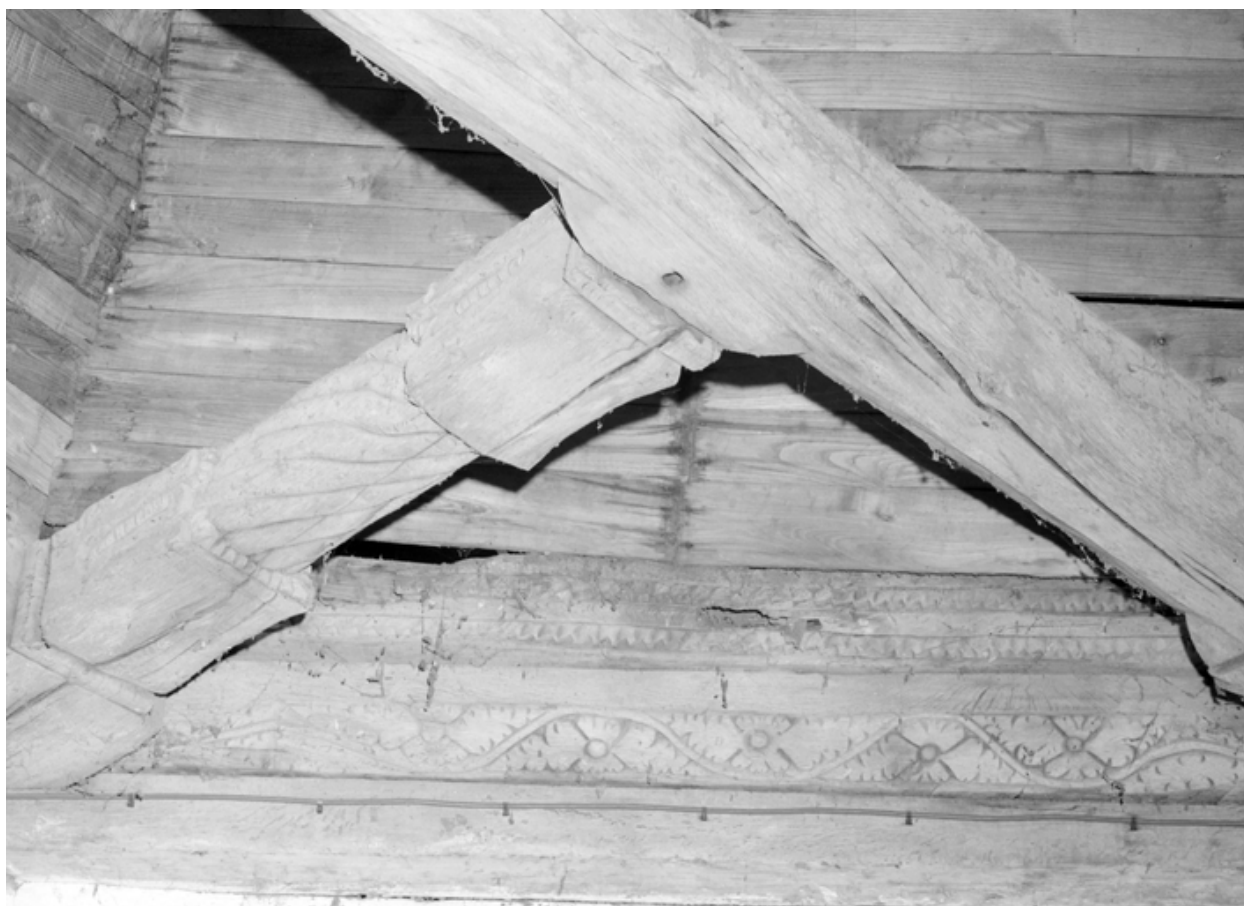
Chapelle : un entrain, deux engoulants et une sablière ornée de végétaux (état en 1984)
