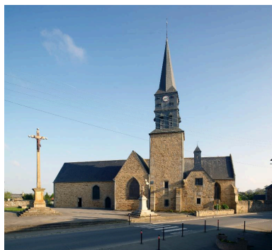
Vue générale : côté sud Phot. Norbert Lambart IVR53_20143500325NUCA
