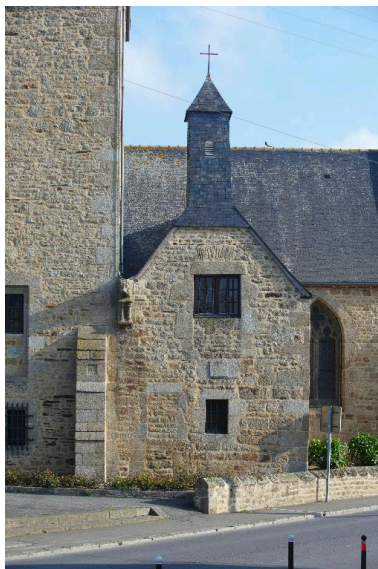
Sacristie : côté sud Phot. Norbert Lambart IVR53_20143500326NUCA
