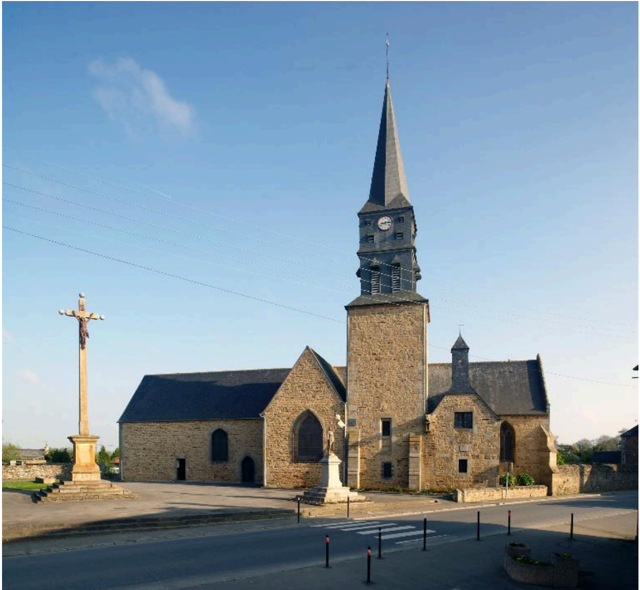
Vue générale : côté sud
