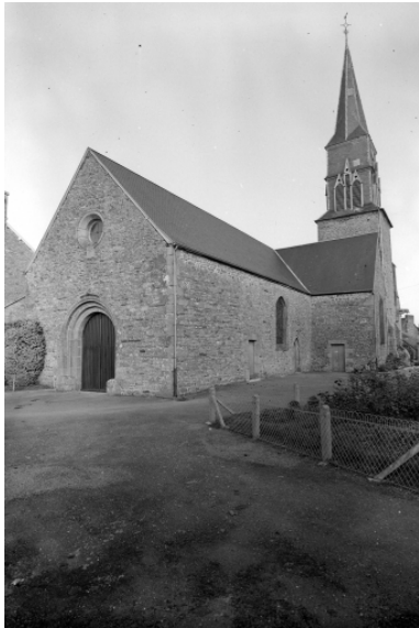
Vue générale sud-ouest. Phot. Auteur inconnu IVR53_19683500751V
