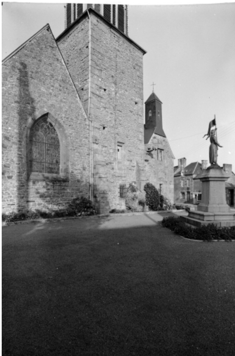
Façade sud, bras du transept et tour.
