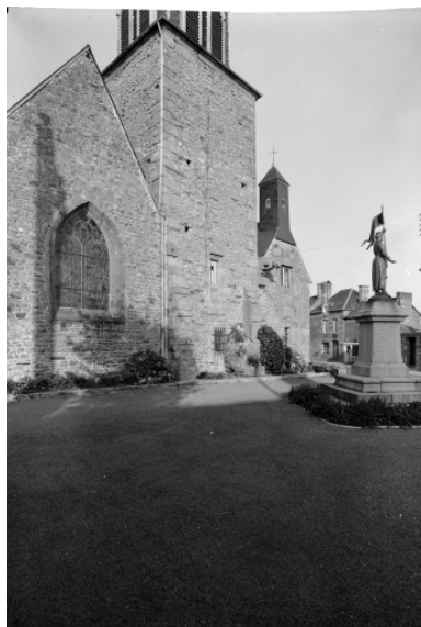
Façade sud, bras du transept et tour. Phot. Guy Artur IVR53_19683500755V
