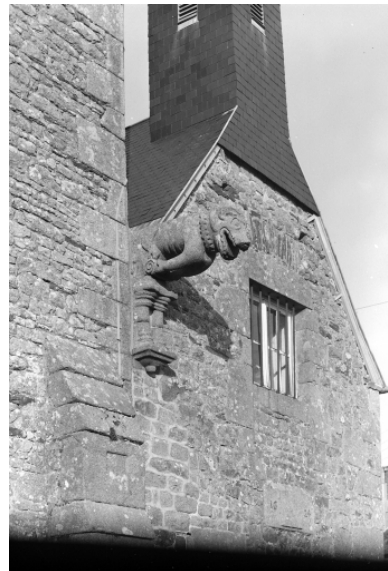
Façade sud, sacristie détail crossette. Phot. Guy Artur IVR53_19683500753V
