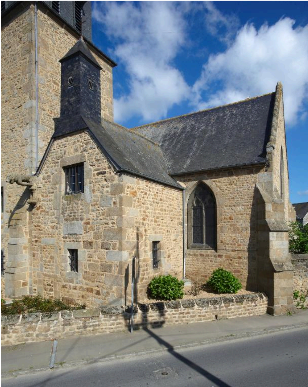
Sacristie et chevet (côté sud-est)
