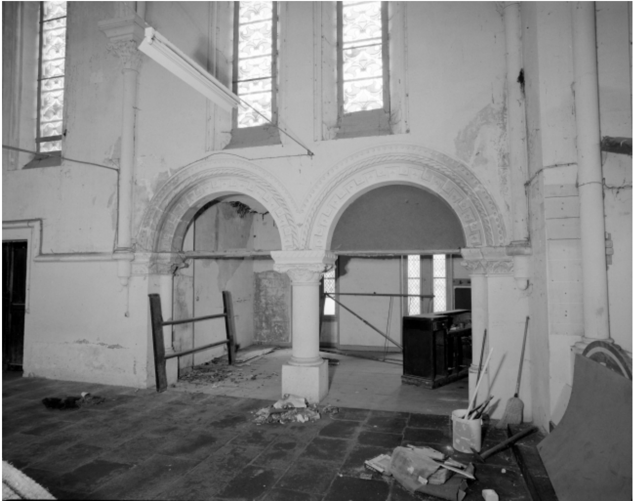
Intérieur, chapelle latérale Nord : vue générale
