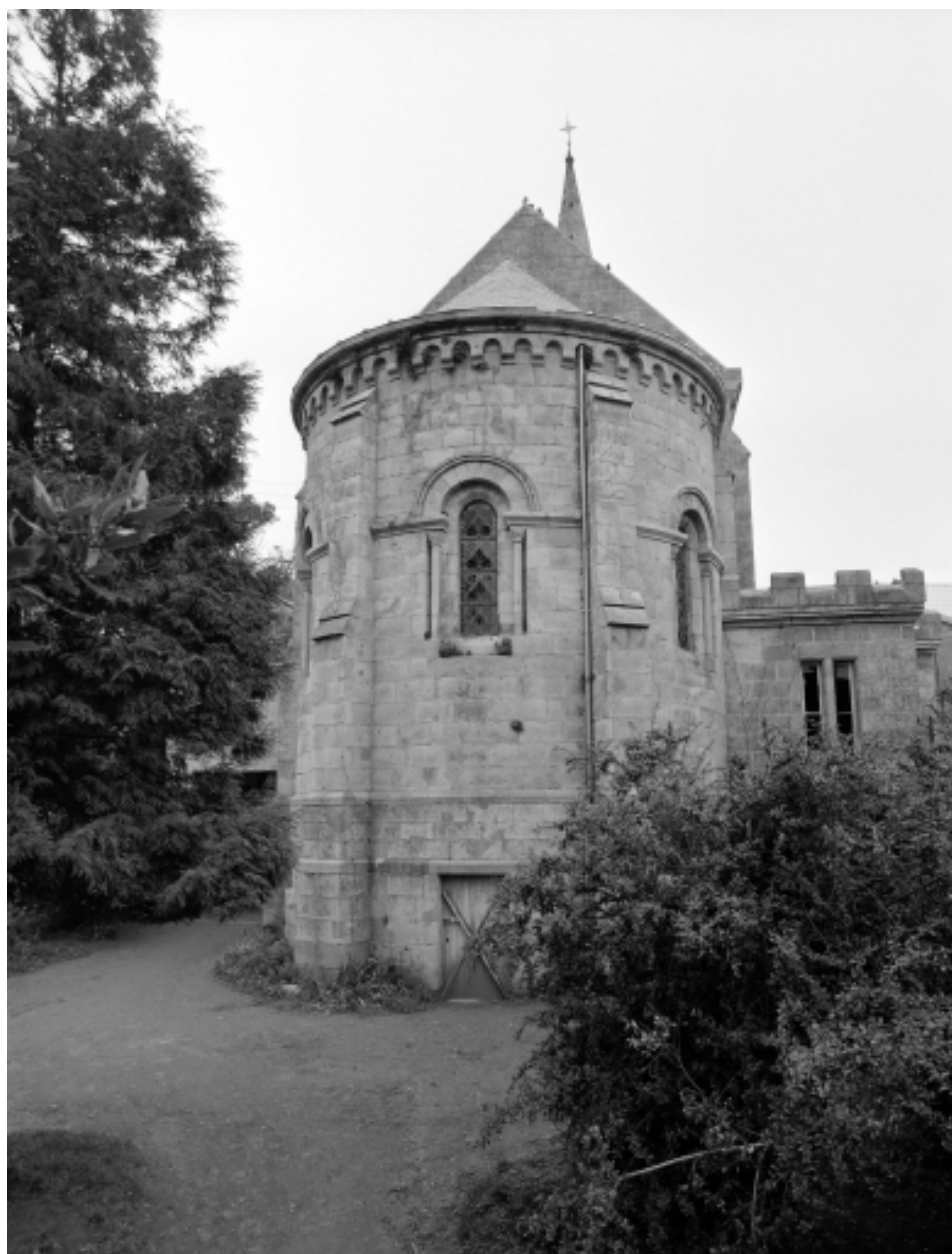
Elévation Est, chevet : vue générale
