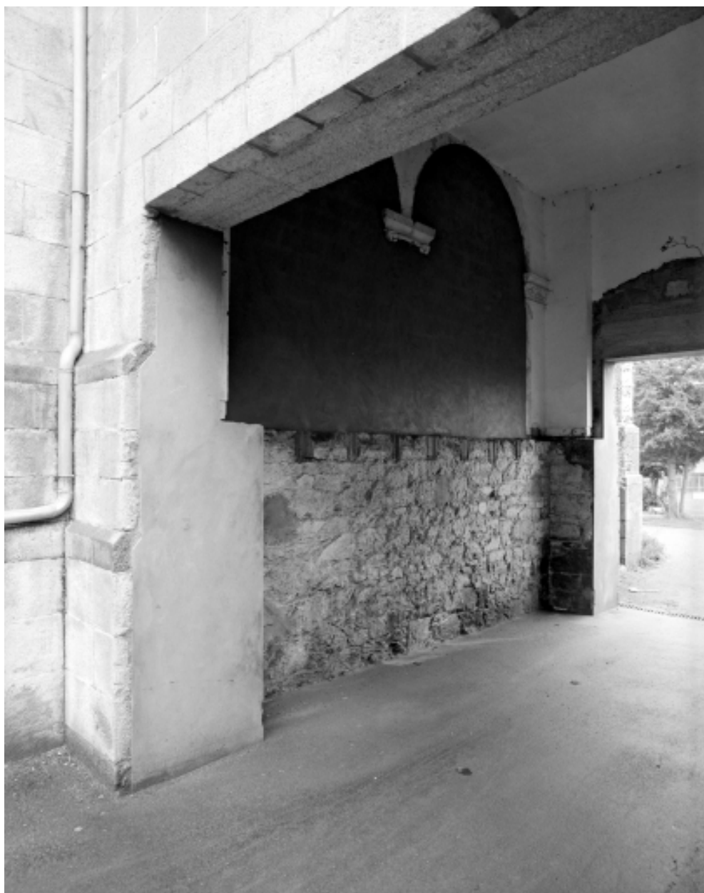
Elévation Sud, chapelle latérale : vue générale
