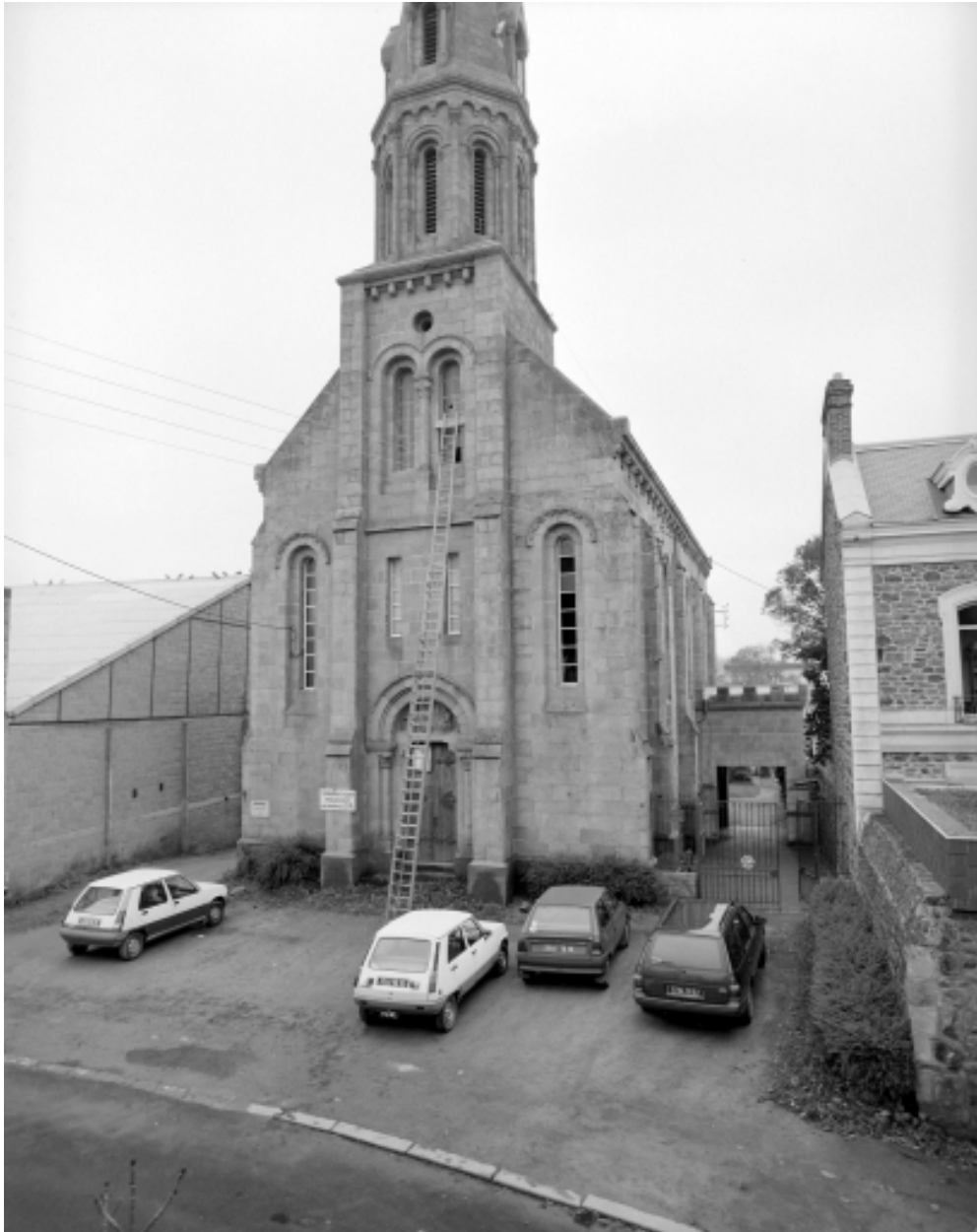
Elévation Ouest : vue générale
