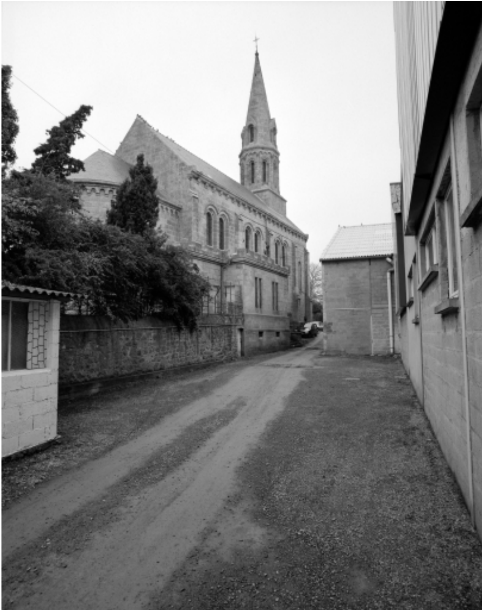
Elévation Nord-Est : vue générale
