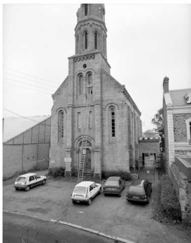
Elévation Ouest : vue générale Phot. Bernard Bègne, Phot. M. Loyon IVR53_19923500923X
