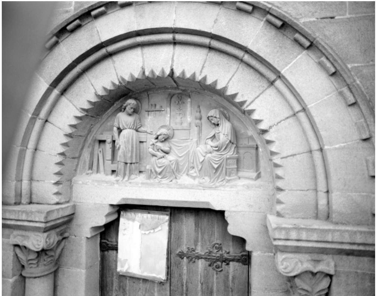
Elévation Ouest, porte : détail du tympan
