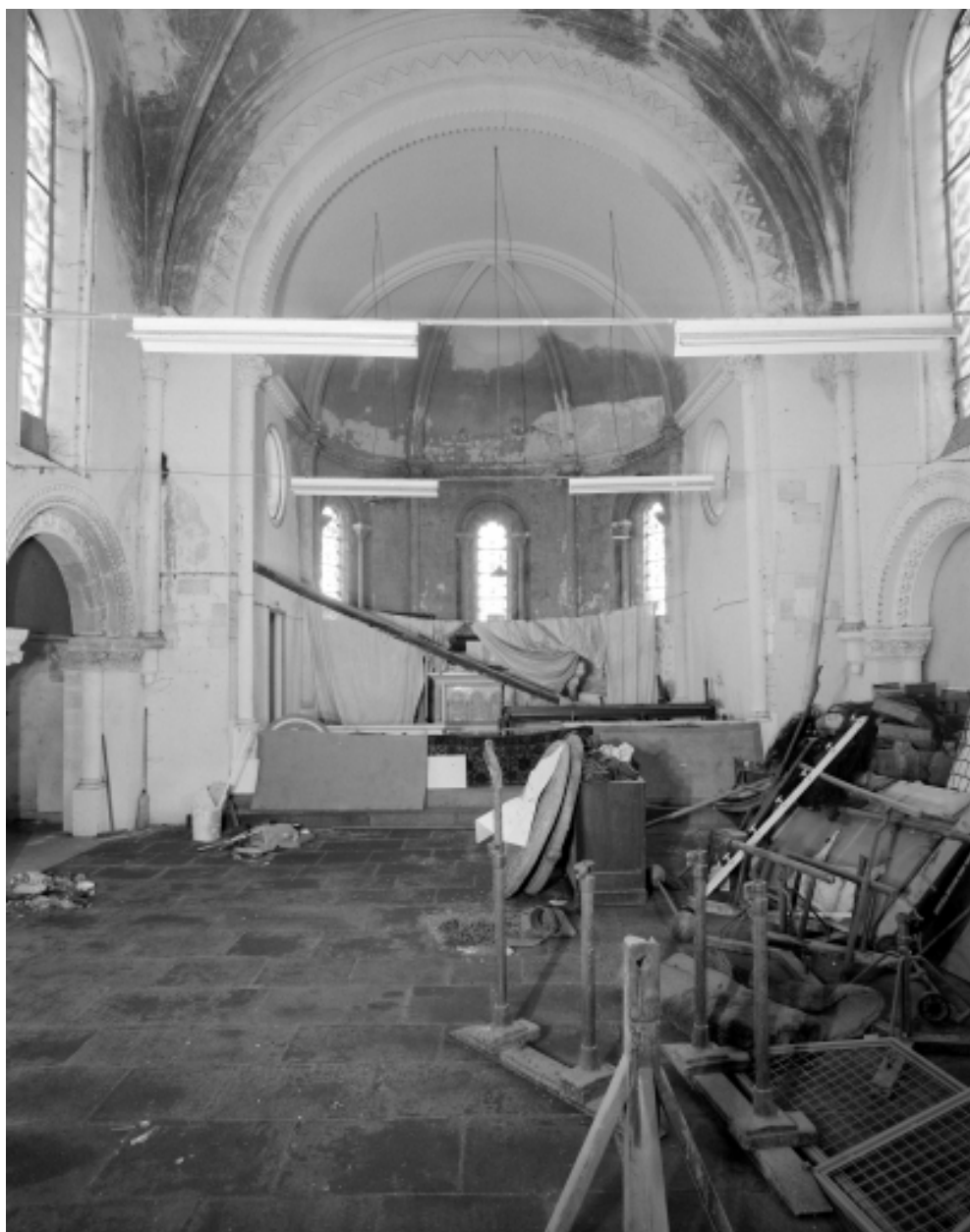
Intérieur : vue générale vers le chœur
