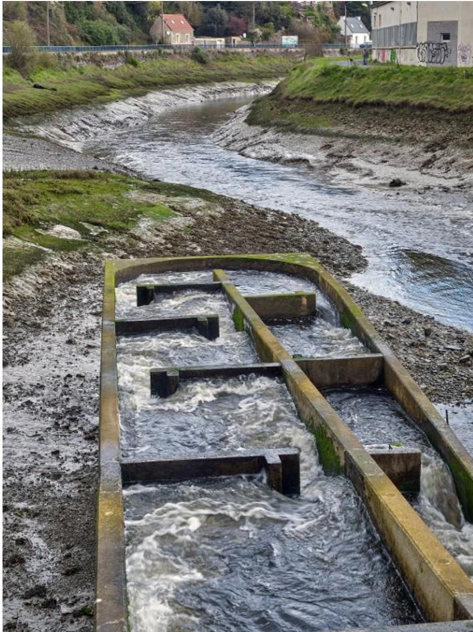
La passe à poissons du bassin à flot située à proximité de l'île sèche
