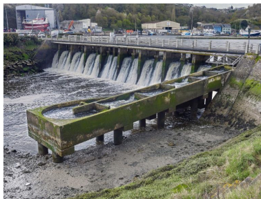
La passe à poisson du déversoir du bassin Phot. Bernard Bègne IVR53_20262200220NUCA
