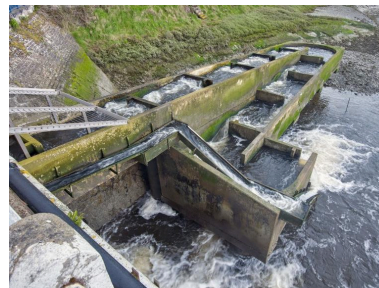
La passe à poissons depuis le pont-déversoir du bassin à flot Phot. Bernard Bègne IVR53_20262200221NUCA
