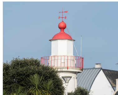
Le sommet du phare de la Croix Phot. Charlotte Barraud IVR53_20242901263NUCA
