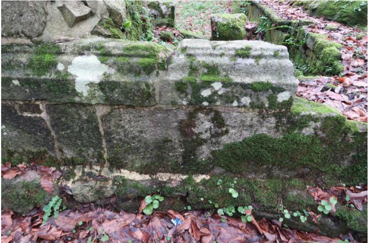
Vue de détail du mur ouest (portail) : pierres de taille moulurées sur des fondations en moellon
