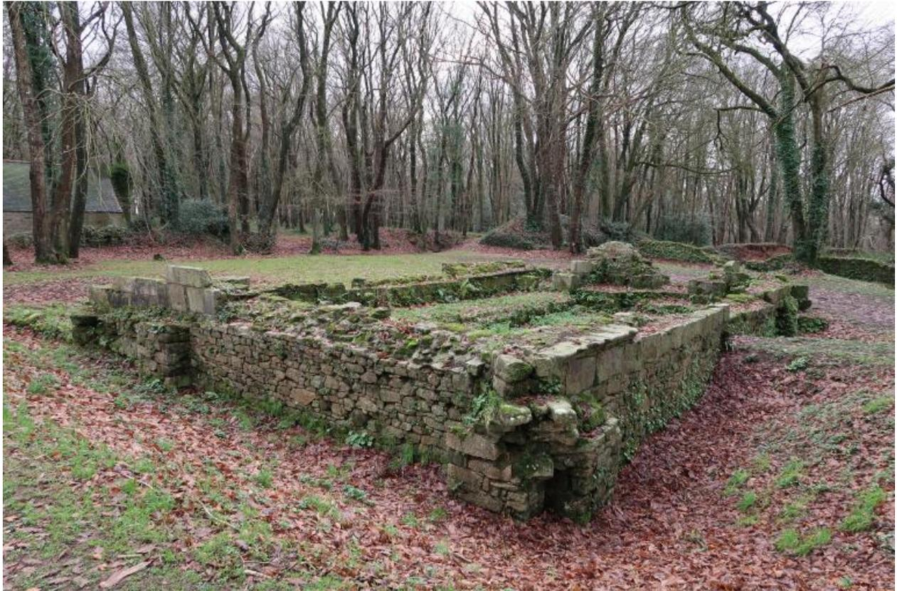
Vue générale depuis le nord : murs nord et est (chevet plat). A l'intersection des murs, contrefort oblique. On distingue un appareillage en moellon (partie basse) et en pierre de taille (partie haute)
