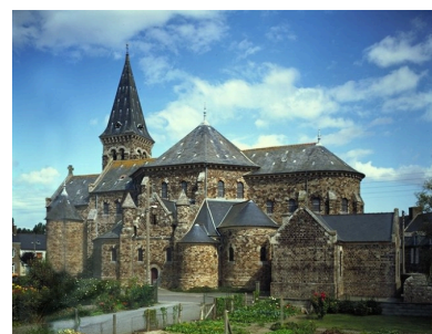
La Fresnais, église saint- Méén, sainte-Croix, extérieur, Arthur Regnault, néo-roman Phot. Guy Artur, Phot. Norbert Lambart IVR53_19923500701XA
