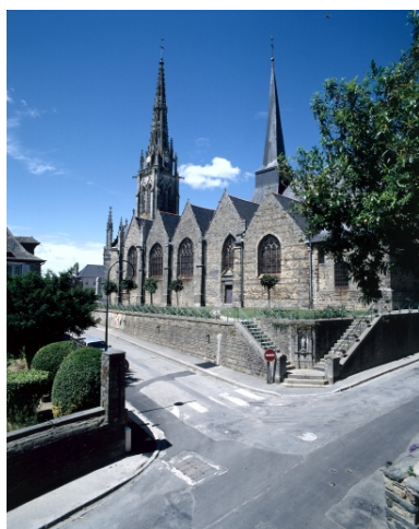
Piré-sur-Seiche, église paroissiale Saint-Pierre, gothique flamboyant Phot. Guy Artur, Phot. Norbert Lambart IVR53_19953500324XA
