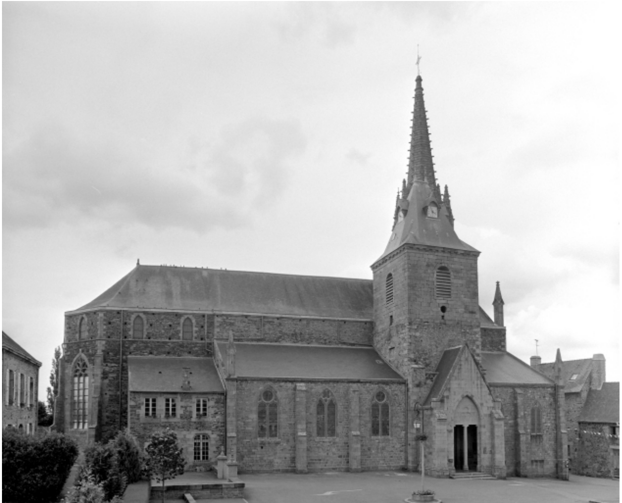
Bazouges-la-Pérouse, église saint-Pierre, saint-Paul, premier néo-gothique
