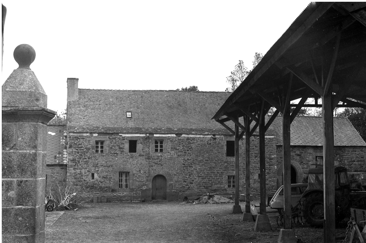
Vue générale de la façade sud
