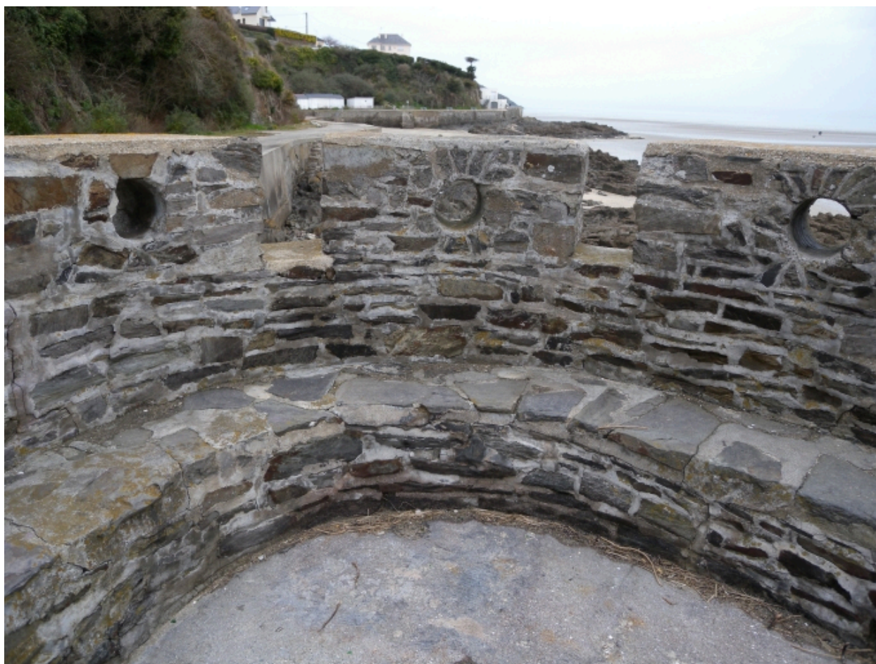
Vue des créneaux et du reposoir elliptique
