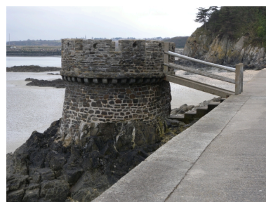
Vue de la tour et du ponton d'accès Phot. Guy Prigent IVR53_20082213199NUCA
