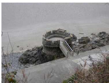
Vue en plongée de la tour située en face de la digue-promenade Phot. Guy Prigent IVR53_20082213200NUCA
