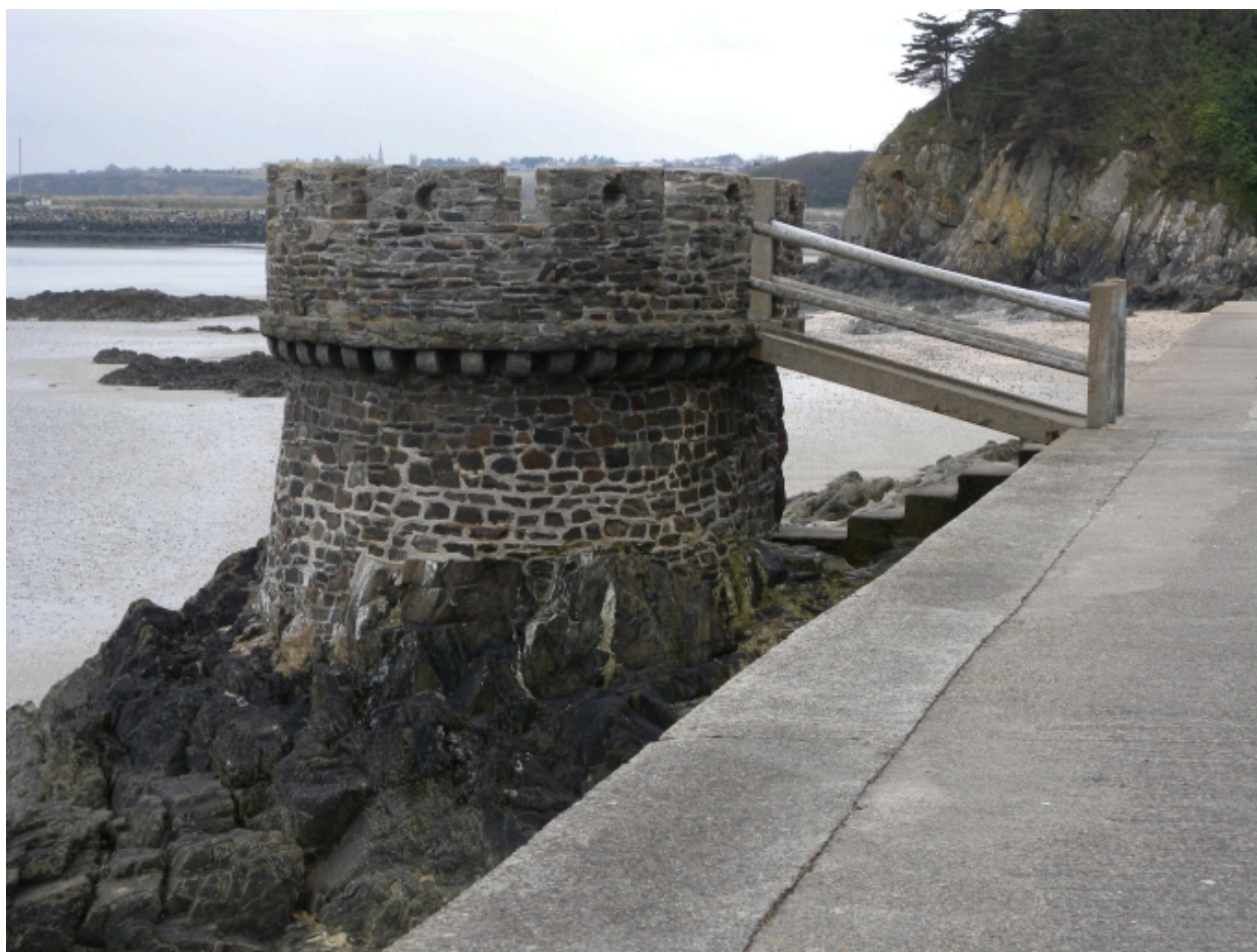
Vue de la tour et du ponteau d'accès
