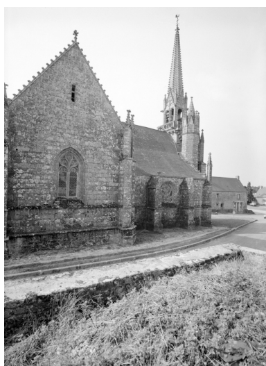
Mur nord de la nef.
