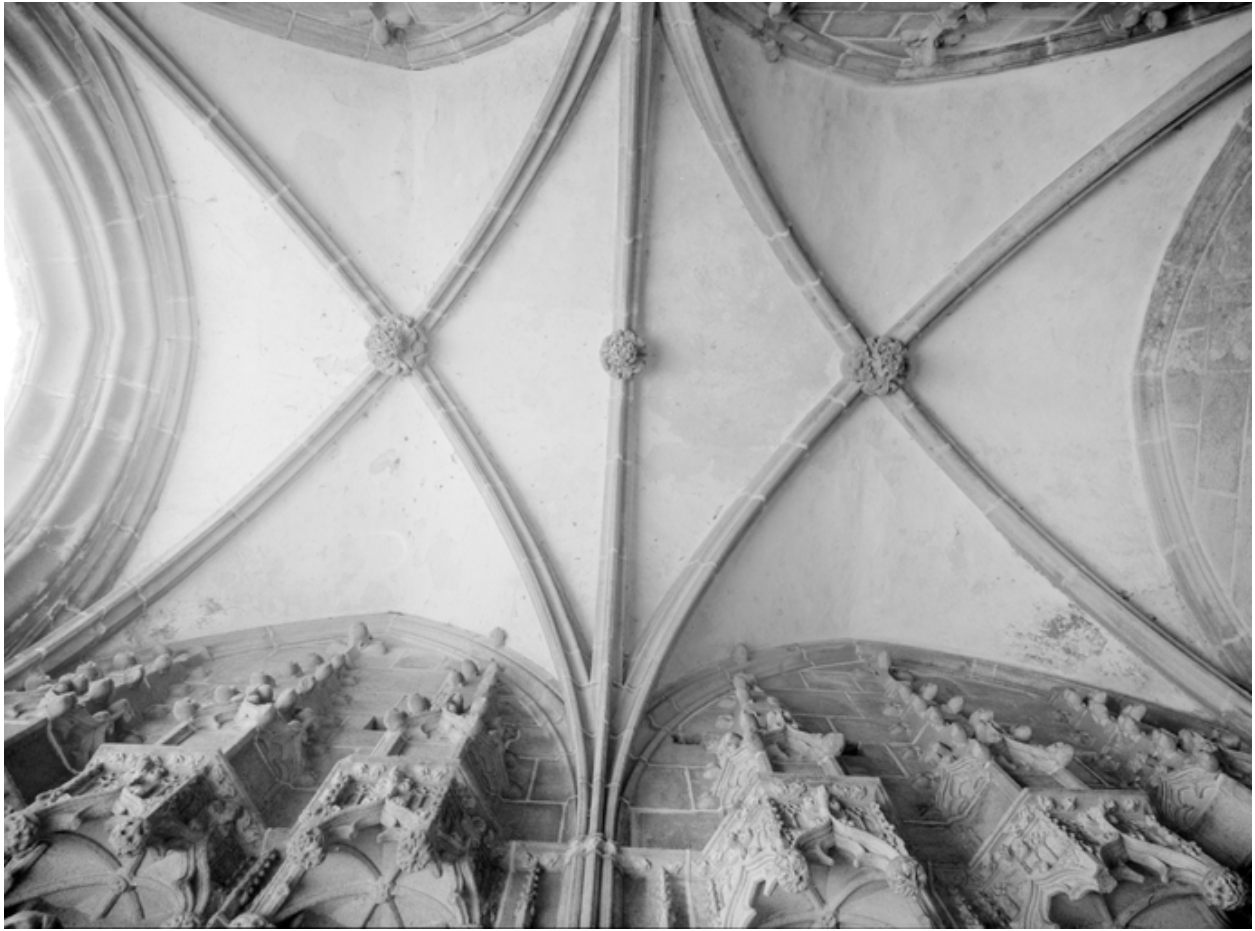
Porche sud de la nef, voûtes.
