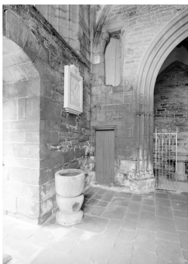
Nef, angle nord-ouest, porte d'accès à la tour d'escalier ; au-dessus, porte d'accès pour une tribune. Phot. François Dagorn IVR53_19675600427V
