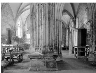
Pilier massif nord-ouest, bases de colonnettes. Phot. François Dagorn IVR53_19675600492V
