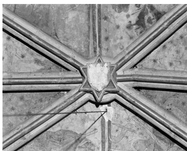
Ecu, croisée de la troisième travée du chœur. Phot. François Dagorn IVR53_19675601605X
