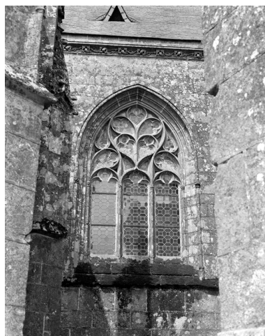
Façade sud, détail de la fenêtre de la nef (entre le porche et le bras de transept).
