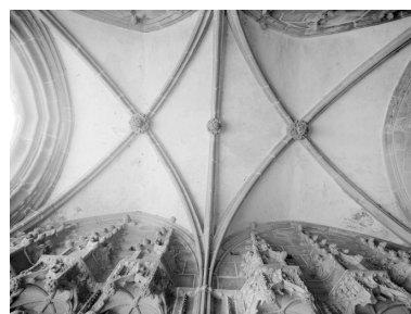
Porche sud de la nef, voûtes. Phot. François Dagorn IVR53_19675600433V
