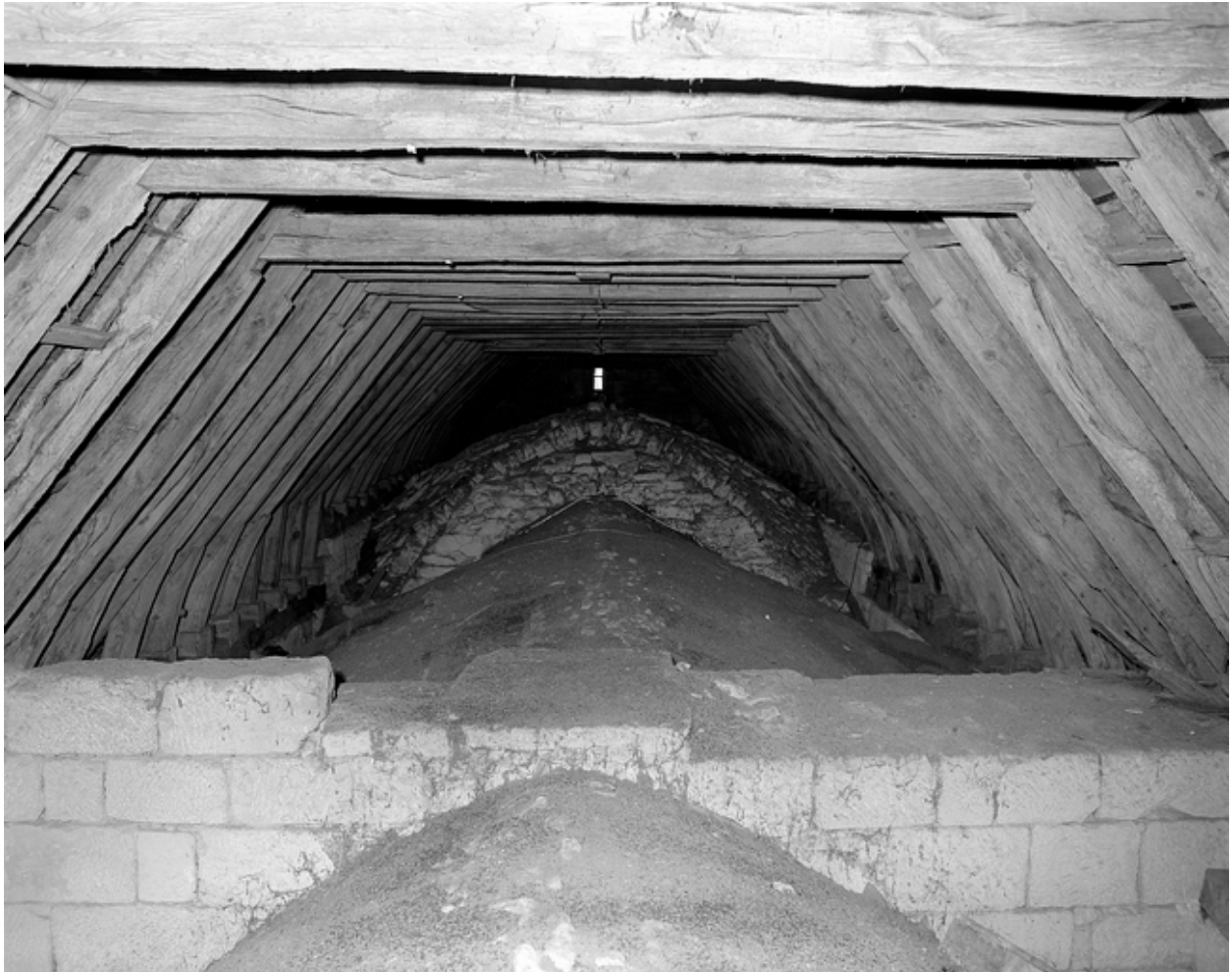
Vue générale de l'extrados des voûtes.
