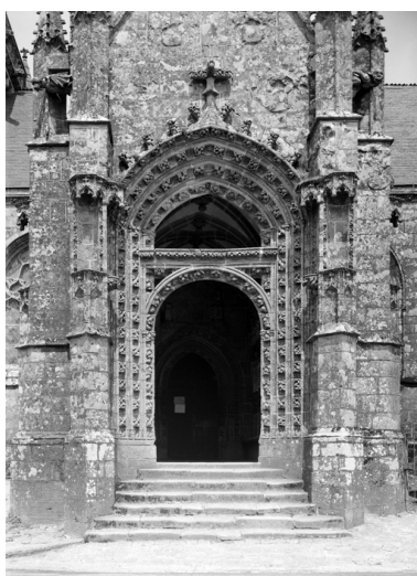
Vue axiale du porche de la nef. Phot. François Dagorn IVR53_19675600453V
