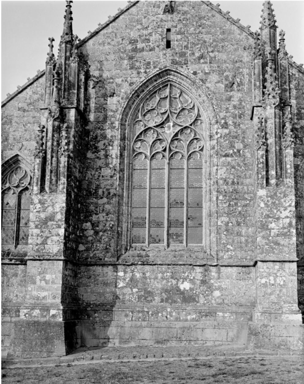
Façade est, détail de la maîtresse-vitre.
