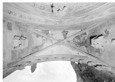
La voûte du porche du choeur. Phot. François Dagorn IVR53_19675600441V
