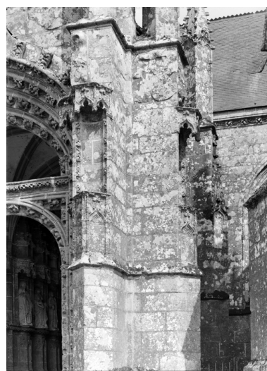
Niches extérieures du porche de la nef. Phot. François Dagorn IVR53_19675600468V
