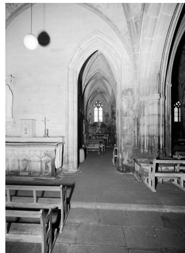
Bas-côté nord (vers l'est). Phot. François Dagorn IVR53_19675600482V
