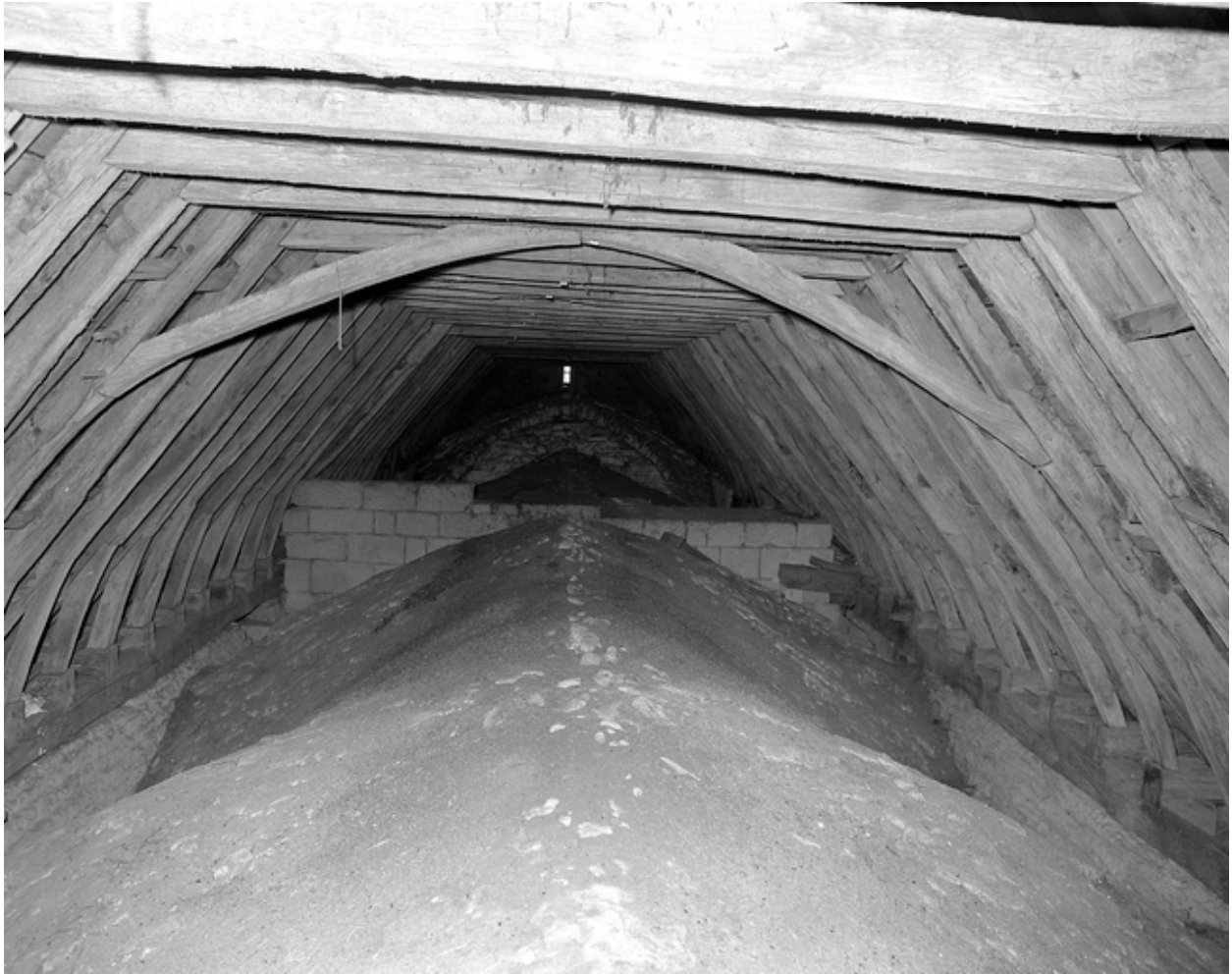
Vue générale de l'extrados des voûtes et de la charpente.
