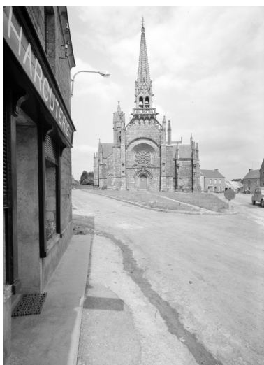
Vue générale éloigné depuis l'ouest Phot. François Dagorn IVR53_19675600451V
