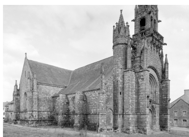
Vue de l'angle nord-est avec la tourelle d'accès au clocher. Phot. François Dagorn IVR53_19675600466V
