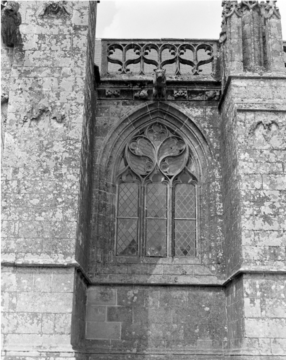
Façade sud, détail de la fenêtre du choeur, deuxième travée.
