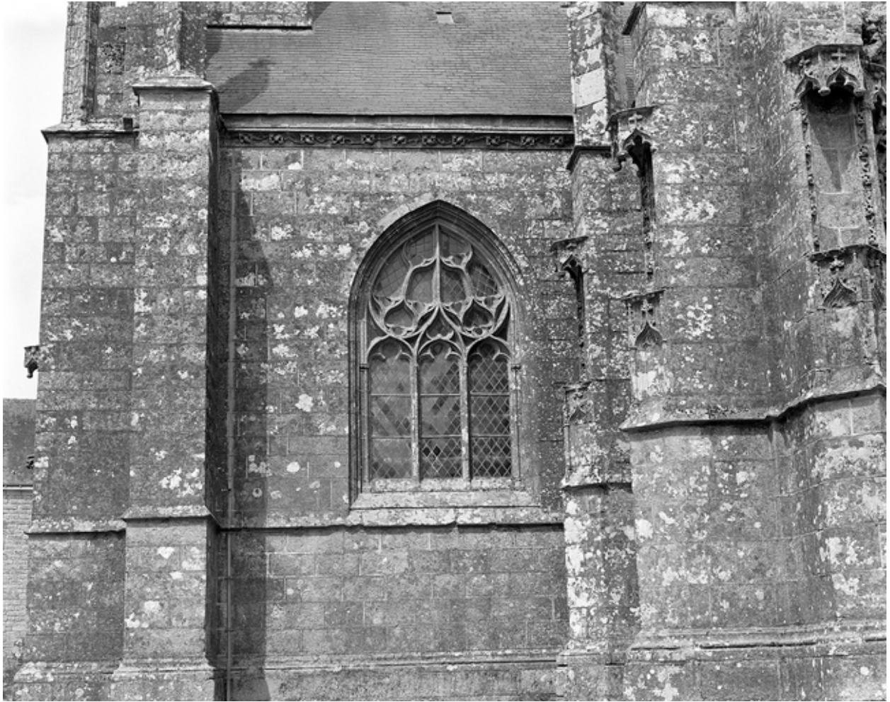
Façade sud, détail de la fenêtre de la nef (à l'ouest du porche).
