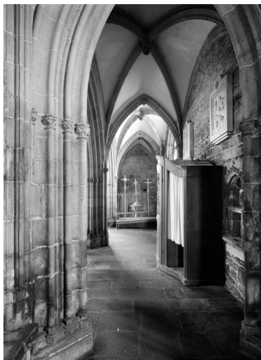
Bas-côté nord (vers l'ouest). Phot. François Dagorn IVR53_19675600481V
