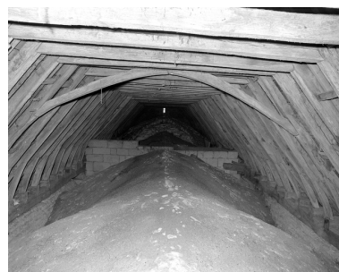
Vue générale de l'extrados des voûtes et de la charpente. Phot. Guy Artur IVR53_19765600157X
