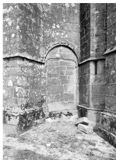
Porte murée du collatéral nord dans la façade ouest. Phot. François Dagorn IVR53_19675600463V
