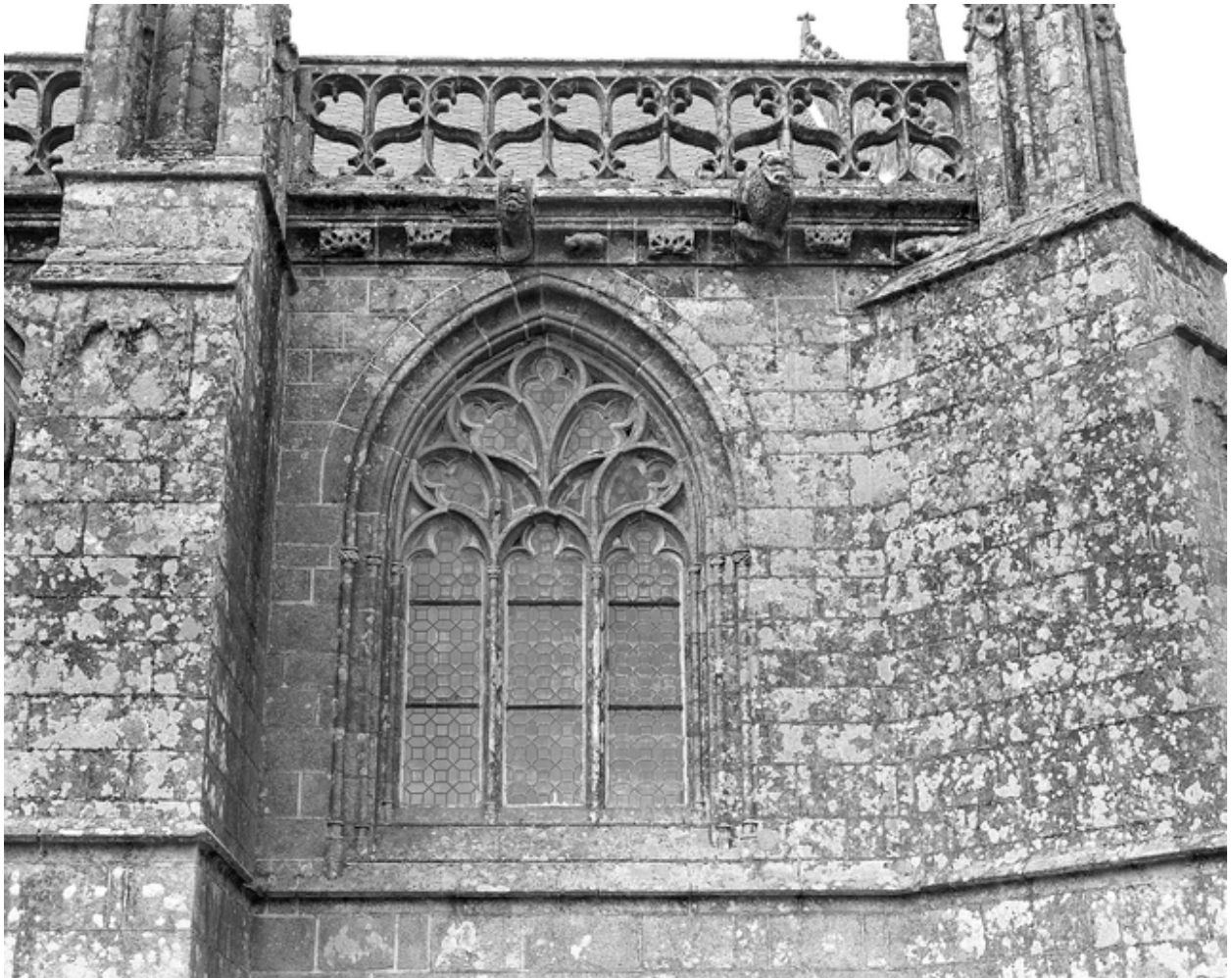
Façade sud, détail de la fenêtre du choeur, troisième travée.
