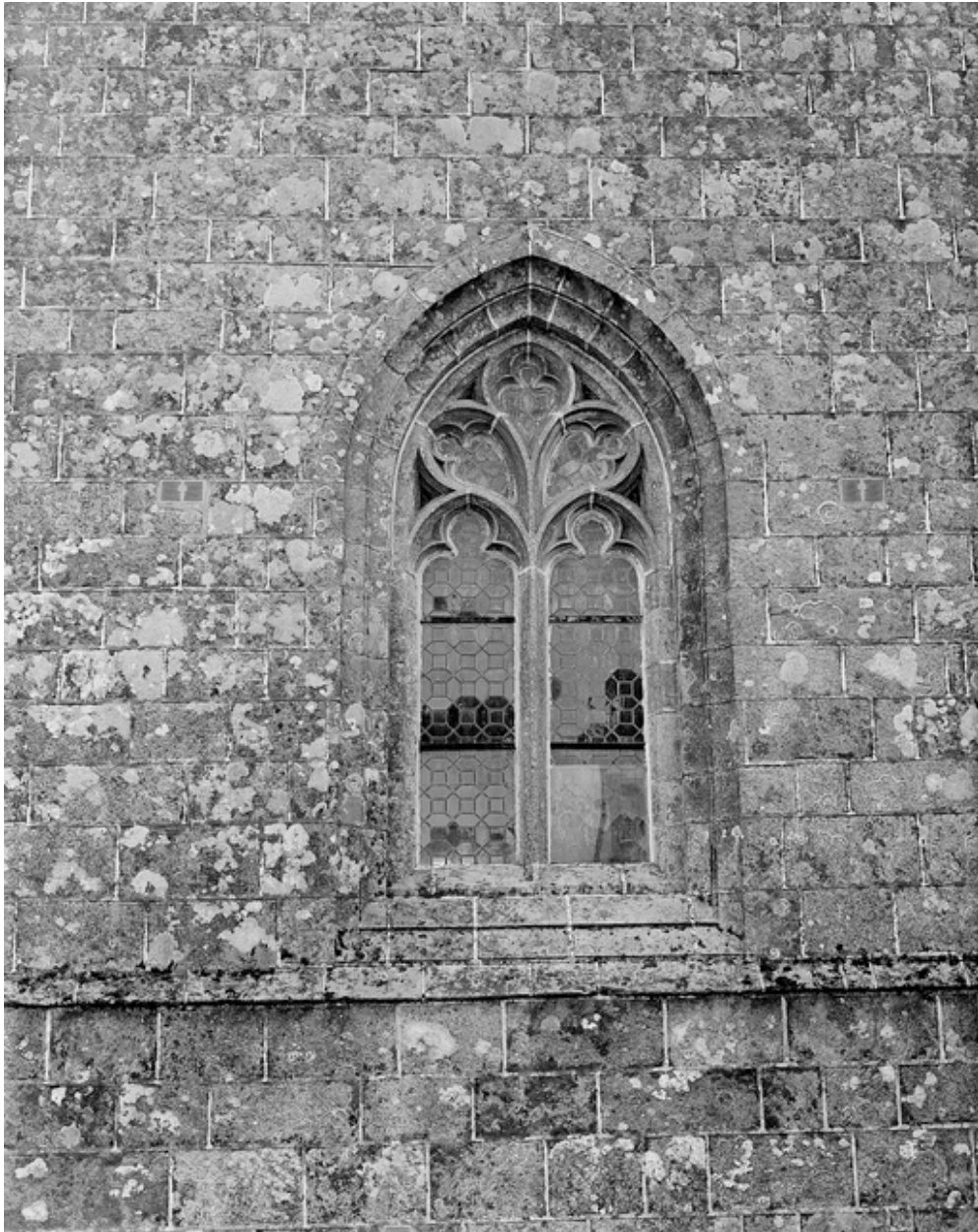
Façade nord, détail de la fenêtre du bras nord du transept.
