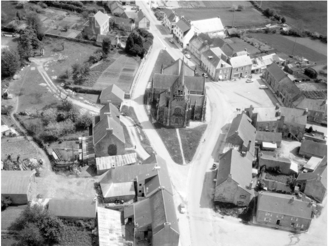
Vue générale prise de l'ouest.
