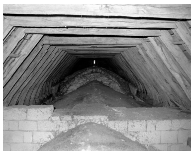
Vue générale de l'extrados des voûtes. Phot. Guy Artur IVR53_19765600158X
