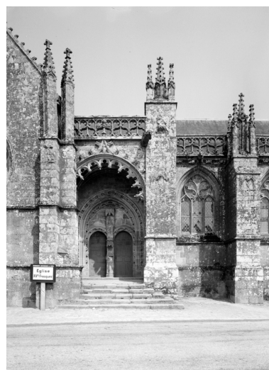
Porche du choeur. Phot. François Dagorn IVR53_19675600458V
