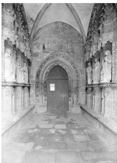
Porche sud de la nef, vue axiale.
