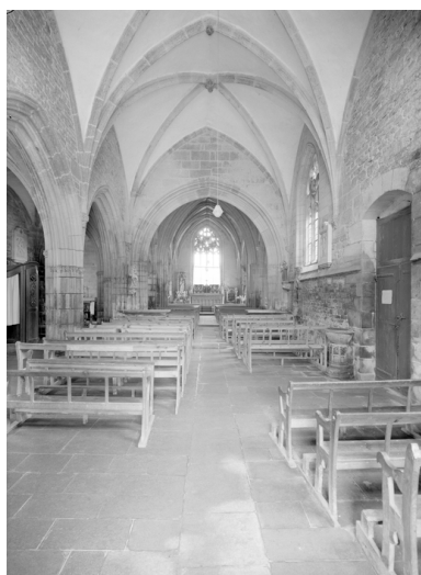
Intérieur, vue axiale d'ouest en est. Phot. François Dagorn IVR53_19675600417V
