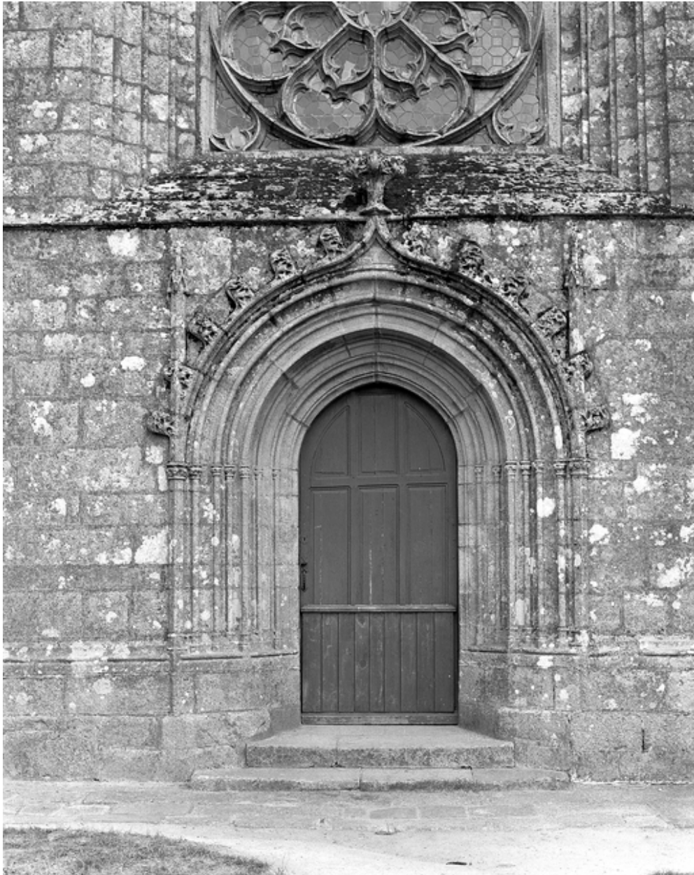
Façade ouest, portail.
