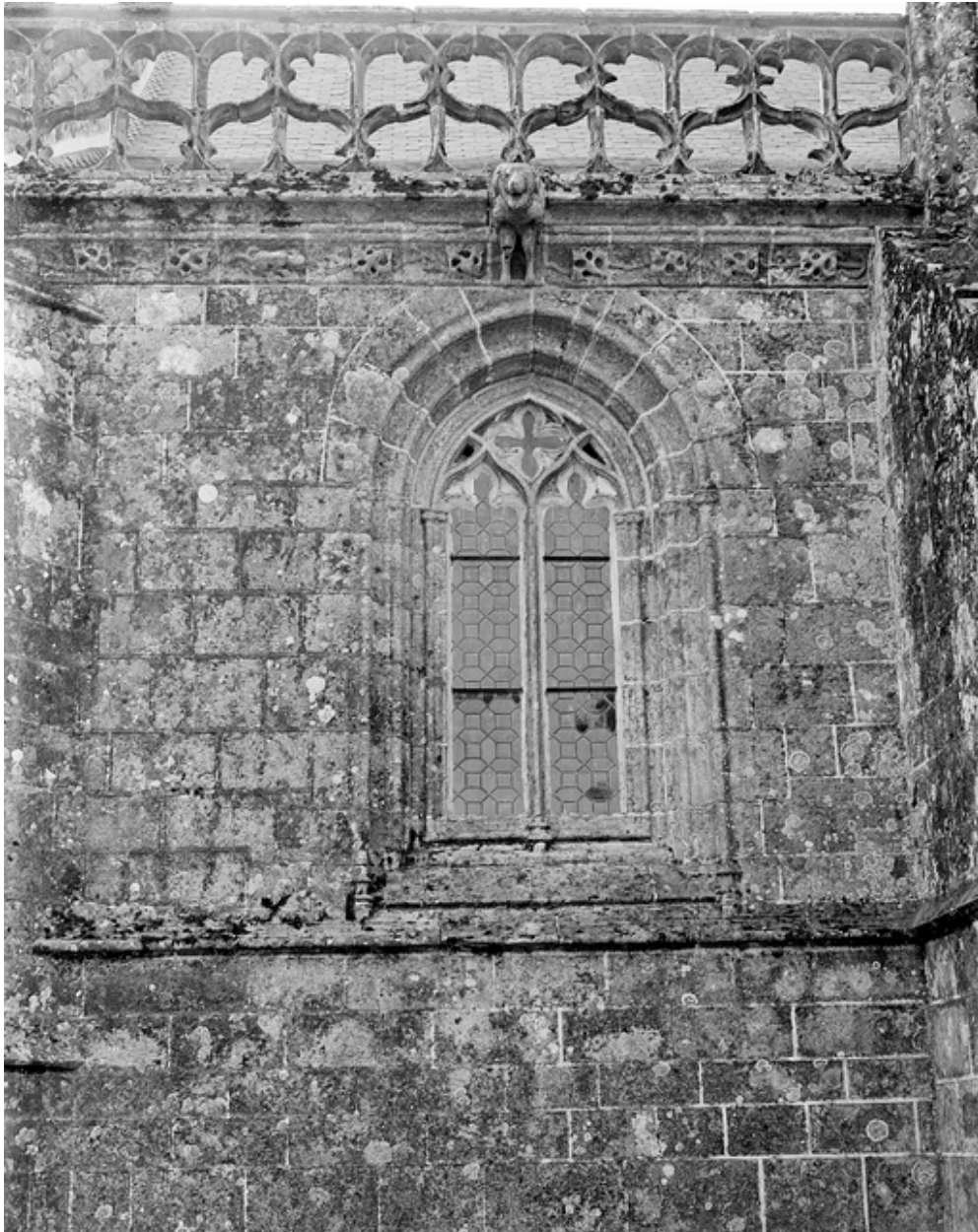
Façade nord, détail de la fenêtre du choeur, troisième travée.
