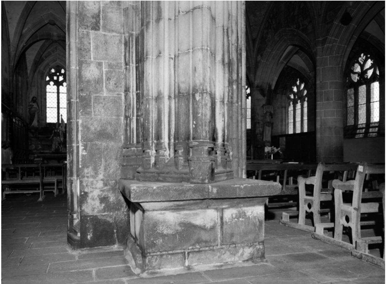
Pilier massif nord-est, bases de colonnettes.
