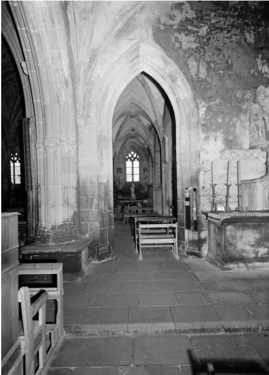
Bas-côté sud (du mur ouest).
