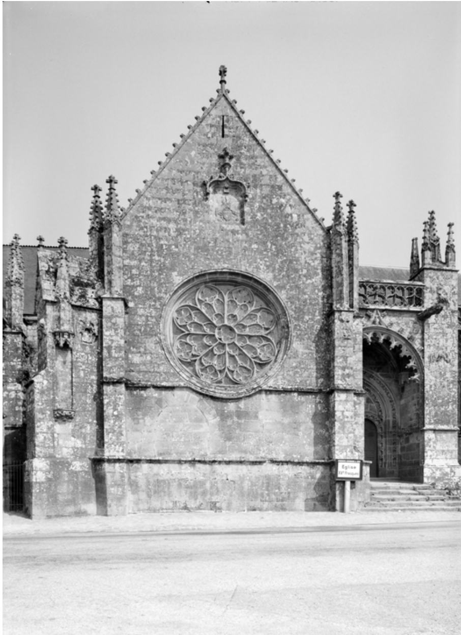
Pignon du bras sud du transept.
