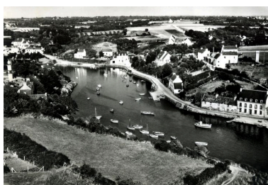
Espace portuaire de Doëlan dans les années 1950 Repro. Johan Vincent, Autr. Auteur inconnu IVR53_20092909048NUCB
