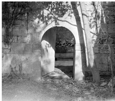
Bras Sud du transept (état en 1974).
