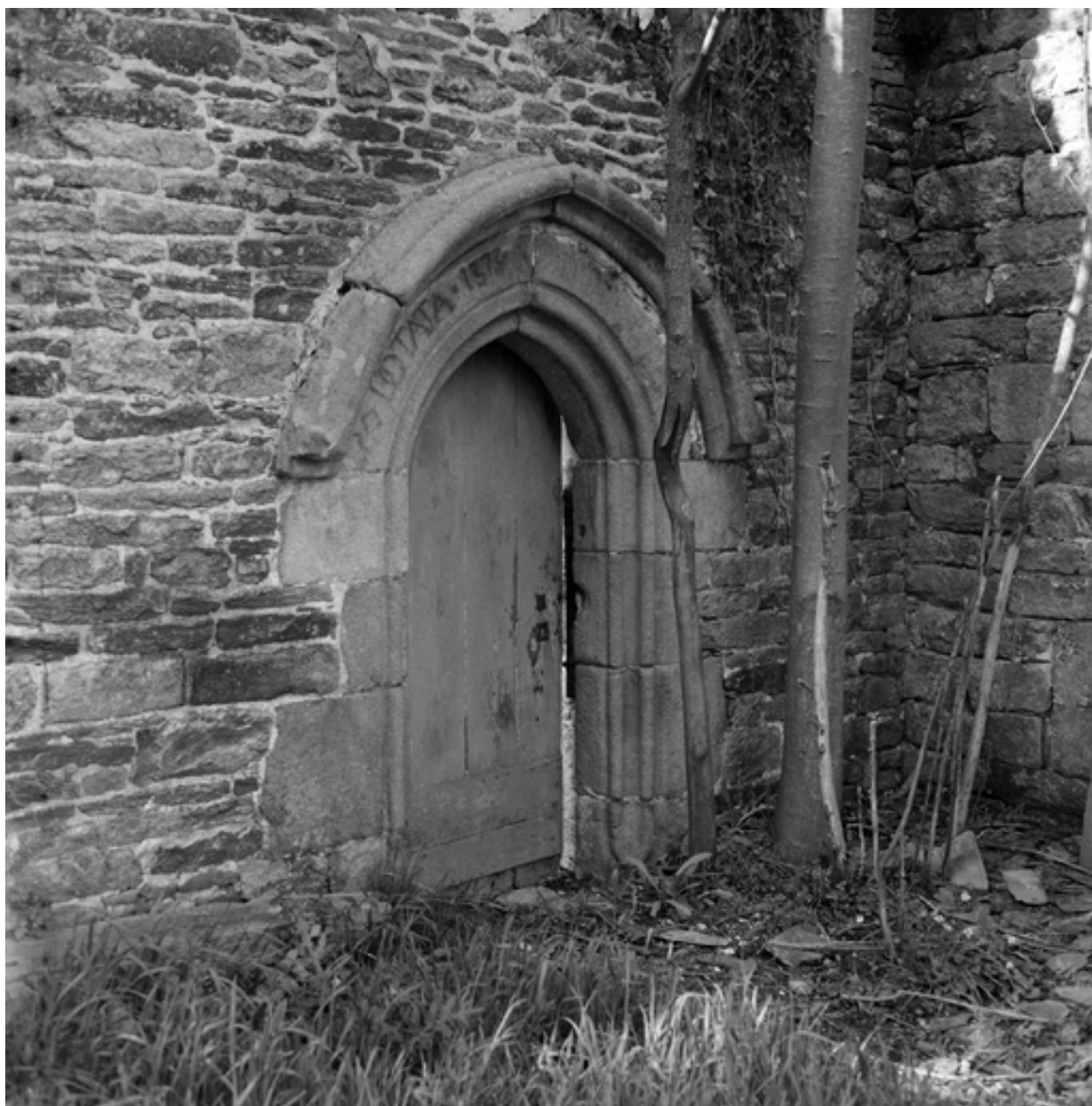
Elévation Sud, détail : porte (état en 1974).
