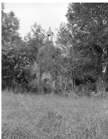
Vue générale ouest
