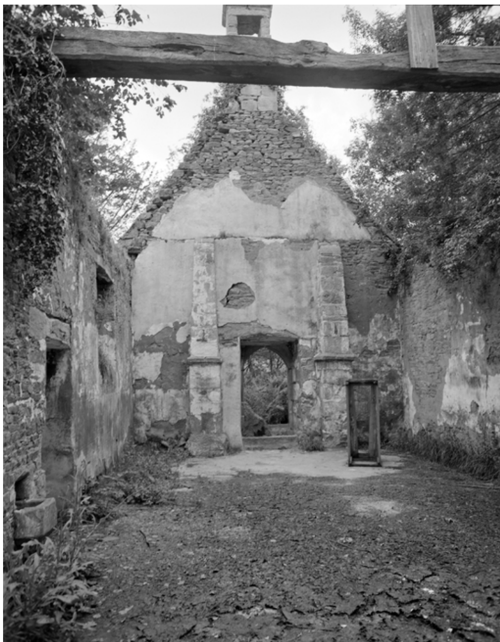
Vue générale d'est en ouest
