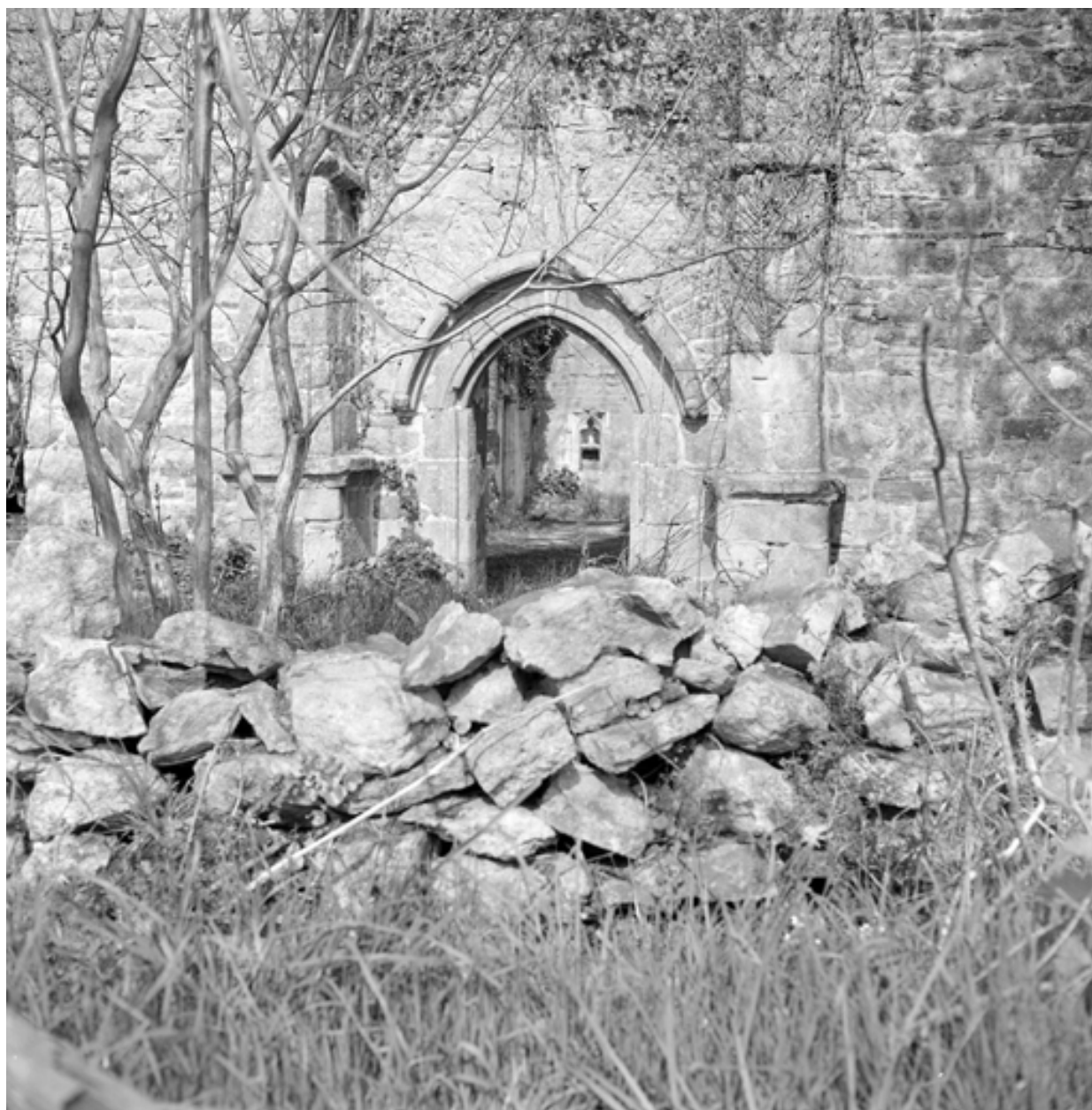
Elévation Ouest, détail : porte (état en 1974).
