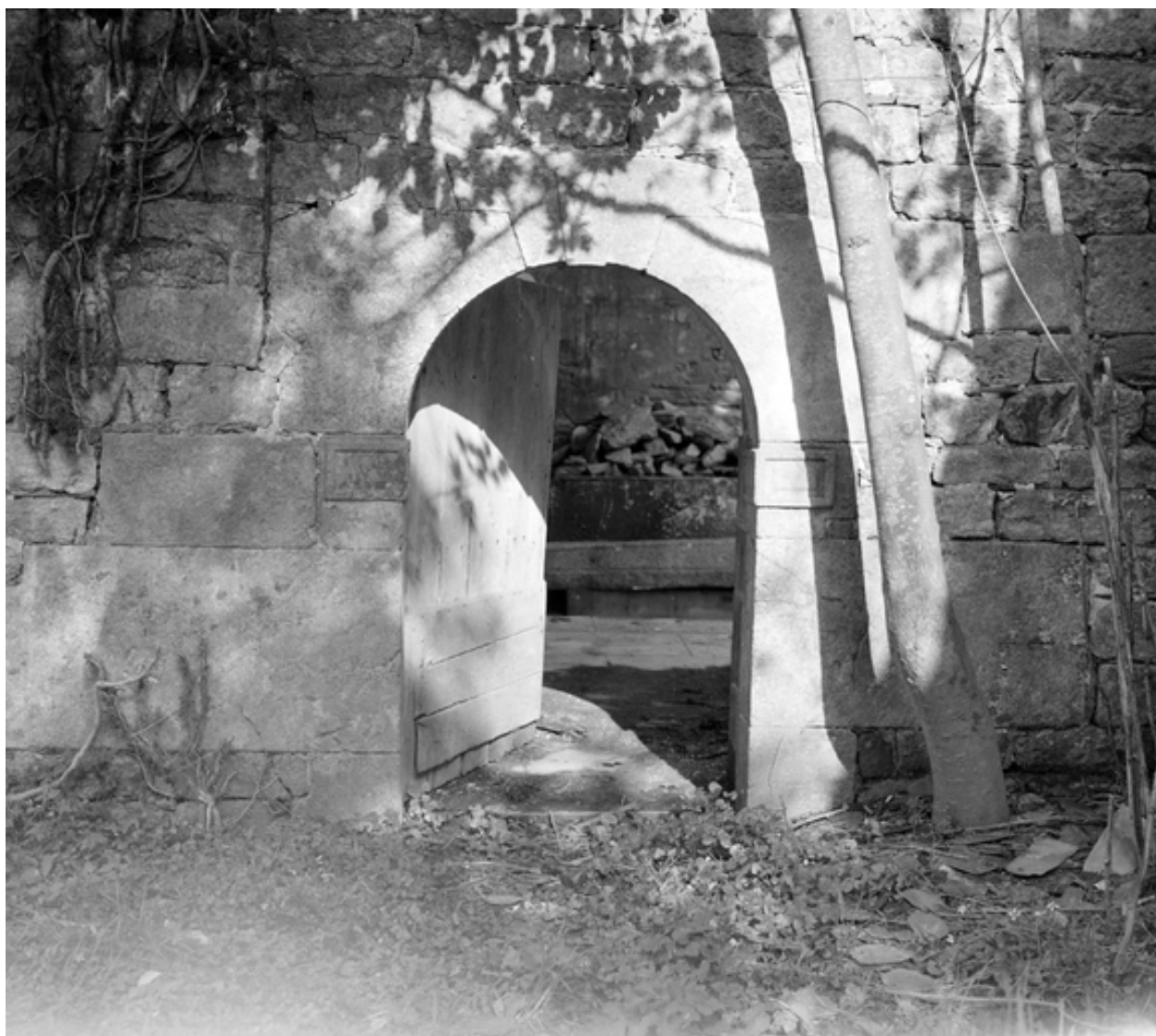
Bras Sud du transept (état en 1974).
