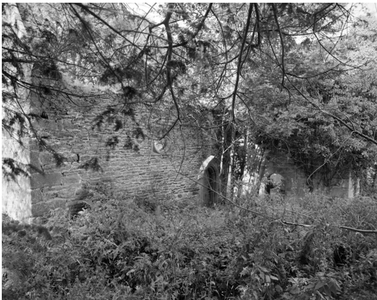
Mur sud de la nef
