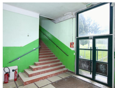
Cage d'escalier nord-ouest, internat de garçons (1954), désaffecté. Palier du rez-de-chaussée, amorce de l'escalier, porte d'entrée. Les matériaux d'origine ont été conservés, y compris pour le second œuvre. Phot. Bernard Bègne IVR53_20195600445NUCA
