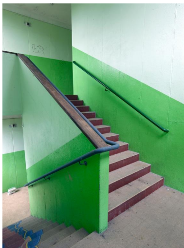
Cage d'escalier nord-ouest, internat de garçons (1954), désaffecté. Phot. Bernard Bègne IVR53_20195600442NUCA
