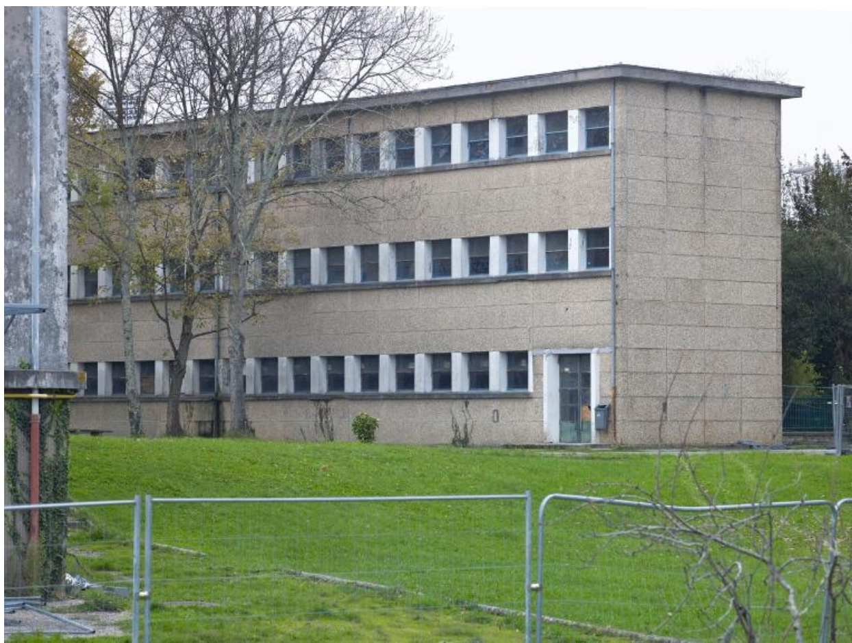
Façade arrière de l'externat B2 (désaffecté), prise depuis le pignon des logements (externat B1).
