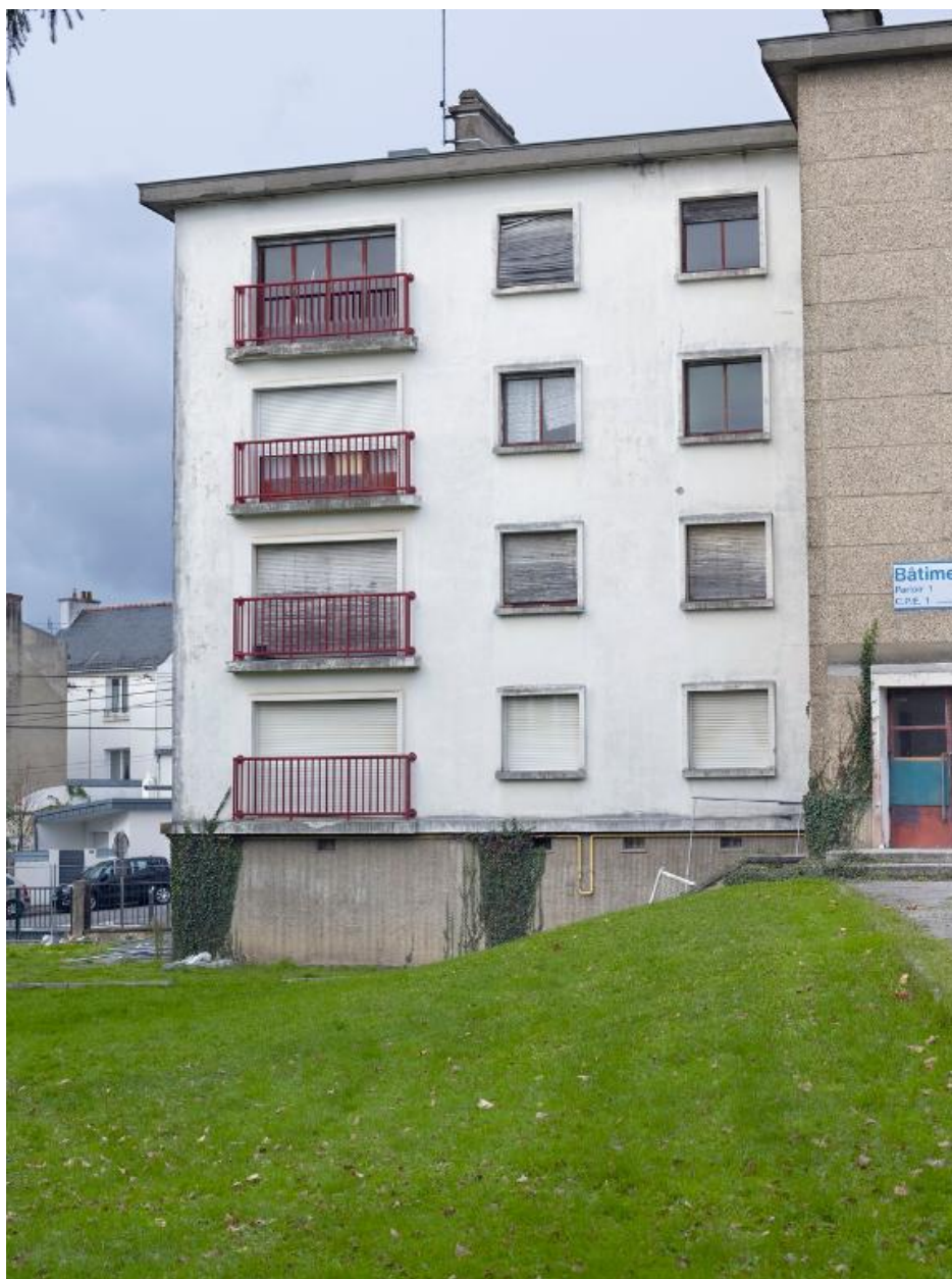
Façade sud-est avant de l'externat 1 (désaffecté). La barre se prolonge par 4 niveaux de logements.
