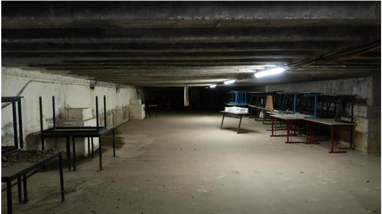
Sous-sol d'un externat désaffecté (G. Tourry, architecte). Poutres en béton et fondations spéciales (le lycée est construit sur une zone meuble).
