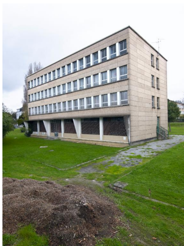
Internat garçons n°1, façade sud-ouest. Au rez-de-chaussée, auvent brise soleil des salle d'études et de jeux bruyants. Phot. Bernard Bègne IVR53_20195600560NUCA
