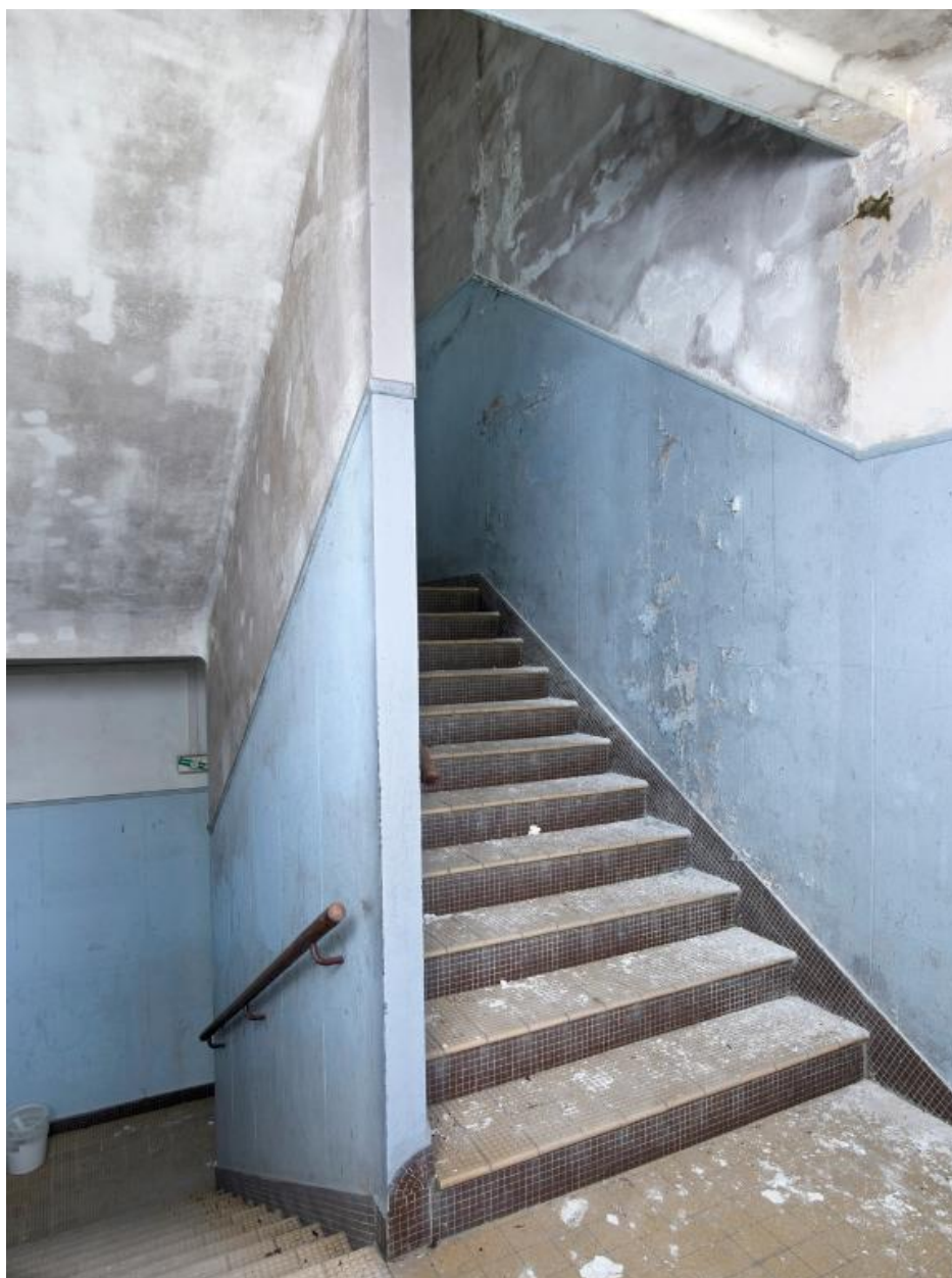
Externat B2 (désaffecté) : cage d'escalier.
