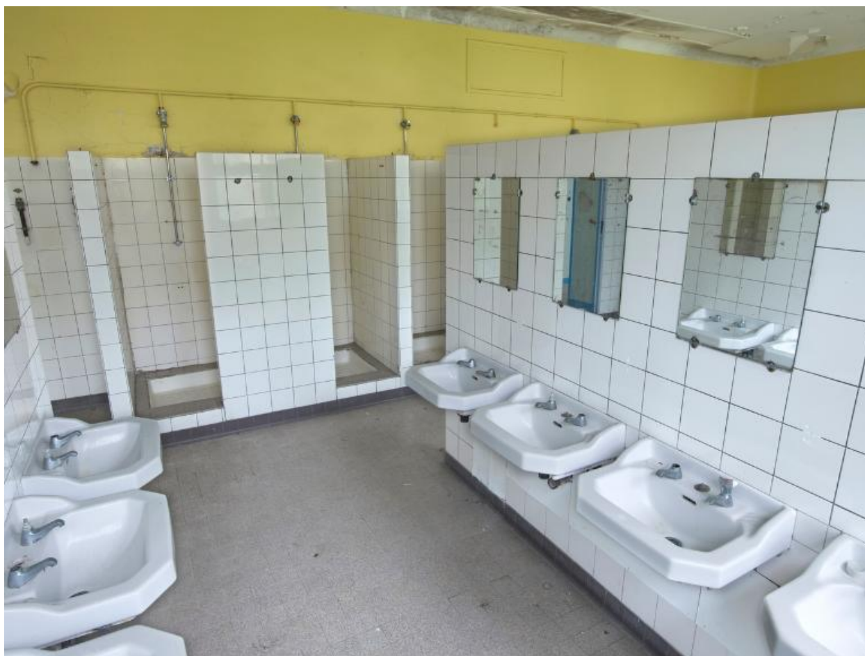
Douches et lavabos, internat de garçons (1954), désaffecté.
