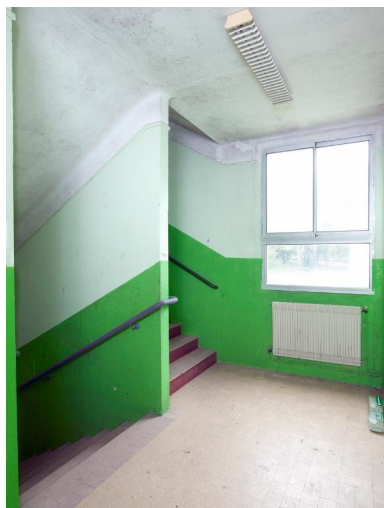
Cage d'escalier nord-ouest, internat de garçons (1954), désaffecté. Noter l'éclairage latéral du palier. Phot. Bernard Bègne IVR53_20195600441NUCA
