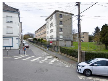
Le long de la rue Professeur Mazé, façade nord-ouest de l'externat 1 (désaffecté). Au premier plan, les 4 niveaux de logements. Phot. Bernard Bègne IVR53_20195600542NUCA
