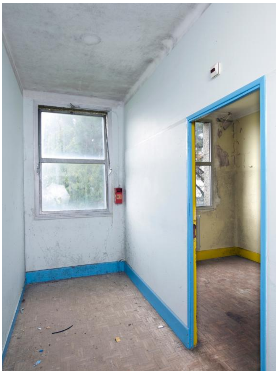
Dégagement de desserte central, éclairé par une baie en pignon, et entrée d'une chambre. Internat de garçons (1954) désaffecté.
