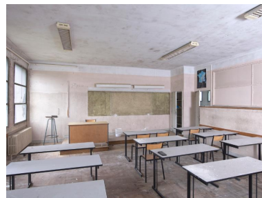
Externat B2 (désaffecté) : salle de classe au sol en parquet, avec estrade, encore meublée : noter entre autres le support de rétroprojecteur et les rangées d'éclairage néon.
