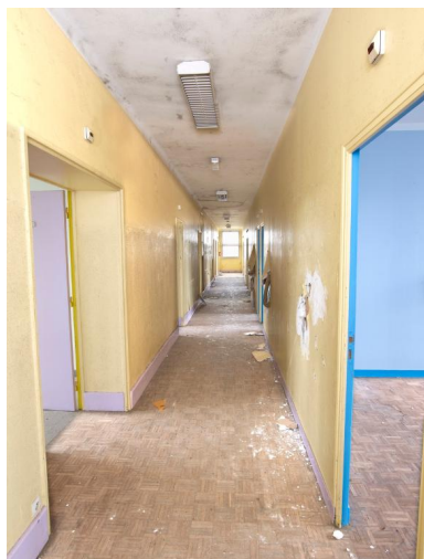
Couloir de desserte central, internat de garçons (1954) désaffecté. Phot. Bernard Bègne IVR53_20195600444NUCA
