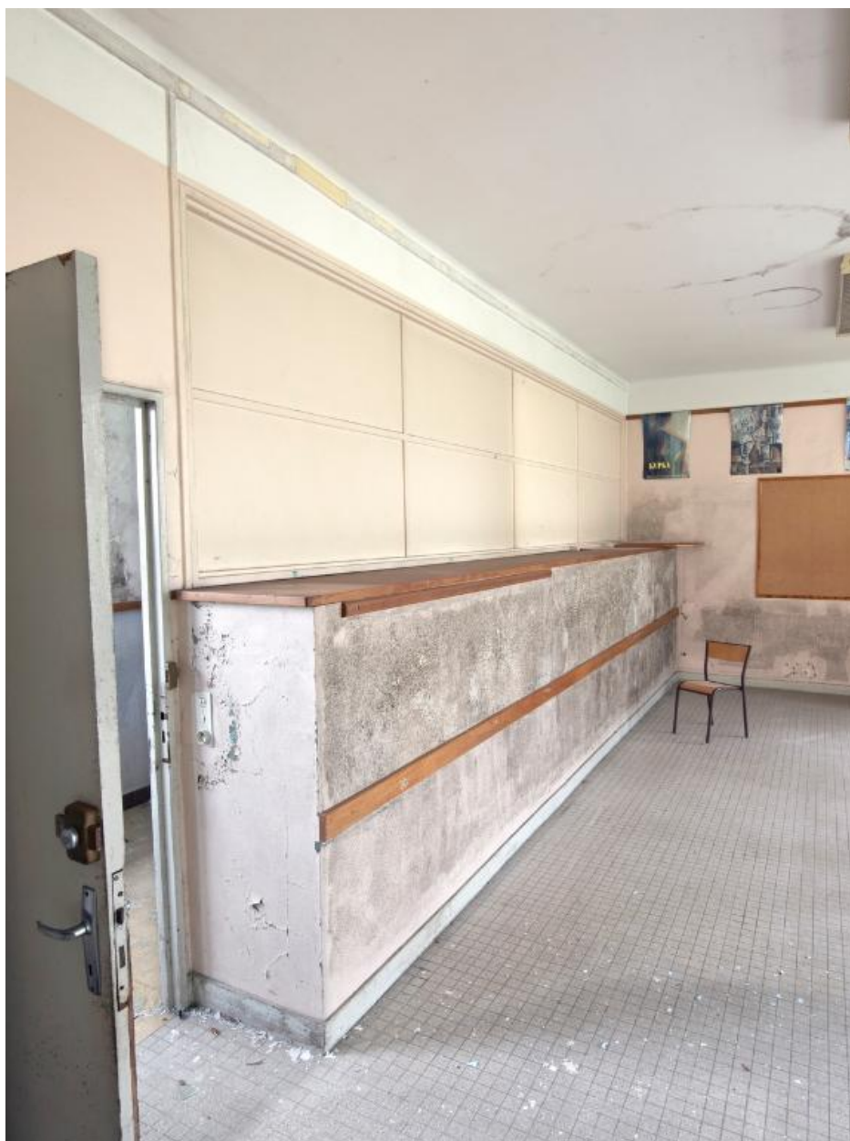
Cloison latérale d'une salle de classe, externat B2 désaffecté. Le renforcement des vestiaires, côté couloir, forme étagère, côté classe. Noter qu'il s'agissait d'une salle carrelée de grès gris, ainsi que l'occultation des baies hautes.
