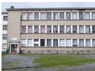
Façade sud-est avant de l'externat 1 (désaffecté). A gauche, l'amorce des 4 niveaux de logements. Noter, entre autres, le second œuvre d'origine. L'auvent en béton de l'entrée a été supprimé. Phot. Bernard Bègne IVR53_20195600541NUCA
