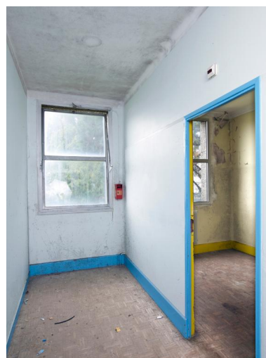
Dégagement de desserte central, éclairé par une baie en pignon, et entrée d'une chambre. Internat de garçons (1954) désaffecté. Phot. Bernard Bègne IVR53_20195600440NUCA
