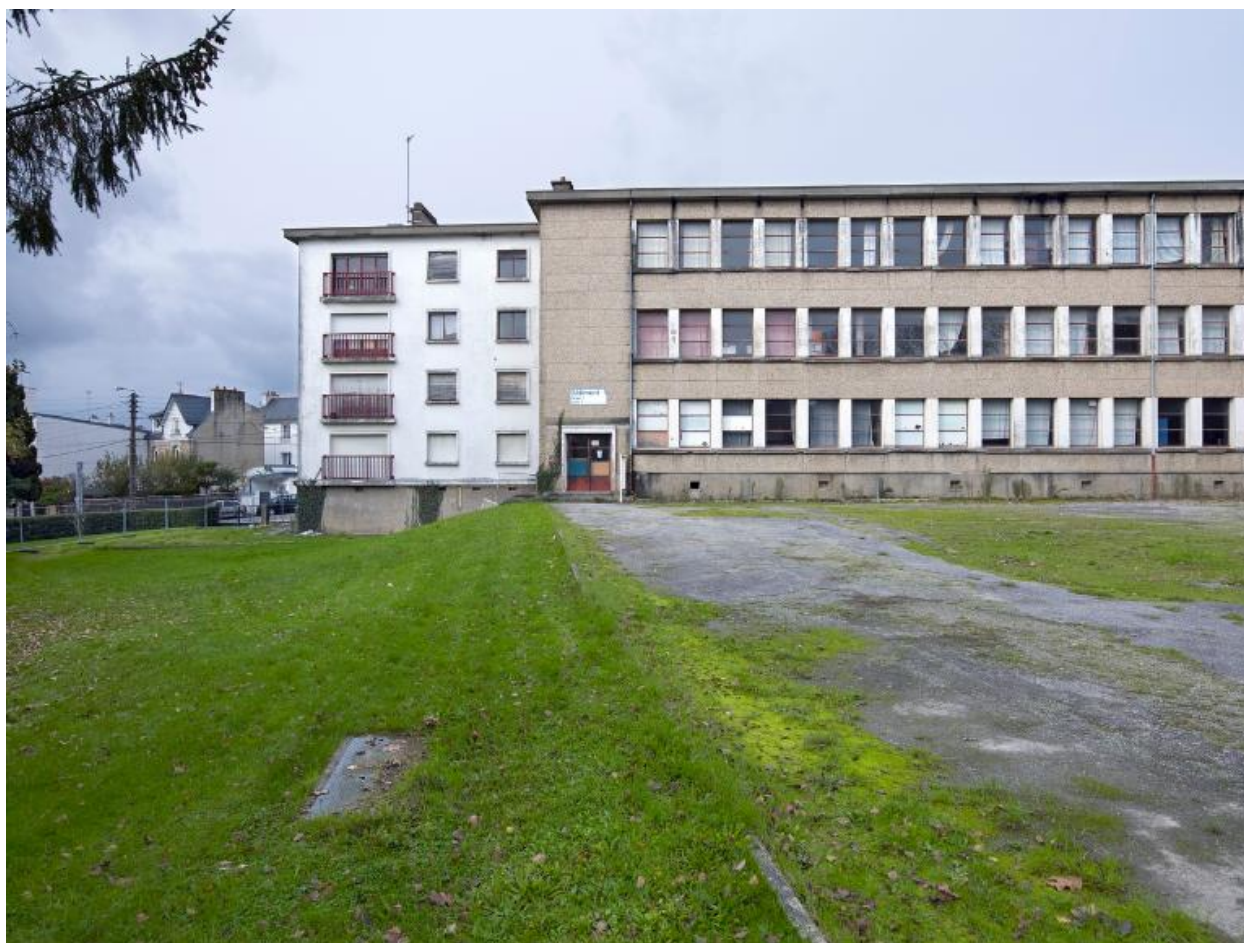
Façade sud-est avant de l'externat 1 (désaffecté). A gauche, 4 niveaux de logements. Noter, entre autres, le second œuvre d'origine.
