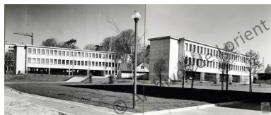
Deux externats du lycée (G. Tourry, architecte). Entre les nouveaux bâtiments, une baraque. IVR53_20185606655X
