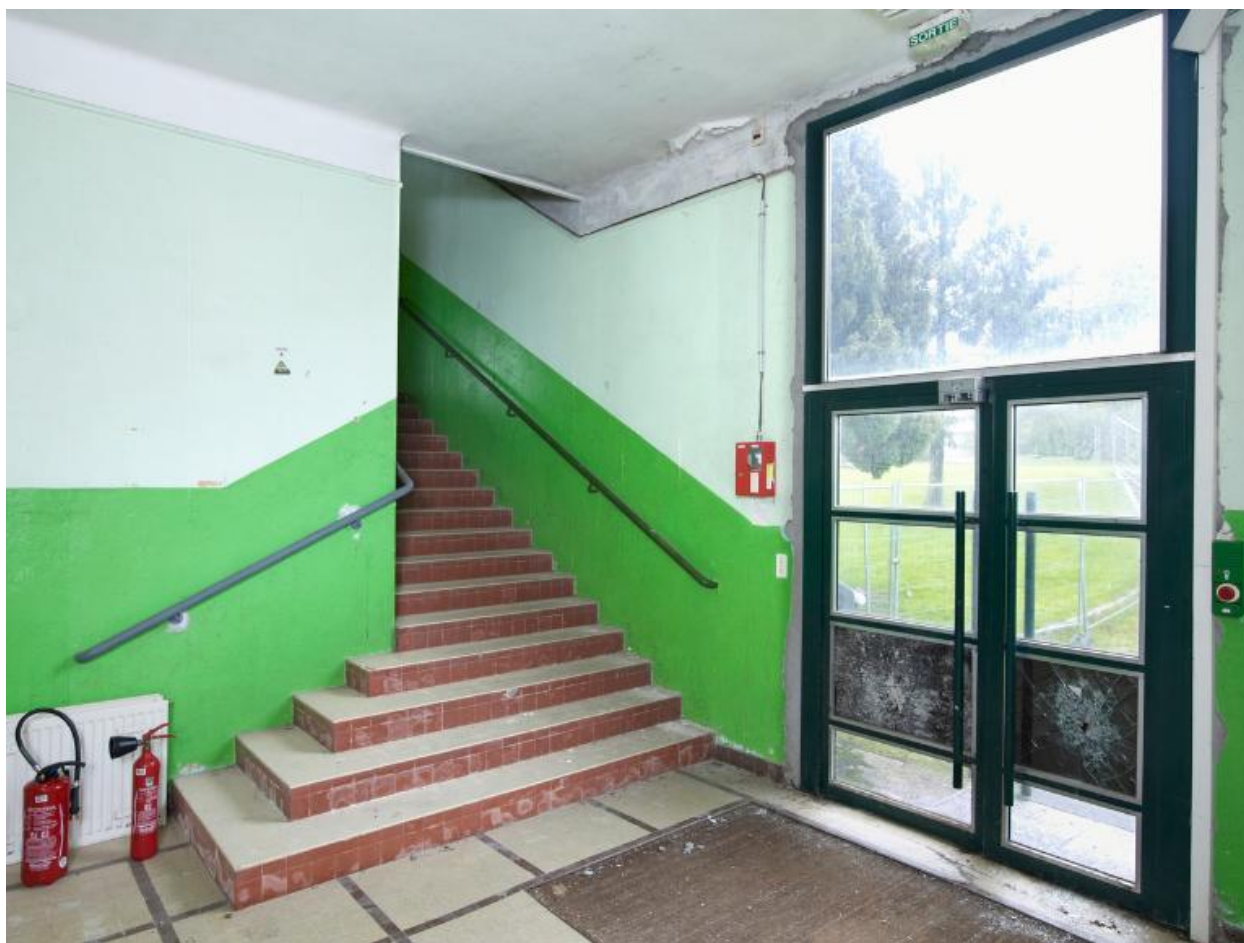
Cage d'escalier nord-ouest, internat de garçons (1954), désaffecté. Palier du rez-de-chaussée, amorce de l'escalier, porte d'entrée. Les matériaux d'origine ont été conservés, y compris pour le second œuvre.
