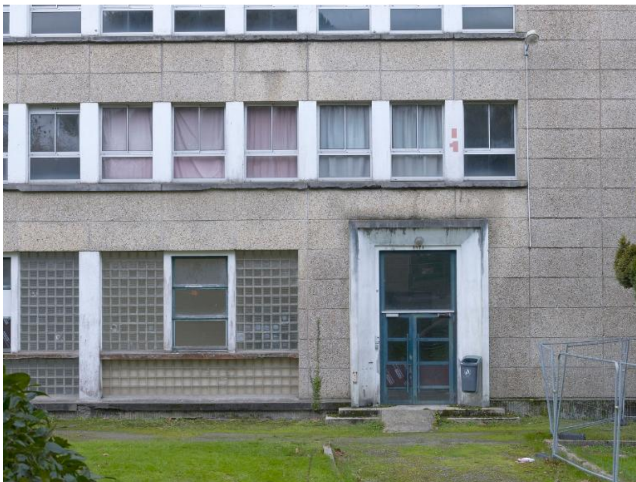
Internat garçons n°1, façade nord-est. Au rez-de-chaussée, les verrière en pavés de verre de la salle de jeux tranquilles. Détail sur l'entrée.
