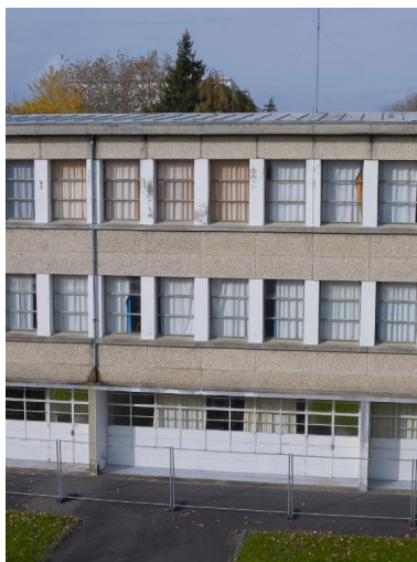
Détail de la façade avant (sud-est) d'un externat désaffecté. La trame d'1,75 mètres et l'affectation du rez- de-chaussée à des salles d'étude ou
