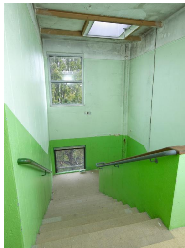
Cage d'escalier nord-ouest, internat de garçons (1954), désaffecté. Phot. Bernard Bègne IVR53_20195600443NUCA
