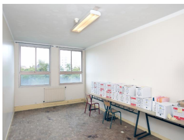
Chambre d'internes, internat de garçons (1954), désaffecté. Les cloisons ont été déplacées. A l'origine, les chambres étaient cloisonnées pour 6 lits, toutes les 3 trames de 1,75m (ici 2 trames). Phot. Bernard Bègne IVR53_20195600439NUCA
