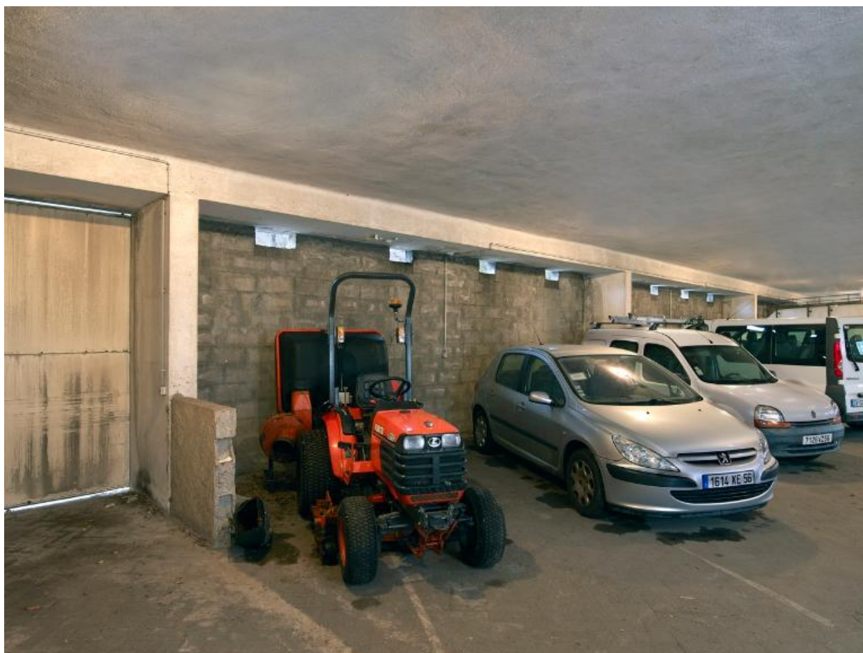
Rez-de-chaussée de l'externat B2, transformé en garage.
