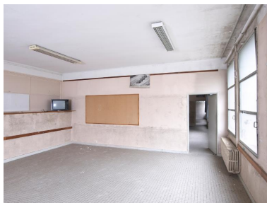
Externat B2 (désaffecté), salle de classe. Vue prise le long de la façade sud-est. Sols en grès gris, porte d'accès à la salle de classe en enfilade, poste de télévision.
