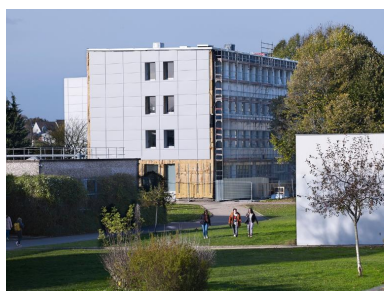
Internat garçons n°4 transformé en "espace langues", en cours de réhabilitation thermique. Pignon sud-est. Phot. Bernard Bègne IVR53_20195600563NUCA
