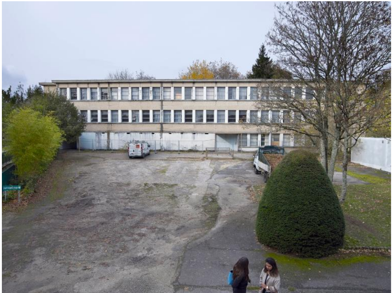
Vue d'ensemble de la façade arrière (sud-est) d'un externat désaffecté.
