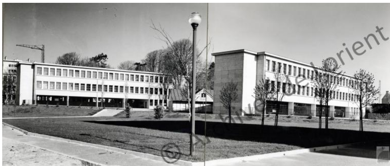
Deux externats du lycée (G. Tourry, architecte). Entre les nouveaux bâtiments, une baraque.
