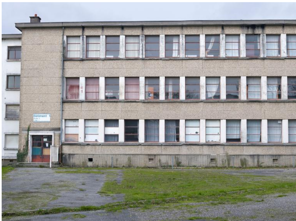
Façade sud-est avant de l'externat 1 (désaffecté). A gauche, l'amorce des 4 niveaux de logements. Noter, entre autres, le second œuvre d'origine. L'auvent en béton de l'entrée a été supprimé.
