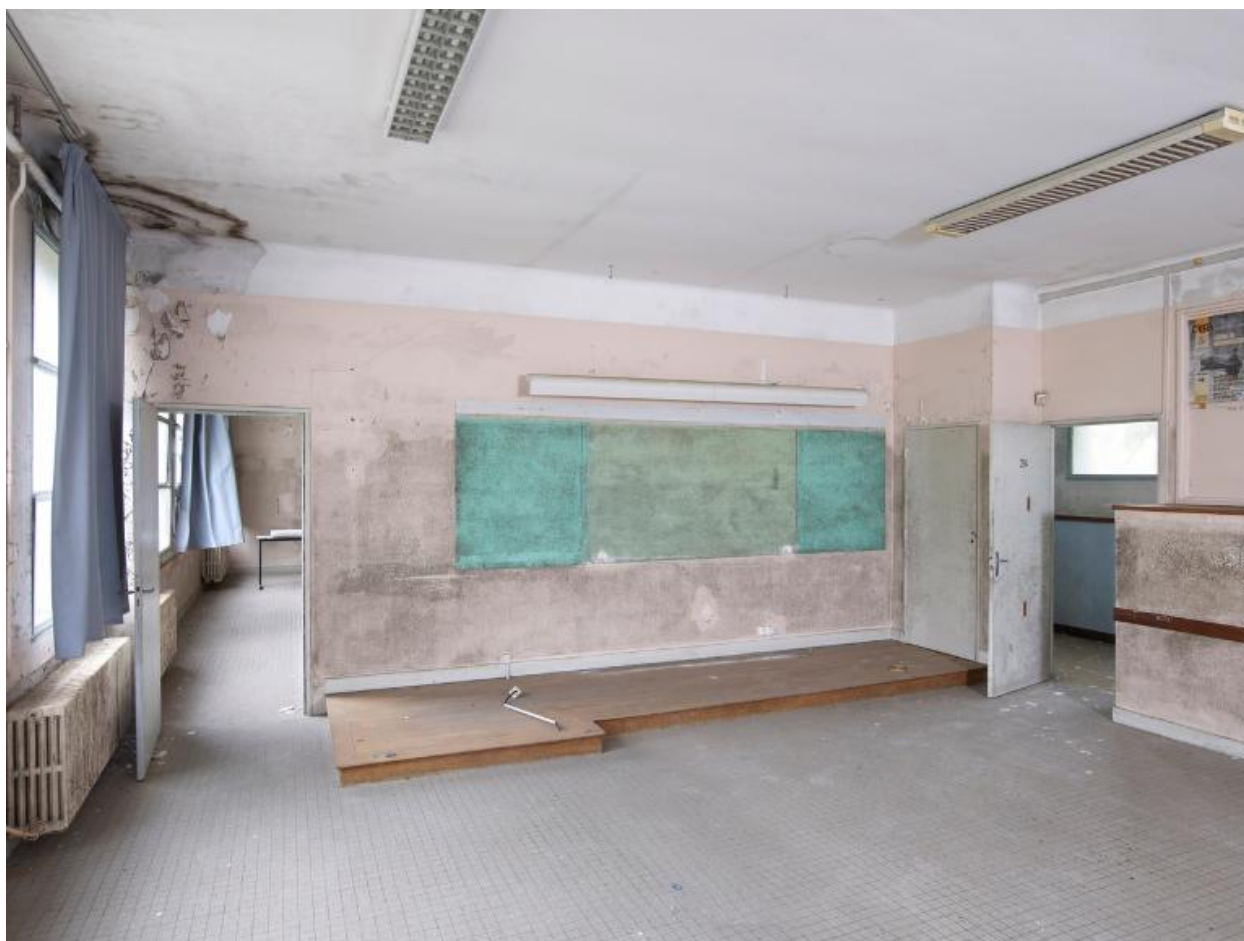
Vue d'ensemble d'une salle de classe dans l'externat B2 (désaffecté) : estrade, sol carrelé de grès gris, emplacement du tableau noir à 3 volets, radiateurs en fonte. Une porte donne accès au couloir, une deuxième à la salle de classe contigüe.
