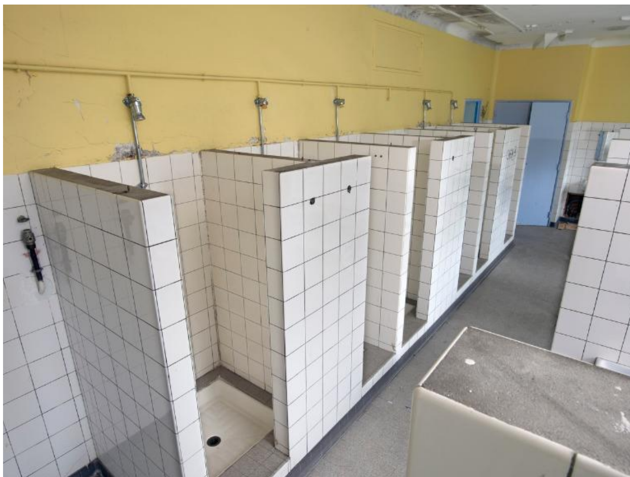
Douches et lavabos, internat de garçons (1954), désaffecté.
