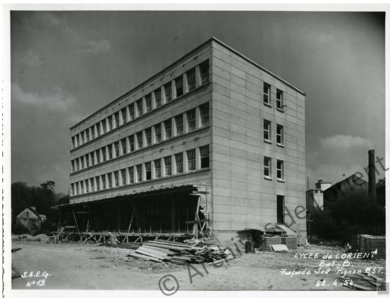
Internat en cours de construction (G. Tourry architecte).
