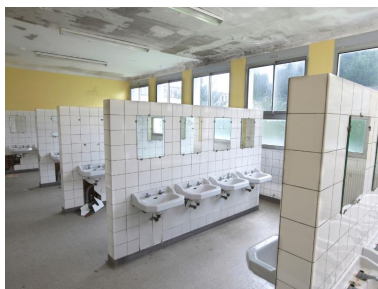
Douches et lavabos, internat de garçons (1954), désaffecté. Phot. Bernard Bègne IVR53_20195600436NUCA
