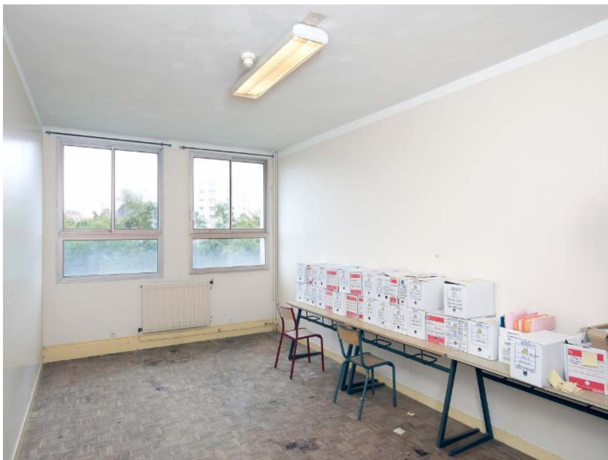
Chambre d'internes, internat de garçons (1954), désaffecté. Les cloisons ont été déplacées. A l'origine, les chambres étaient cloisonnées pour 6 lits, toutes les 3 trames de 1,75m (ici 2 trames).
