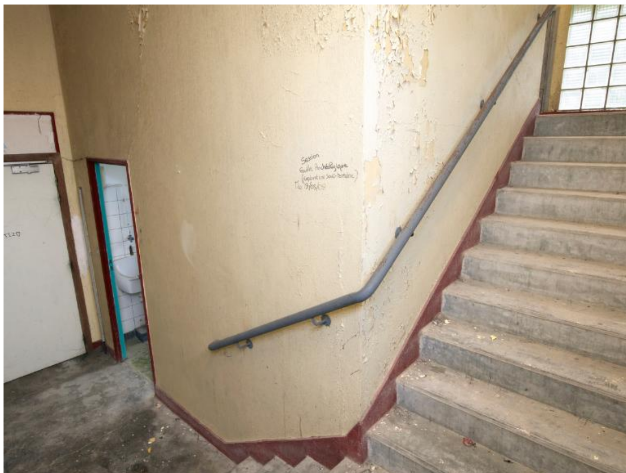
Cage d'escalier situé au sud-est, internat de garçons (1954), désaffecté.
