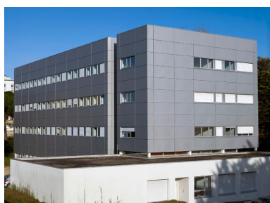
Internat garçons n°2, réhabilité (isolation extérieure, adjonction de l'aile au premier plan, Thierry Loison architecte). Phot. Bernard Bègne IVR53_20195600561NUCA
