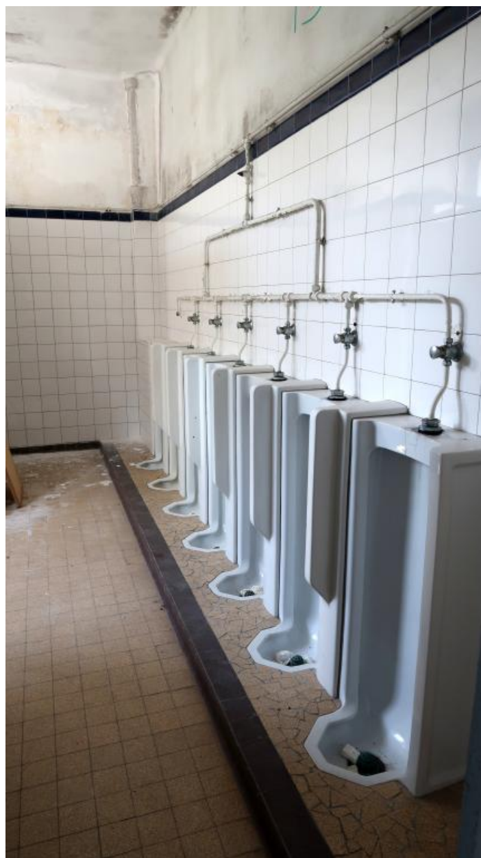
Externat désaffecté (G. Tourry, architecte) : WC des garçons.
