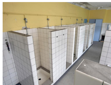
Douches et lavabos, internat de garçons (1954), désaffecté. Phot. Bernard Bègne IVR53_20195600437NUCA
