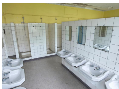
Douches et lavabos, internat de garçons (1954), désaffecté. Phot. Bernard Bègne IVR53_20195600438NUCA
