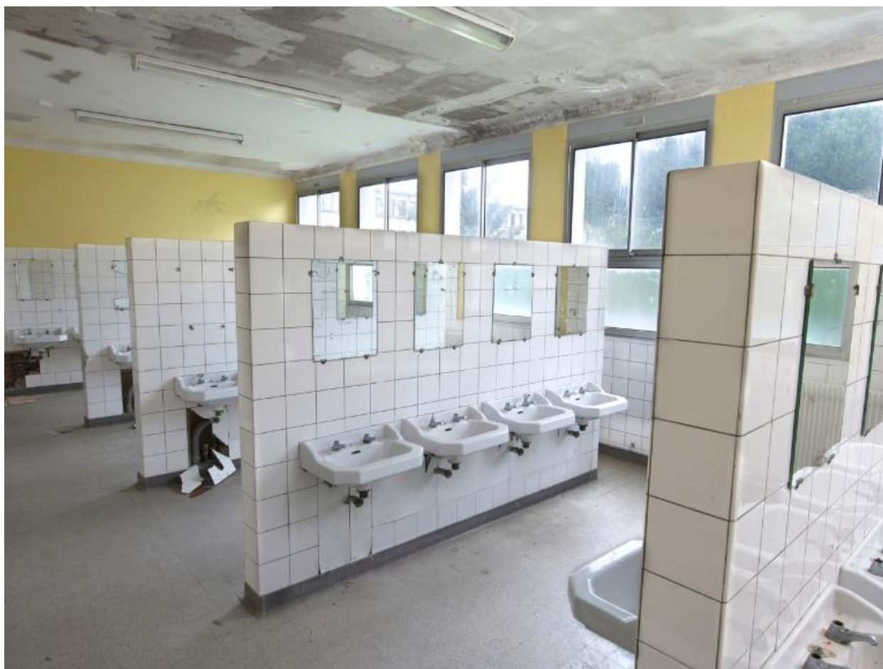
Douches et lavabos, internat de garçons (1954), désaffecté.
