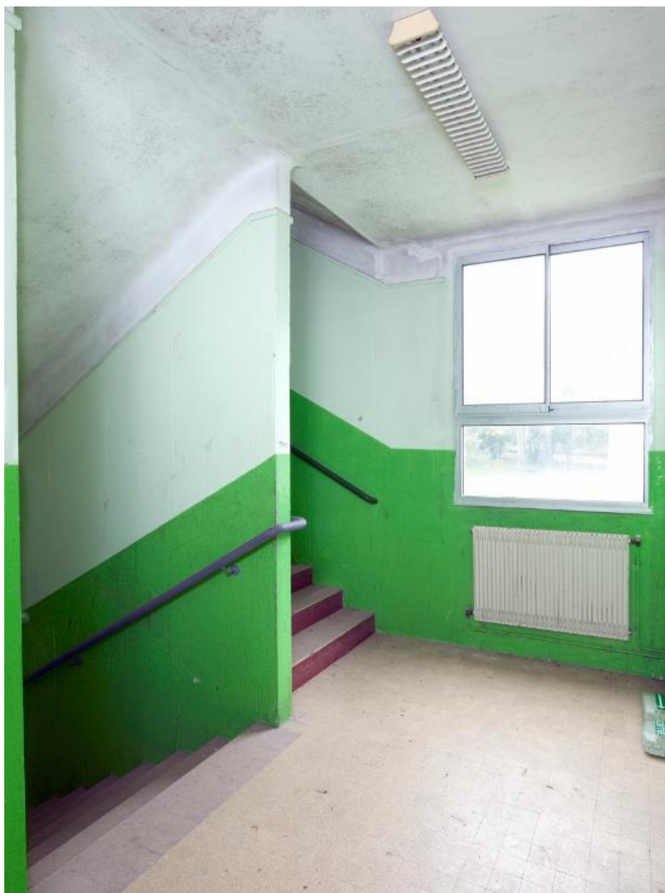
Cage d'escalier nord-ouest, internat de garçons (1954), désaffecté. Noter l'éclairage latéral du palier.
