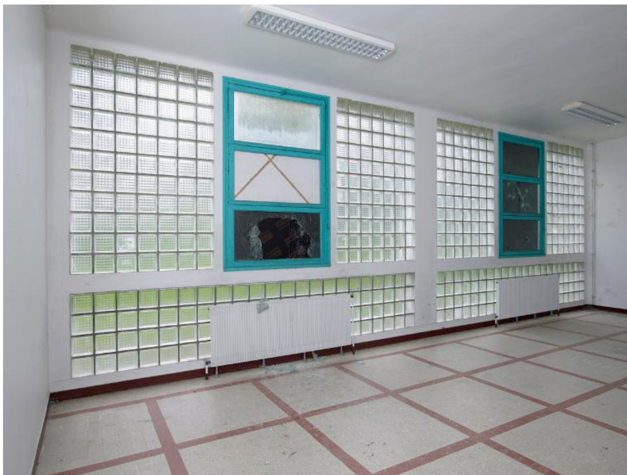
Salle de "jeux tranquilles" et sa grande verrière en pavés de verre, internat de garçons, rez-de-chaussée (1954) désaffecté.
