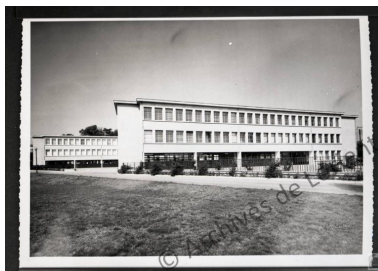
Deux externats des filles aujourd'hui démolis (G. Tourry, architecte). IVR53_20185606660X
