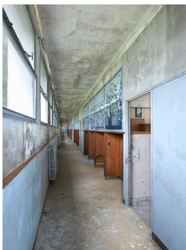
Externat n°2 (désaffecté), couloir de desserte latéral, le long de la façade nord-ouest. On aperçoit les baies
