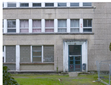
Internat garçons n°1, façade nord-est. Au rez-de-chaussée, les verrière en pavés de verre de la salle de jeux tranquilles. Détail sur l'entrée. Phot. Bernard Bègne IVR53_20195600559NUCA
