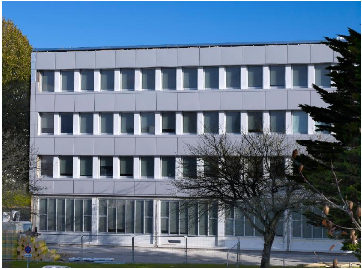
Internat garçons n°4, transformé en "espace langues", en cours de réhabilitation thermique.
