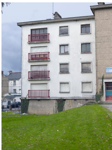
Façade sud-est avant de l'externat 1 (désaffecté). La barre se prolonge par 4 niveaux de logements. Phot. Bernard Bègne IVR53_20195600540NUCA
