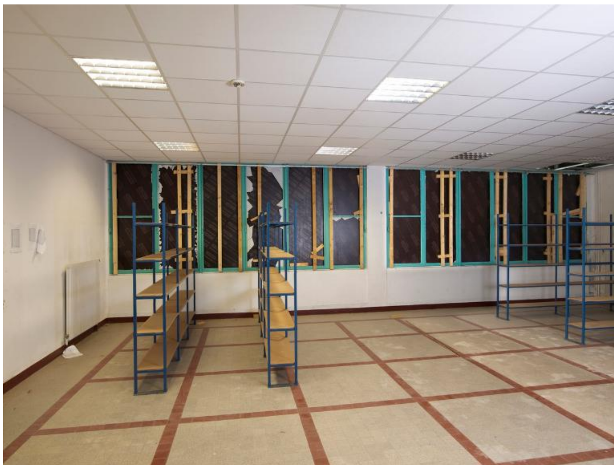
Salle d'étude, internat de garçons, rez-de-chaussée (1954) désaffecté.
