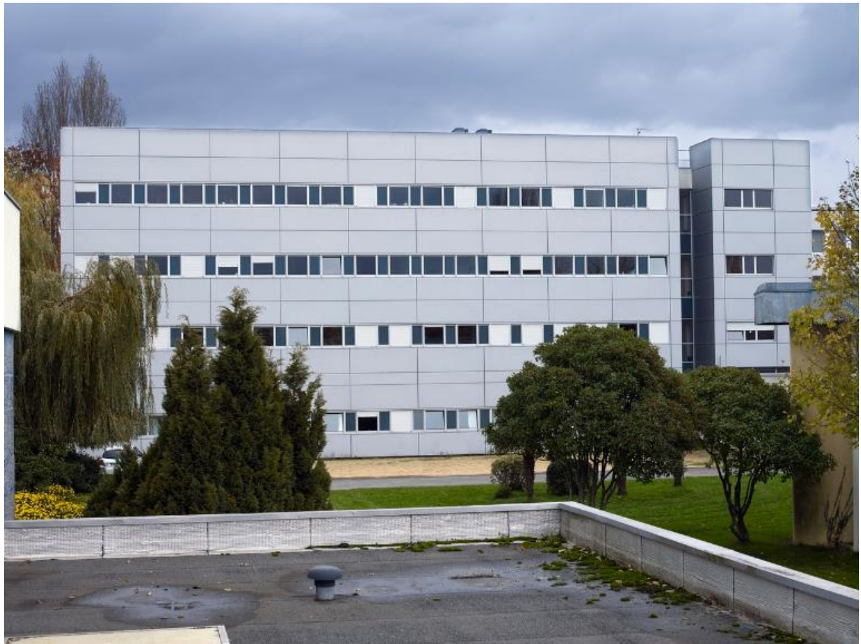
Internat garçons n°2, réhabilité (isolation extérieure, adjonction de l'aile à droite, Thierry Loison architecte). Façade sud-ouest.
