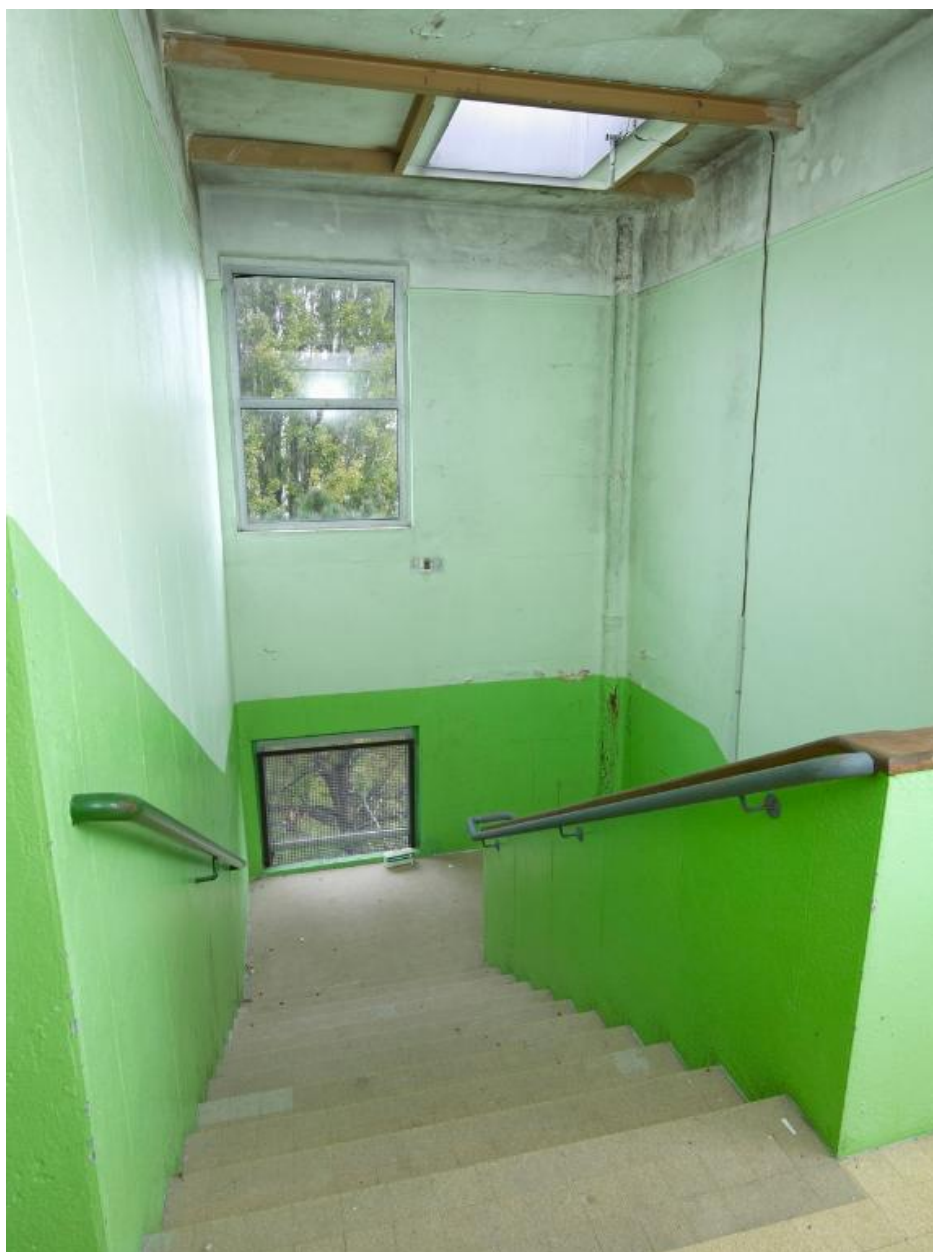
Cage d'escalier nord-ouest, internat de garçons (1954), désaffecté.
