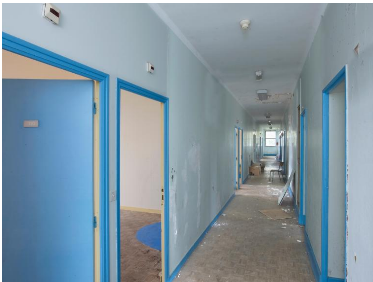
Couloir de desserte central, internat de garçons (1954), désaffecté.
