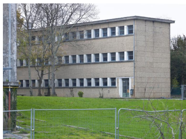
Façade arrière de l'externat B2 (désaffecté), prise depuis le pignon des logements (externat B1). Phot. Bernard Bègne IVR53_20195600543NUCA
