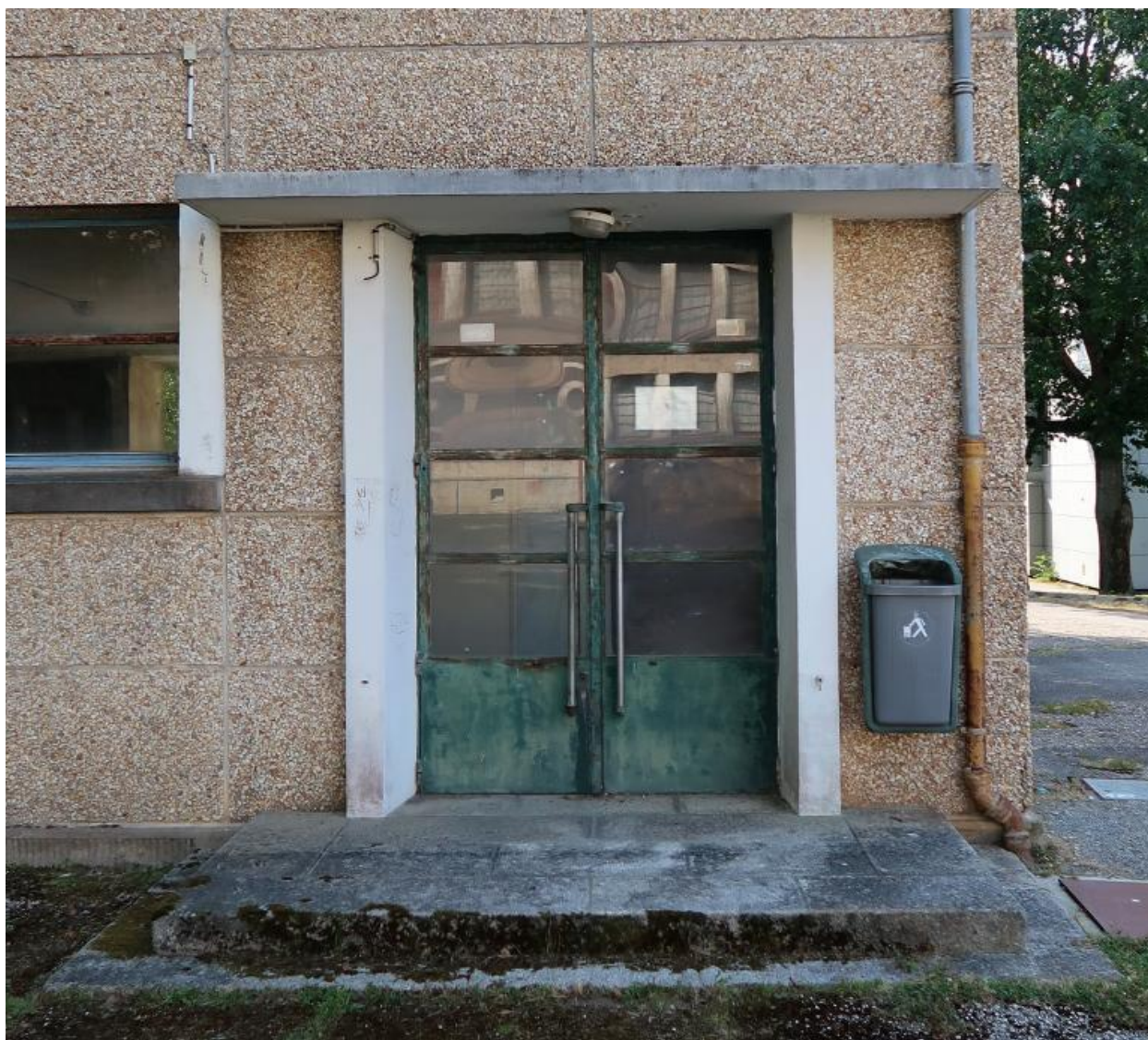
Externat désaffecté (G. Tourry Architecte), détail d'une entrée sur façade nord.
