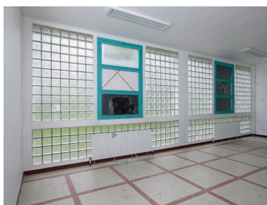
Salle de "jeux tranquilles" et sa grande verrière en pavés de verre, internat de garçons, rez-de-chaussée (1954) désaffecté. Phot. Bernard Bègne IVR53_20195600432NUCA
