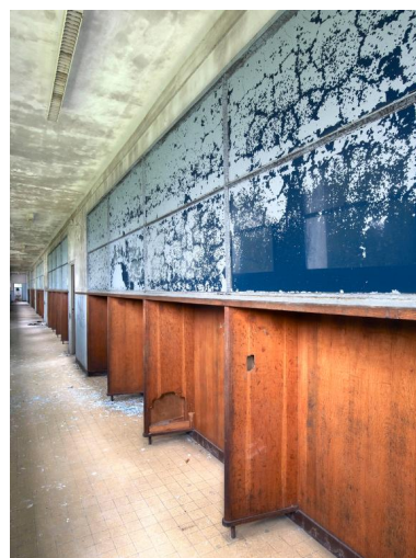
Externat n°2 (désaffecté), couloir de desserte latéral, le long de la façade nord-ouest. Les baies hautes, dans la
