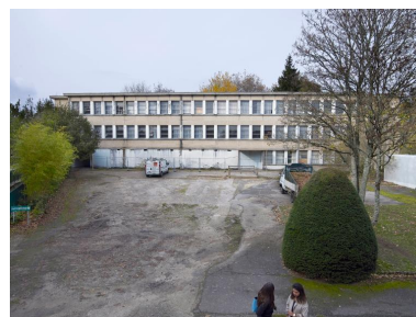
Vue d'ensemble de la façade arrière (sud-est) d'un externat désaffecté. Phot. Bernard Bègne IVR53_20195600538NUCA
