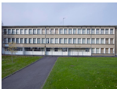
Vue d'ensemble de la façade avant (sud-est) d'un externat désaffecté. Phot. Bernard Bègne IVR53_20195600537NUCA
