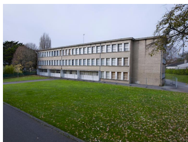
Vue d'ensemble de la façade avant (sud-est) d'un externat désaffecté. Phot. Bernard Bègne IVR53_20195600536NUCA
