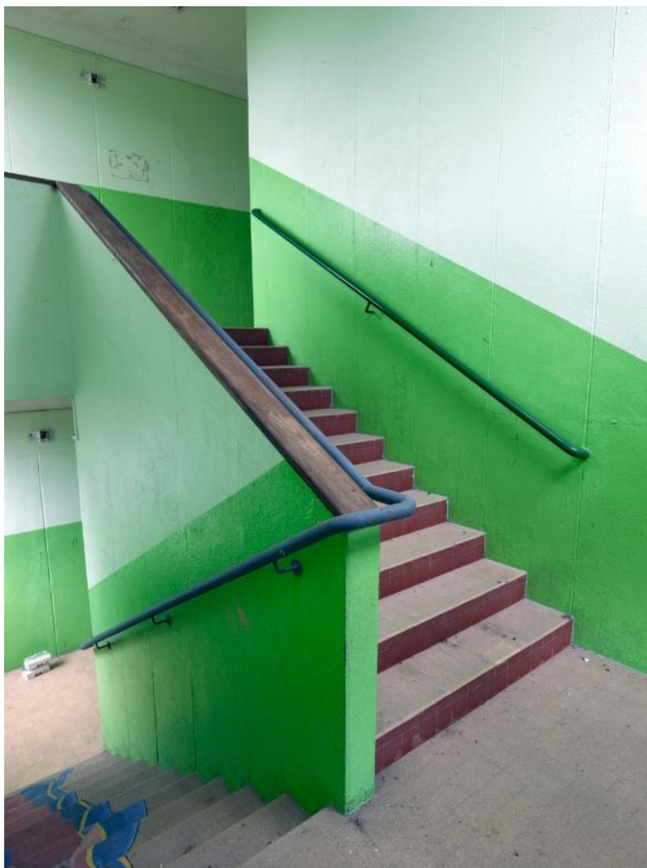
Cage d'escalier nord-ouest, internat de garçons (1954), désaffecté.
