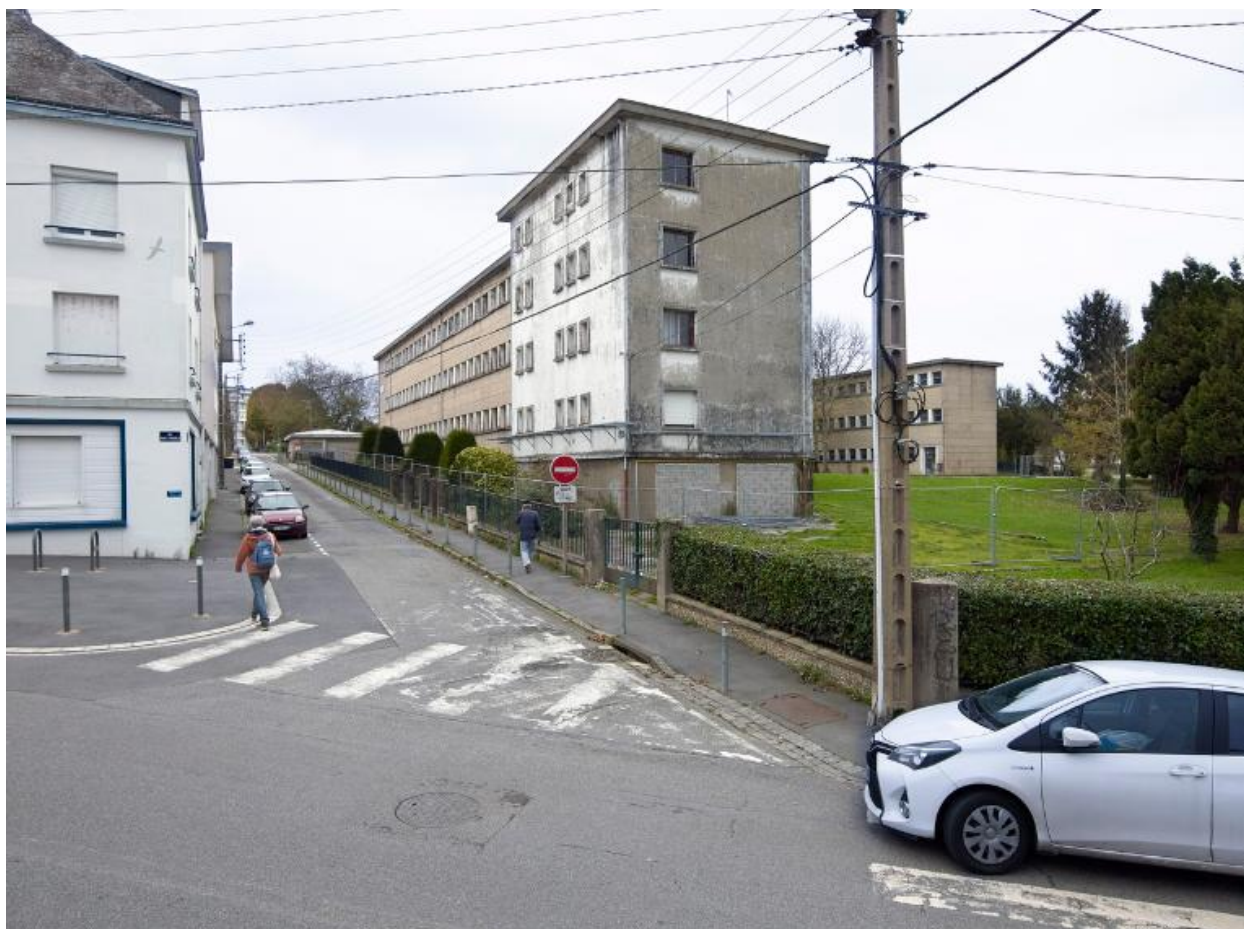
Le long de la rue Professeur Mazé, façade nord-ouest de l'externat 1 (désaffecté). Au premier plan, les 4 niveaux de logements.
