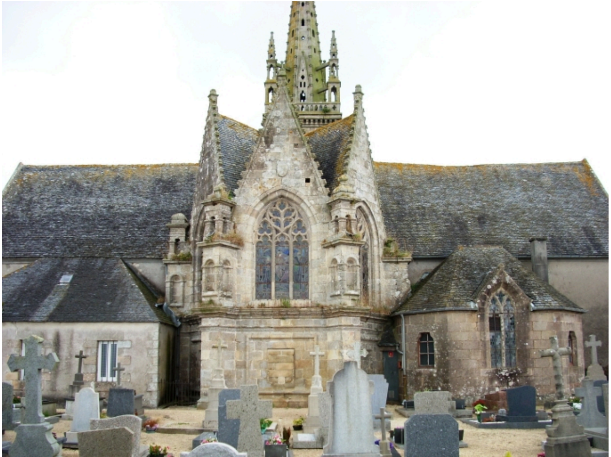
Guiclan, église paroissiale Saint-Pierre : élévation est
