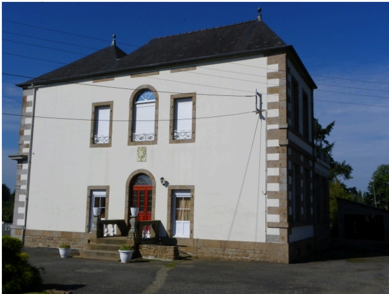
Façade est de l'ancien château.
