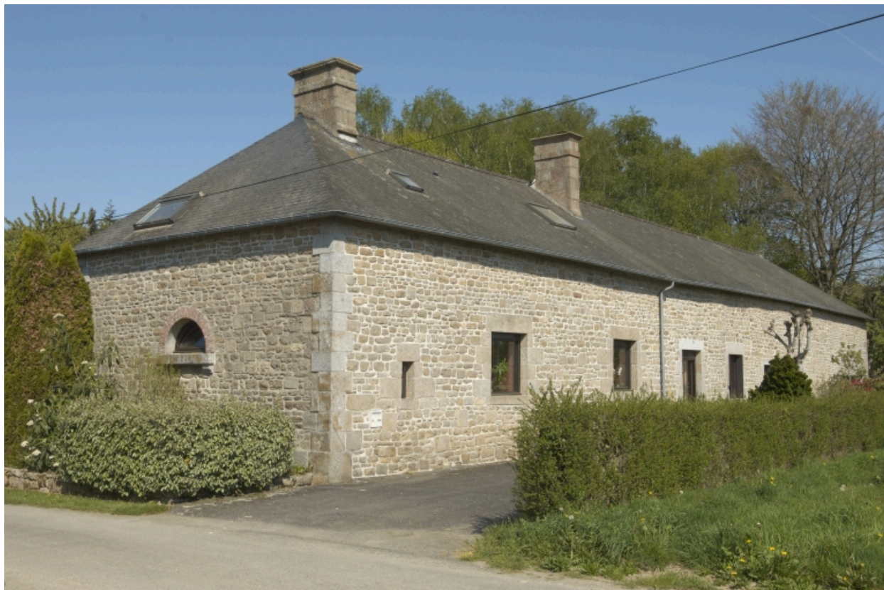
Façade postérieure du commun est.
