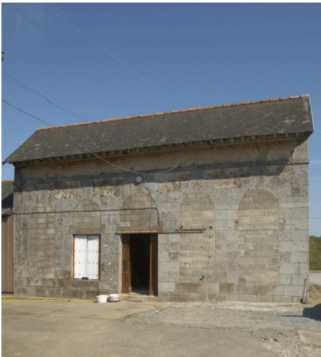
Façade sud d'une dépendance du château.
