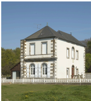
Vue de la façade sud. Phot. Norbert Lambart IVR53_20113501530NUCA
