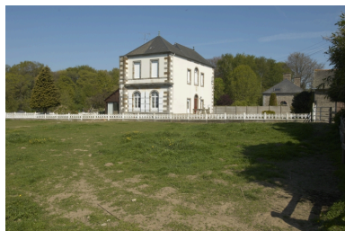
Vue d'ensemble depuis le sud-ouest. Phot. Norbert Lambart IVR53_20113501529NUCA
