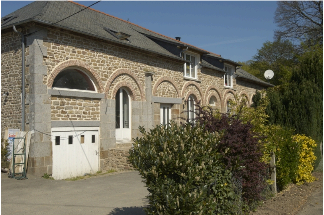
Façade principale du commun ouest.
