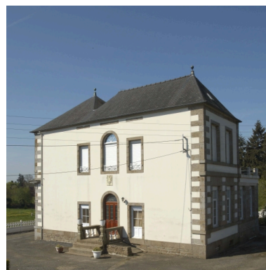
Façade est de l'ancien château. Phot. Norbert Lambart IVR53_20113501528NUCA
