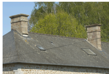
Toiture du commun ouest. Phot. Norbert Lambart IVR53_20113501531NUCA
