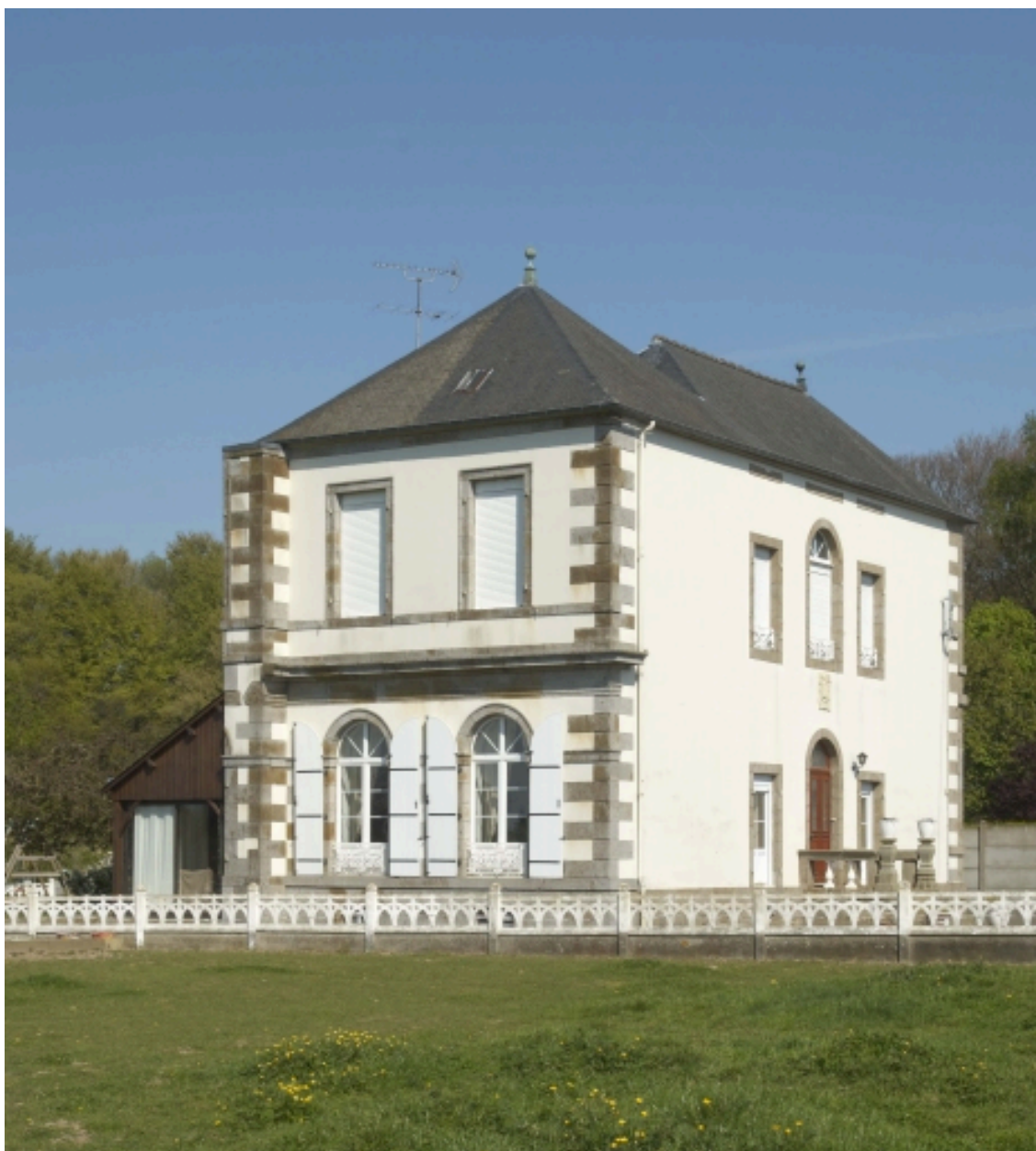
Vue de la façade sud.
