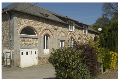
Façade principale du comun ouest. Phot. Norbert Lambart IVR53_20113501527NUCA
