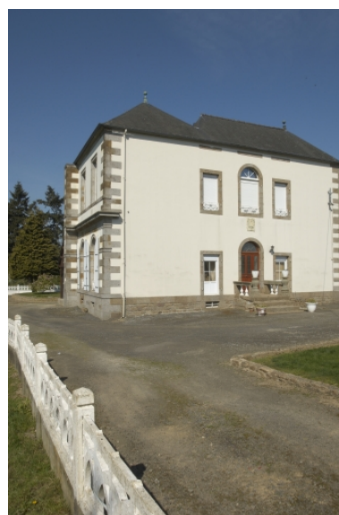
L'ancien château vu depuis le sud-est. Phot. Norbert Lambart IVR53_20113501525NUCA
