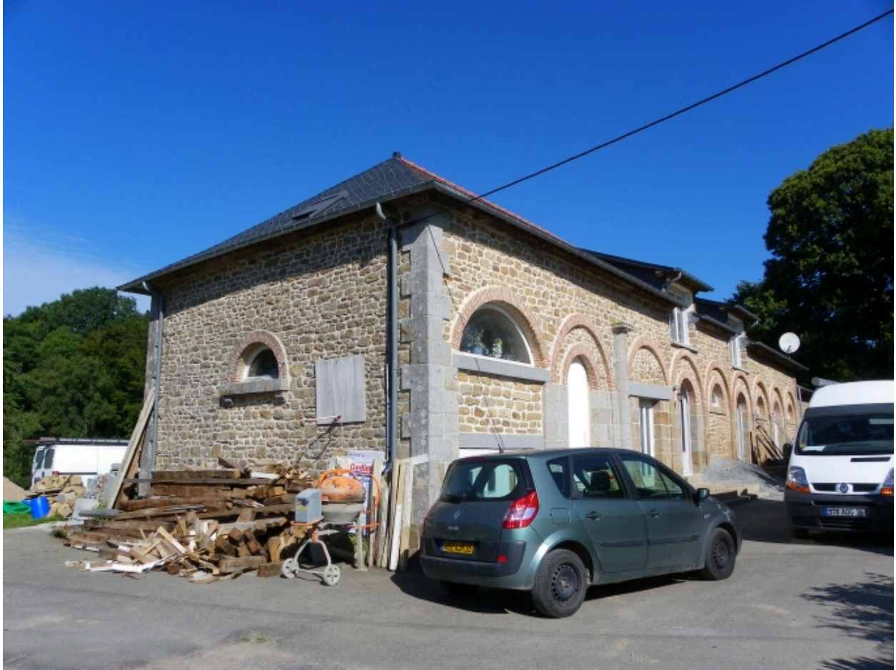
Commun ouest, façade est.
