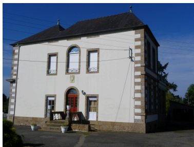
Façade est de l'ancien château. Phot. Régis Le Bohec IVR53_20103510443NUCA
