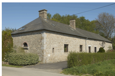
Façade postérieure du comun est. Phot. Norbert Lambart IVR53_20113501526NUCA
