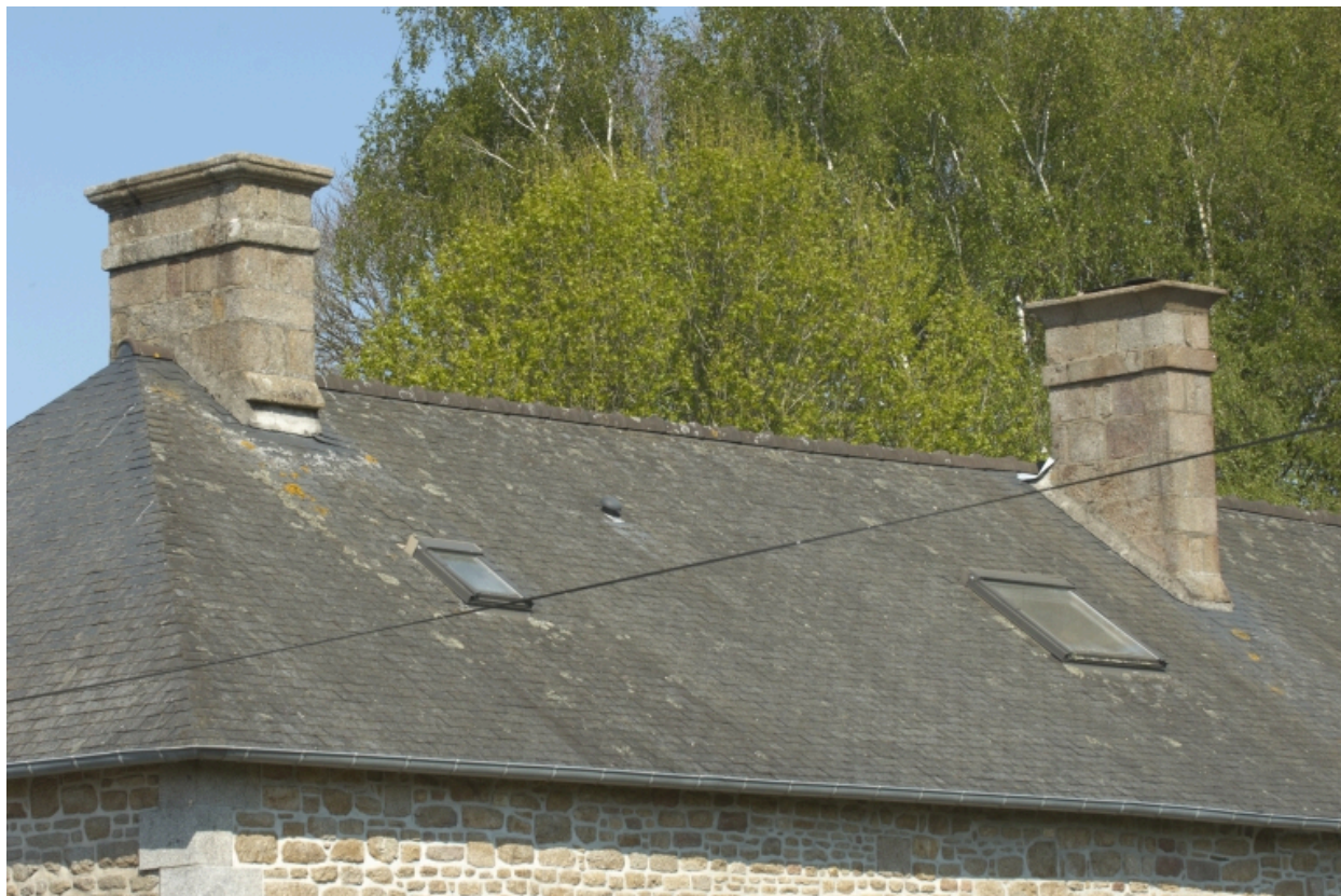
Toiture du commun ouest.
