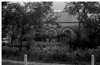
Communs est, façade principale. Phot. Auteur inconnu IVR53_20103505673Z
