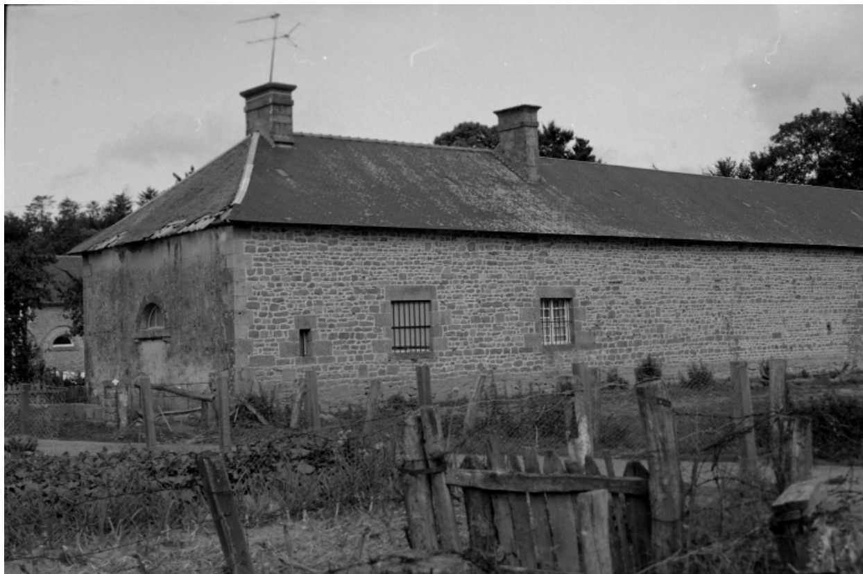
Communs est, façade postérieure.
