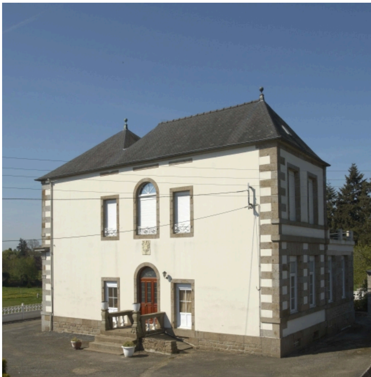
Façade est de l'ancien château.
