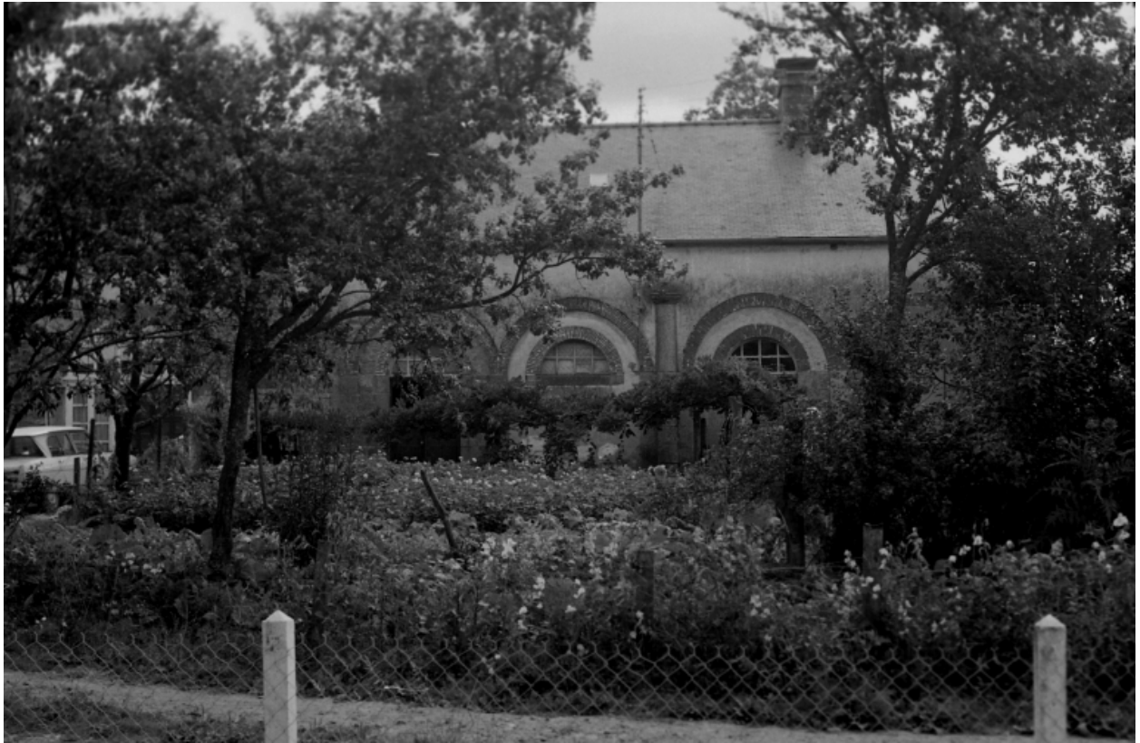
Communs est, façade principale.
