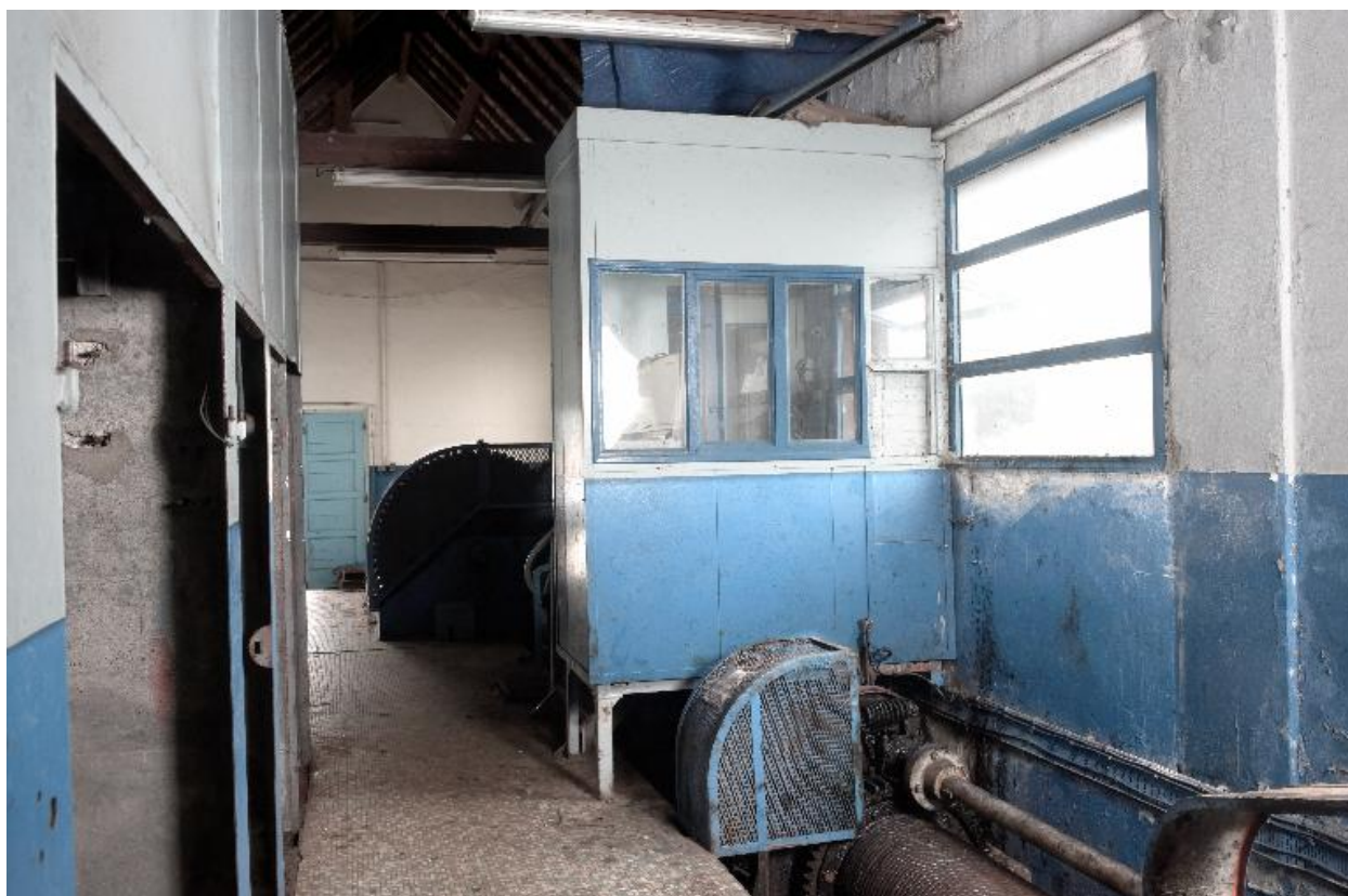
Poste de commande : intérieur du bâtiment
