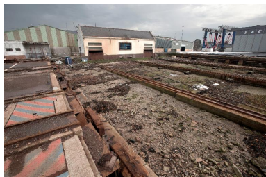
Bâtiment abritant le poste de commande et système de levage de la passerelle Phot. Bernard Bègne IVR53_20162900608NUCA
