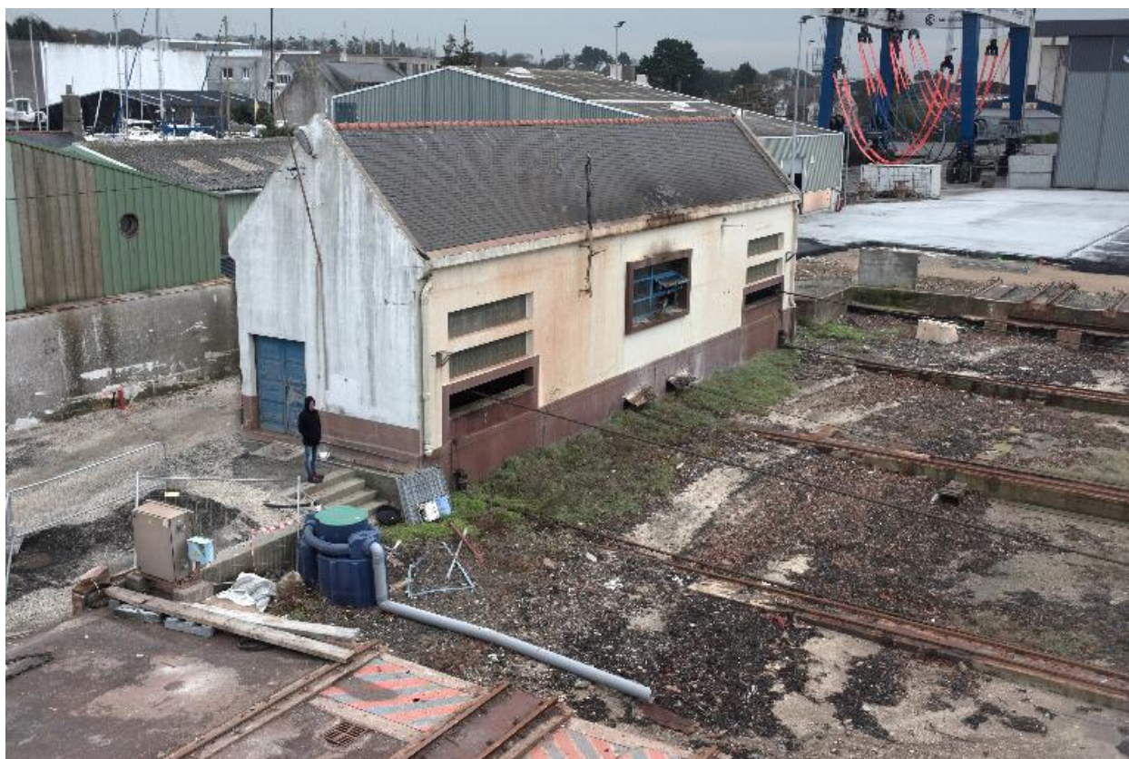
Bâtiment abritant le poste de commande et le système de traction (câbles)
