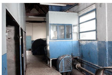
Poste de commande : intérieur du bâtiment Phot. Bernard Bègne IVR53_20162900617NUCA
