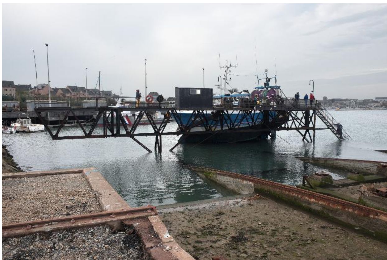
Mise à sec en cours
