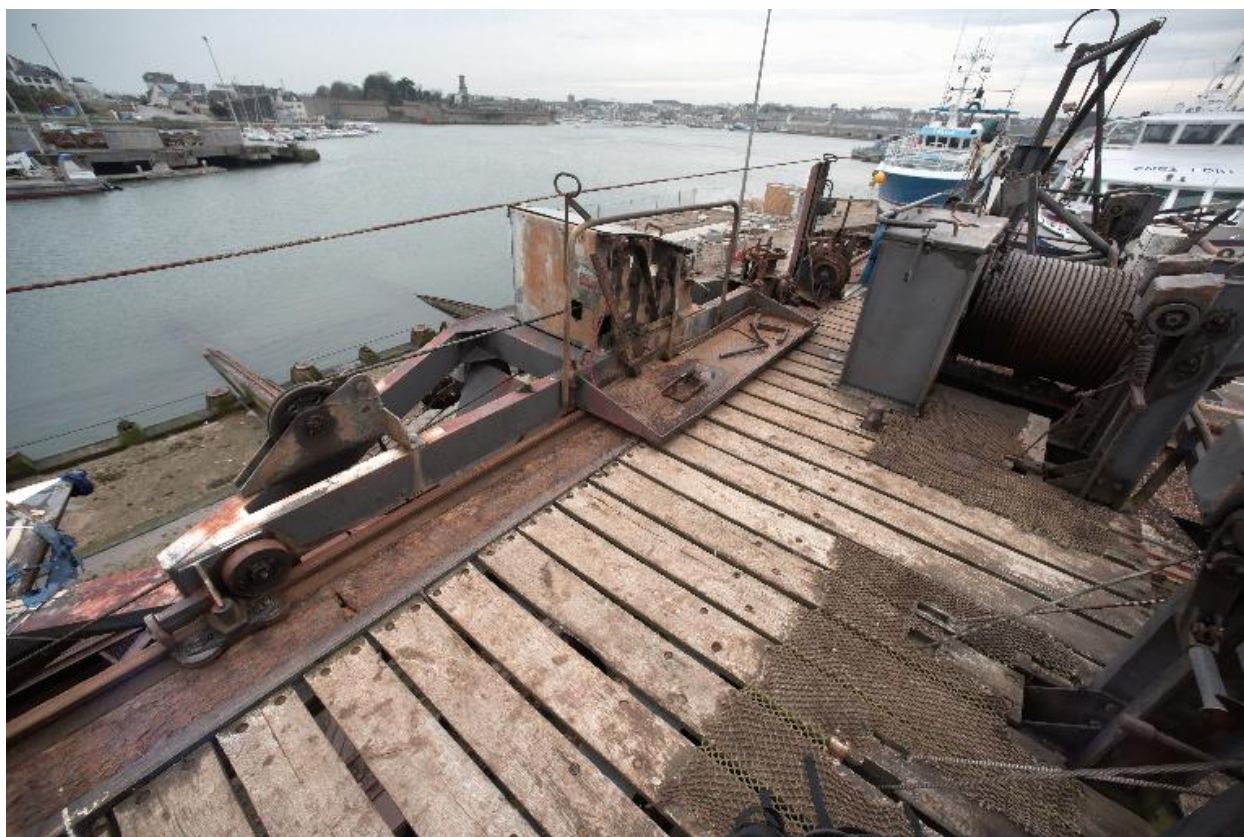
Passerelle : système mécanique
