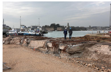
Slipway, en cours de déconstruction : ancien emplacement des rails latéraux Phot. Bernard Bègne IVR53_20162900629NUCA
