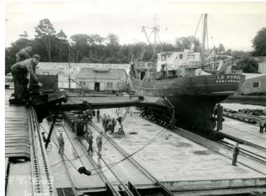
Le slipway de Concarneau, système de levage, rails et lignes de tins Repro. Auteur inconnu, Autr. Studio Le Merdy IVR53_20242911492NUCB
