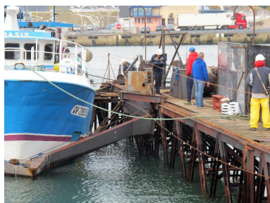
Manivelle actionnant le bras lors de la sortie de l'eau de la paserelle pour accompagner la baisse du niveau de flotaion Phot. Erwana L'Haridon IVR53_20162906105NUCA
