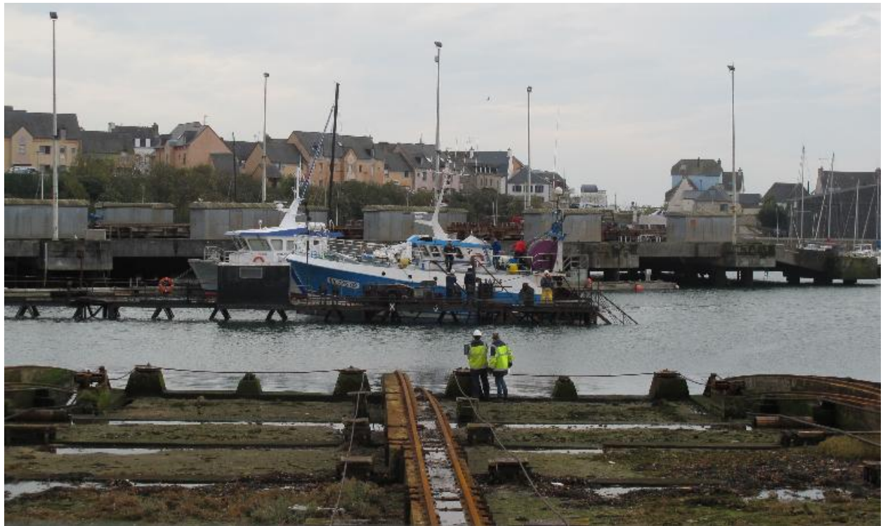
Slipway, passerelle : points de repères sur la passerelle croix et flèche pour positionner le bateau par rapport au chariot
