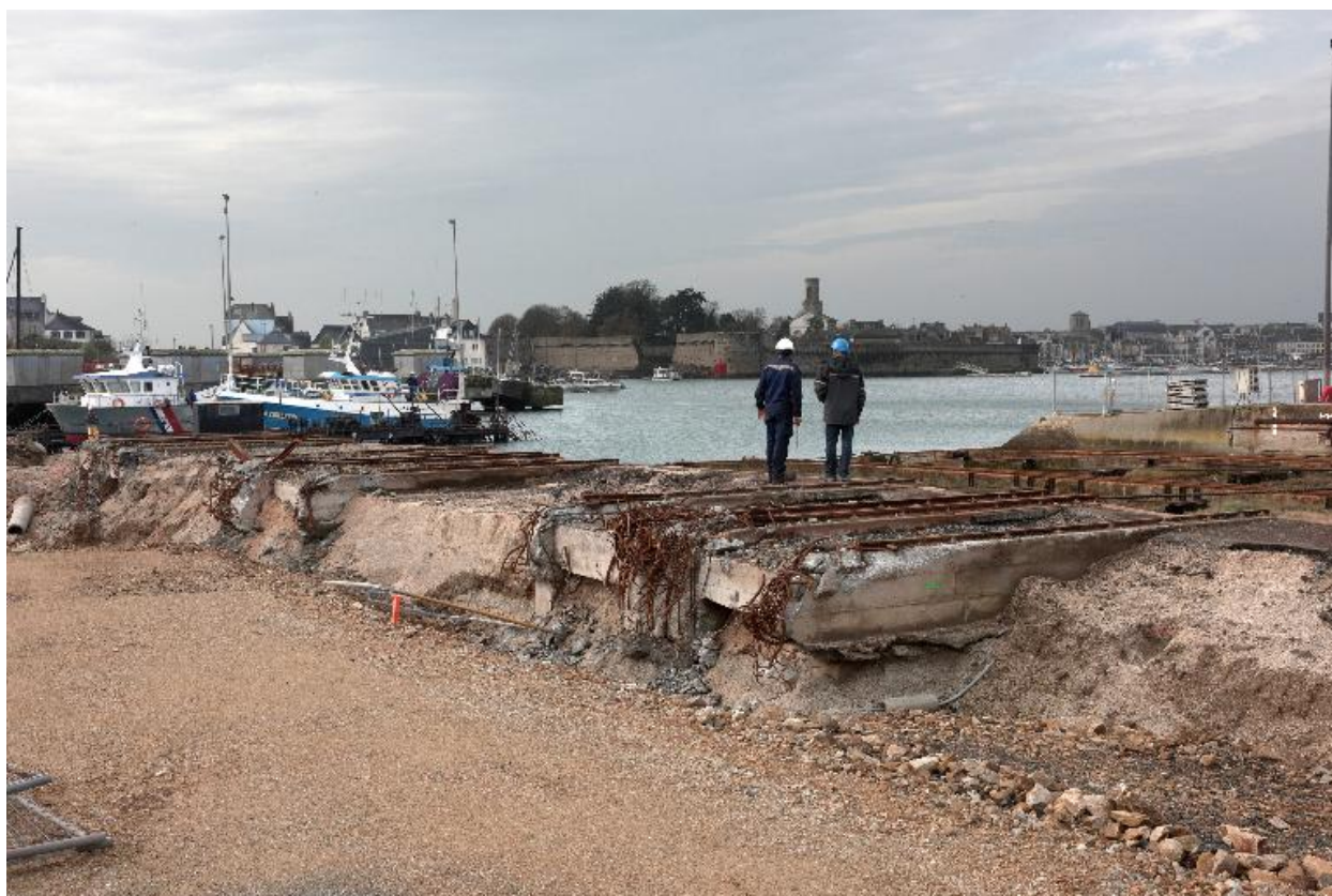
Slipway, en cours de déconstruction : ancien emplacement des rails latéraux
