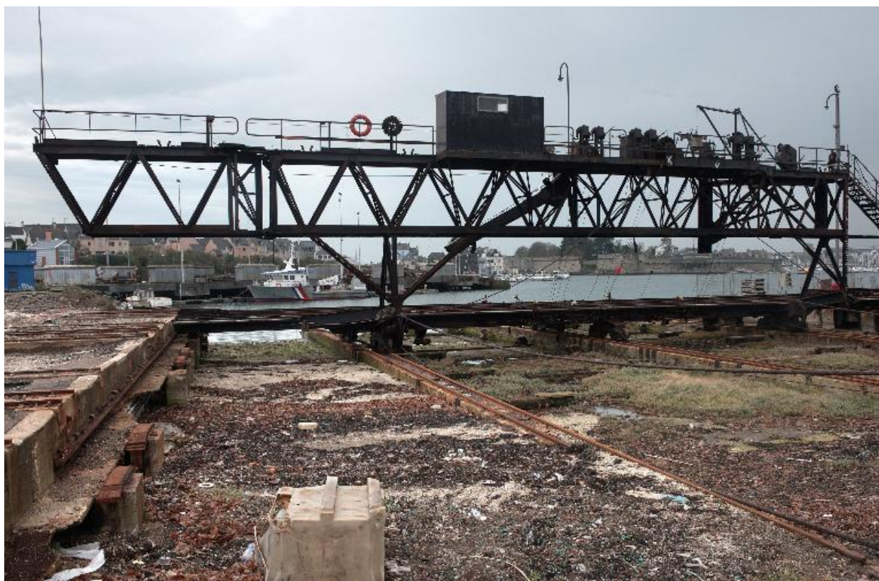
Passerelle du slipway de Concarneau, vue depuis la terre, vue générale
