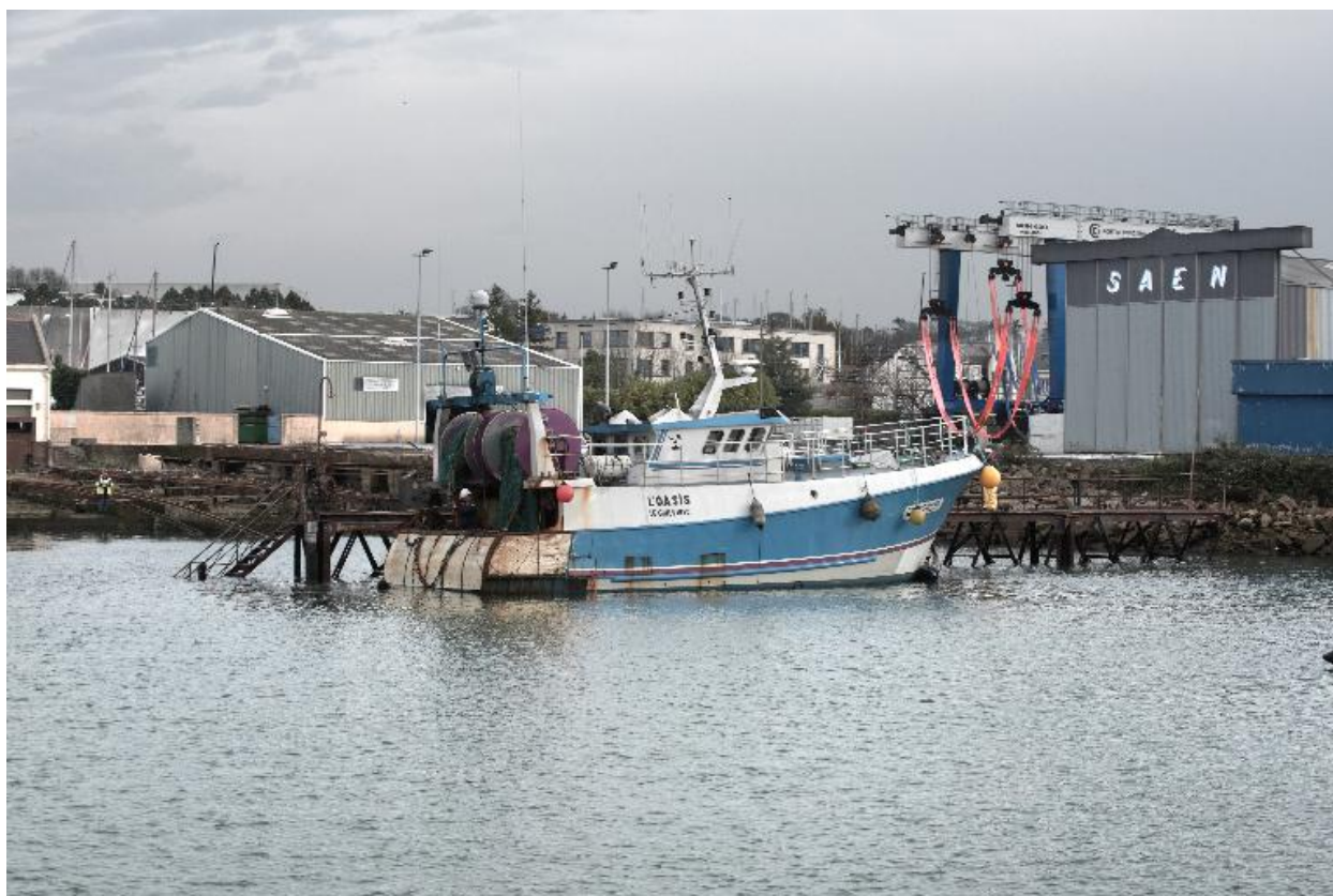
Zone portuaire, vue générale
