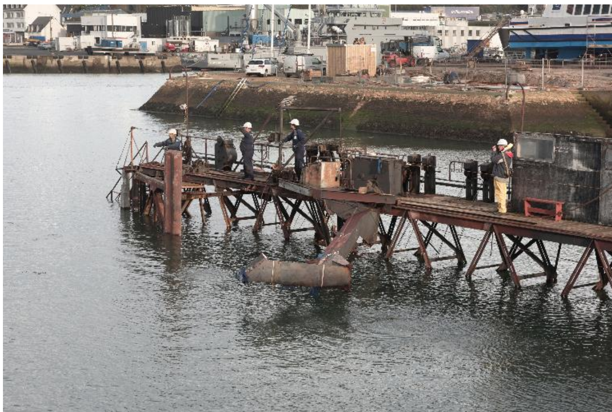
Passerelle : bras d'accueil
