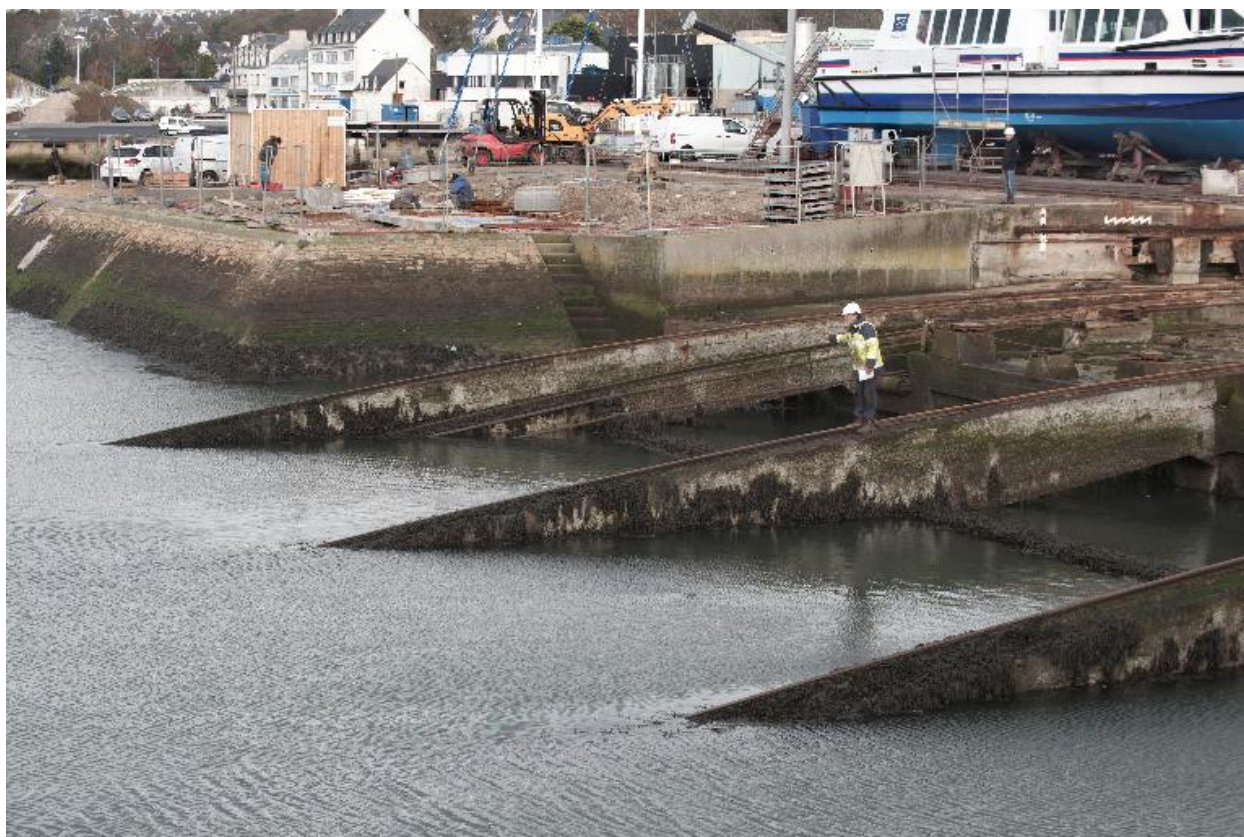
Contrôle du positionnement du bateau depuis le slipway
