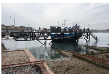
Mise à sec en cours Phot. Bernard Bègne IVR53_20162900647NUCA
