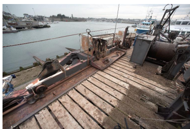
Passerelle : système mécanique Phot. Bernard Bègne IVR53_20162900679NUCA
