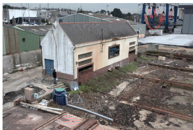
Bâtiment abritant le poste de commande et le système de traction (câbles) Phot. Bernard Bègne IVR53_20162900654NUCA
