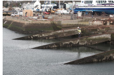
Contrôle du positionnement du bateau depuis le slipway Phot. Bernard Bègne IVR53_20162900604NUCA
