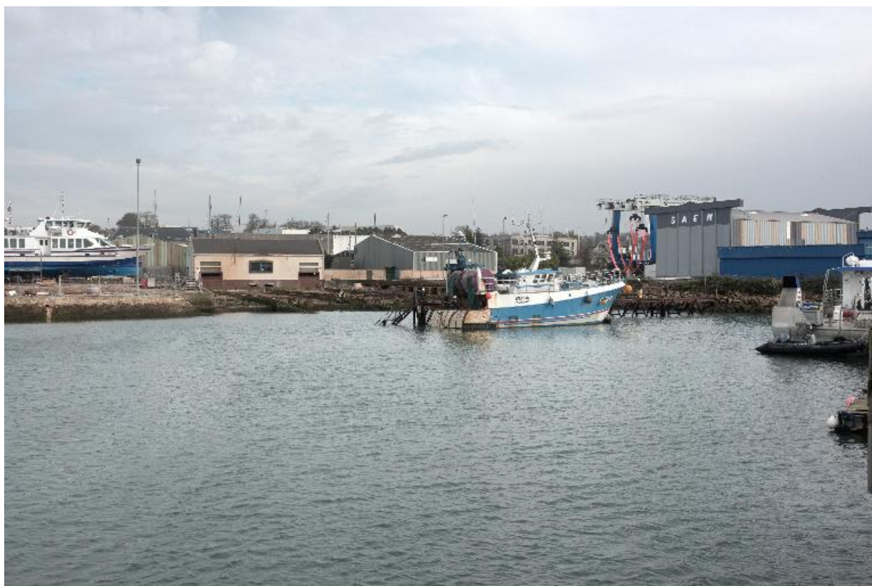
Zone portuaire, vue générale
