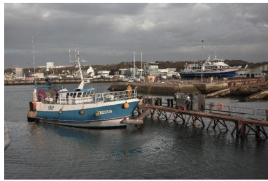
Bateau de pêche se positionnant pour être parallèle à la passerelle et centré pour être bloqué par le bras Phot. Bernard Bègne IVR53_20162900600NUCA
