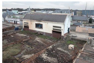
Bâtiment abritant le poste de commande et le système de levage de la passerelle Phot. Bernard Bègne IVR53_20162900675NUCA
