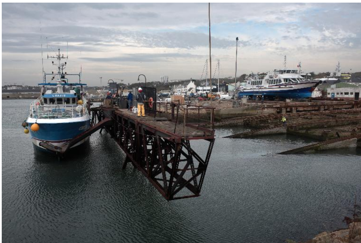
Mise à sec en cours
