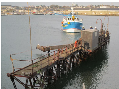
Bateau de pêche en approche ; l'étrave doit se positionner dans le "coude" du bras Phot. Erwana L'Haridon IVR53_20162906101NUCA
