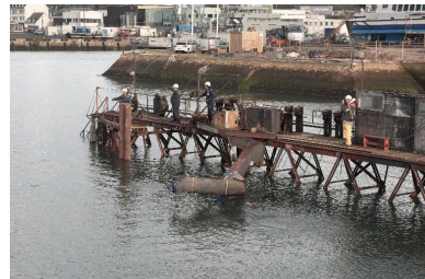
Passerelle : bras d'accueil Phot. Bernard Bègne IVR53_20162900597NUCA
