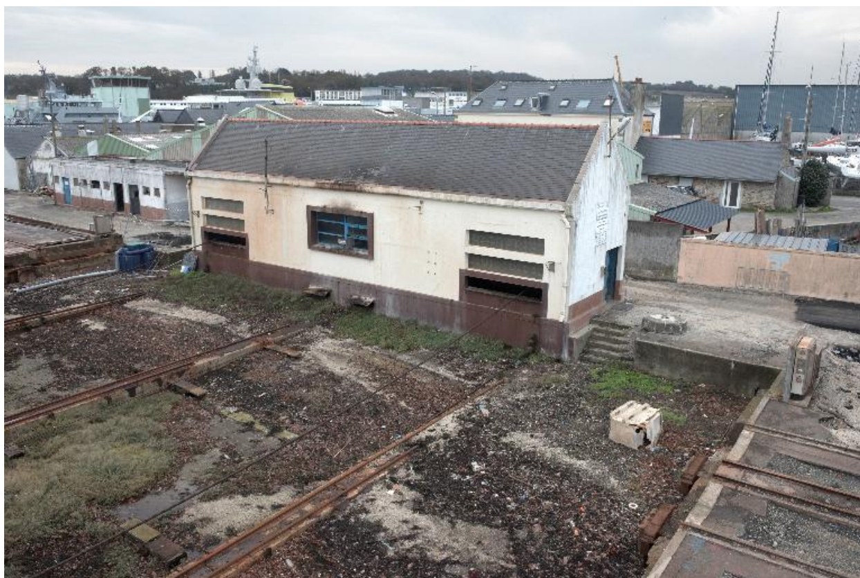
Bâtiment abritant le poste de commande et le système de levage de la passerelle
