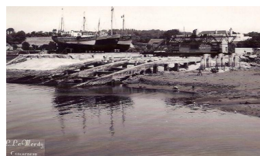
Le slipway de Concarneau en cours de construction Repro. Auteur inconnu, Phot. Studio Le Merdy IVR53_20242911498NUCB
