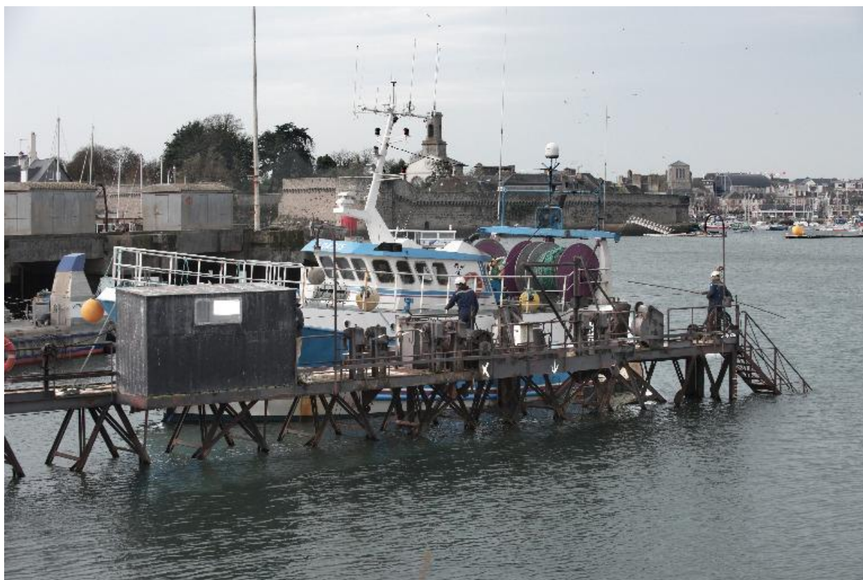
Passerelle, vue générale, depuis le slipway
