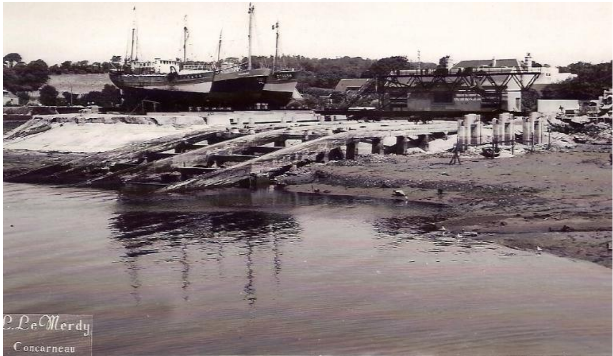
Le slipway de Concarneau en cours de construction
