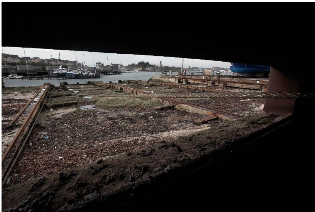
Poste de commande : ouverture pour passage du câblage
