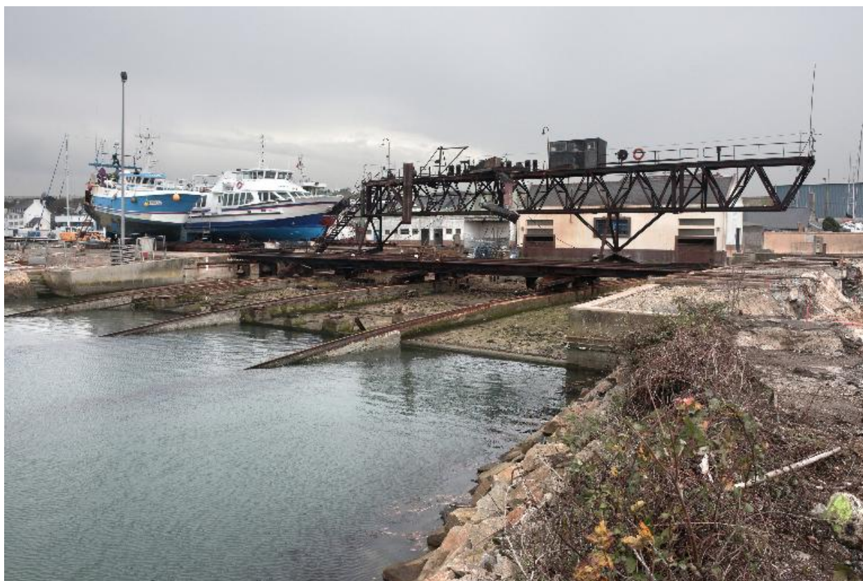
Slipway et passerelle
