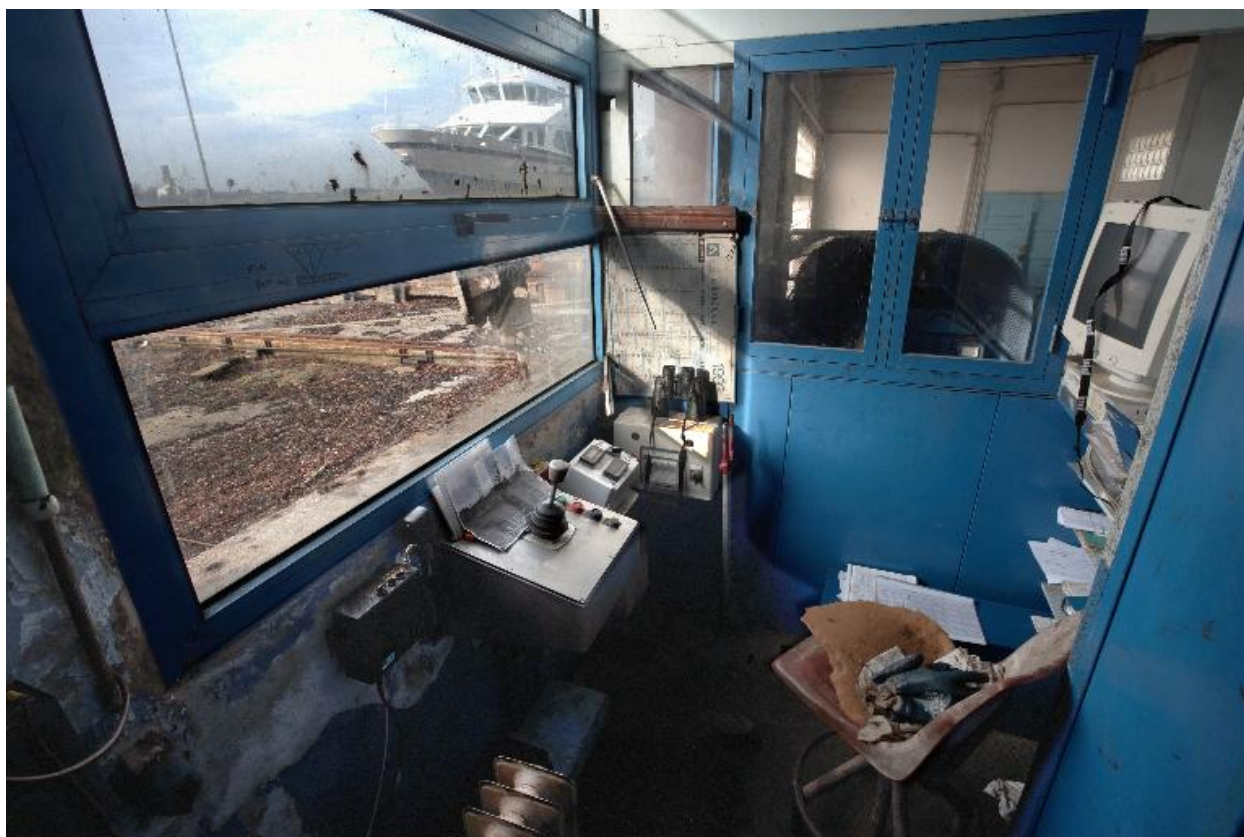
Poste de commande : intérieur, manette de sécurité
