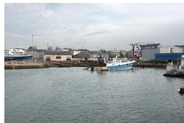
Zone portuaire, vue générale Phot. Bernard Bègne IVR53_20162900637NUCA
