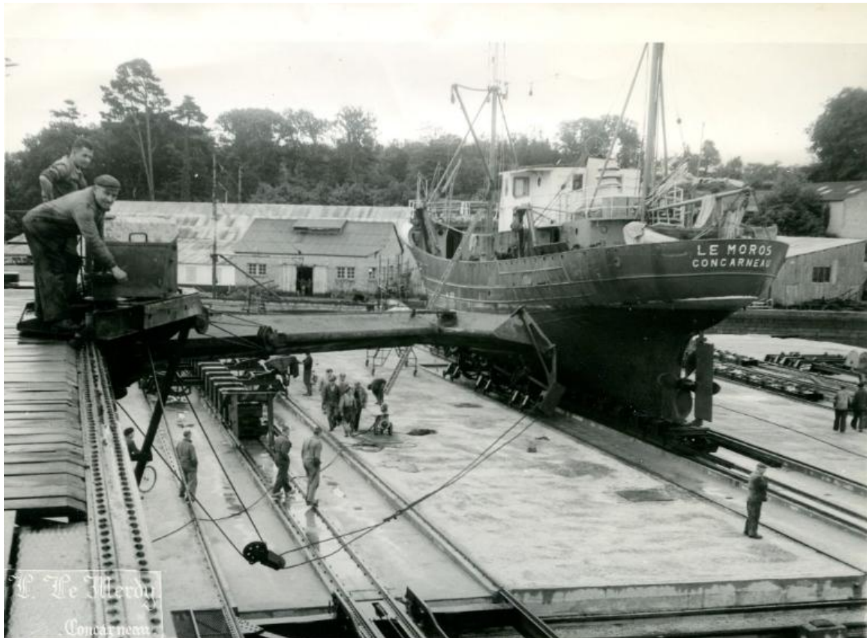
Le slipway de Concarneau, système de levage, rails et lignes de tins
