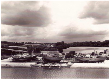
Le slipway de Concarneau : les voies latérales sont construites Repro. Auteur inconnu IVR53_20242911496NUCB
