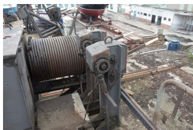
Passerelle : système mécanique, treuil Phot. Bernard Bègne IVR53_20162900673NUCA
