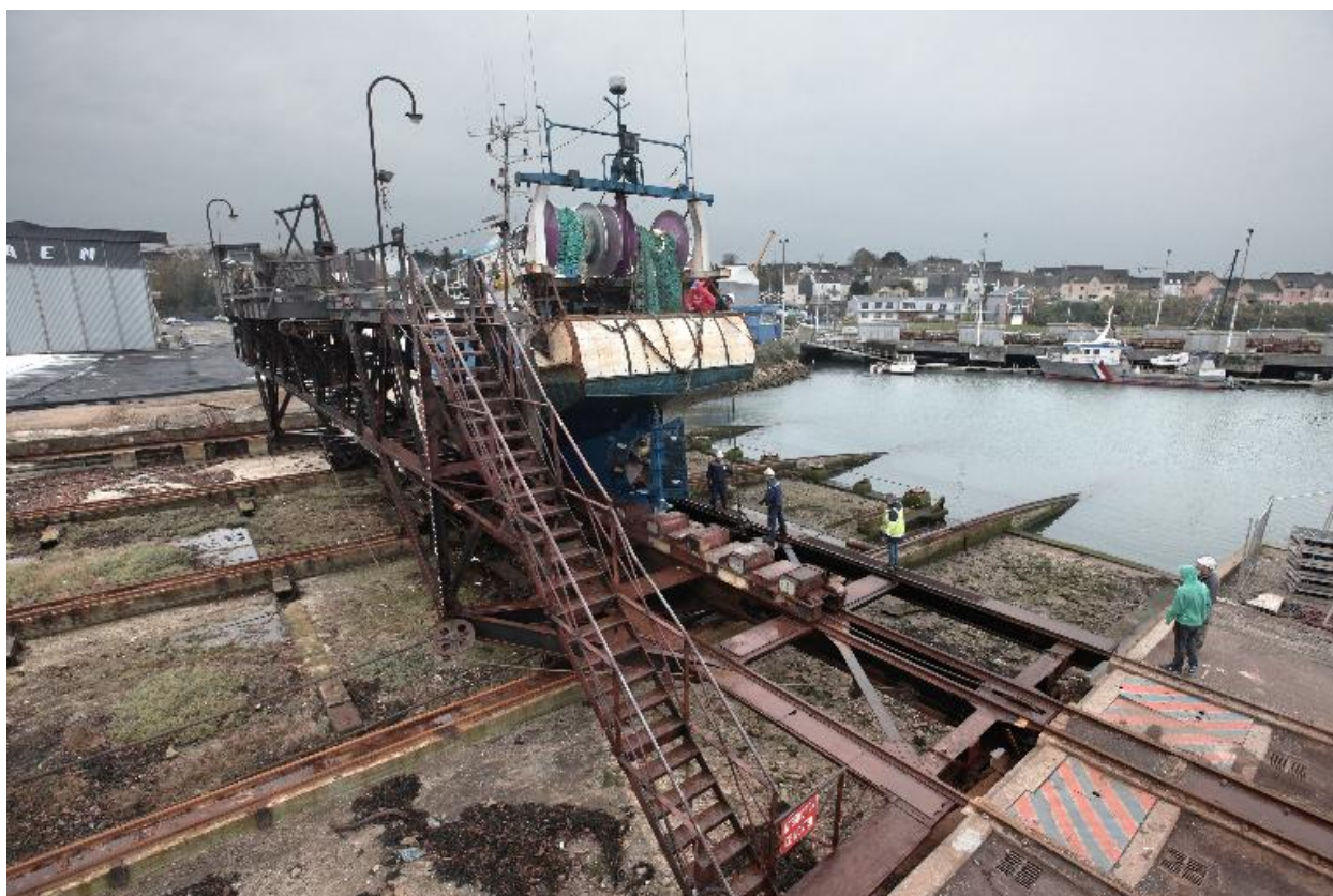
Slipway, chariot dans l'axe des rails
