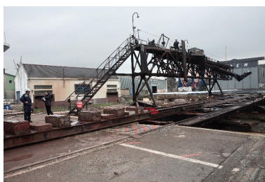
Passerelle sur slipway Phot. Bernard Bègne IVR53_20162900671NUCA
