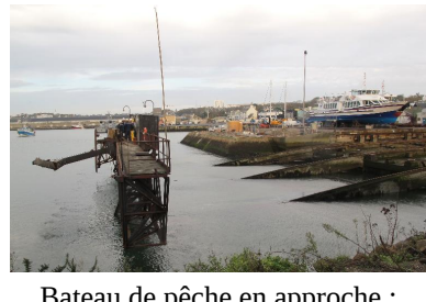
Bateau de pêche en approche ; passerelle en partie basse du slipway ; rampe du slipway Phot. Erwana L'Haridon IVR53_20162906100NUCA
