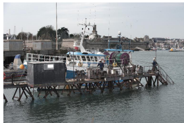
Passerelle, vue générale, depuis le slipway Phot. Bernard Bègne IVR53_20162900605NUCA
