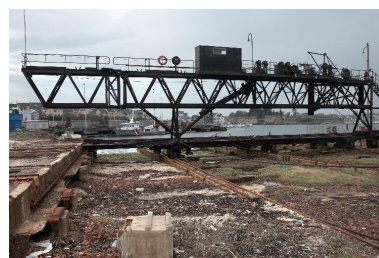
Passerelle du slipway de Concarneau, vue depuis la terre, vue générale Phot. Bernard Bègne IVR53_20162900686NUCA
