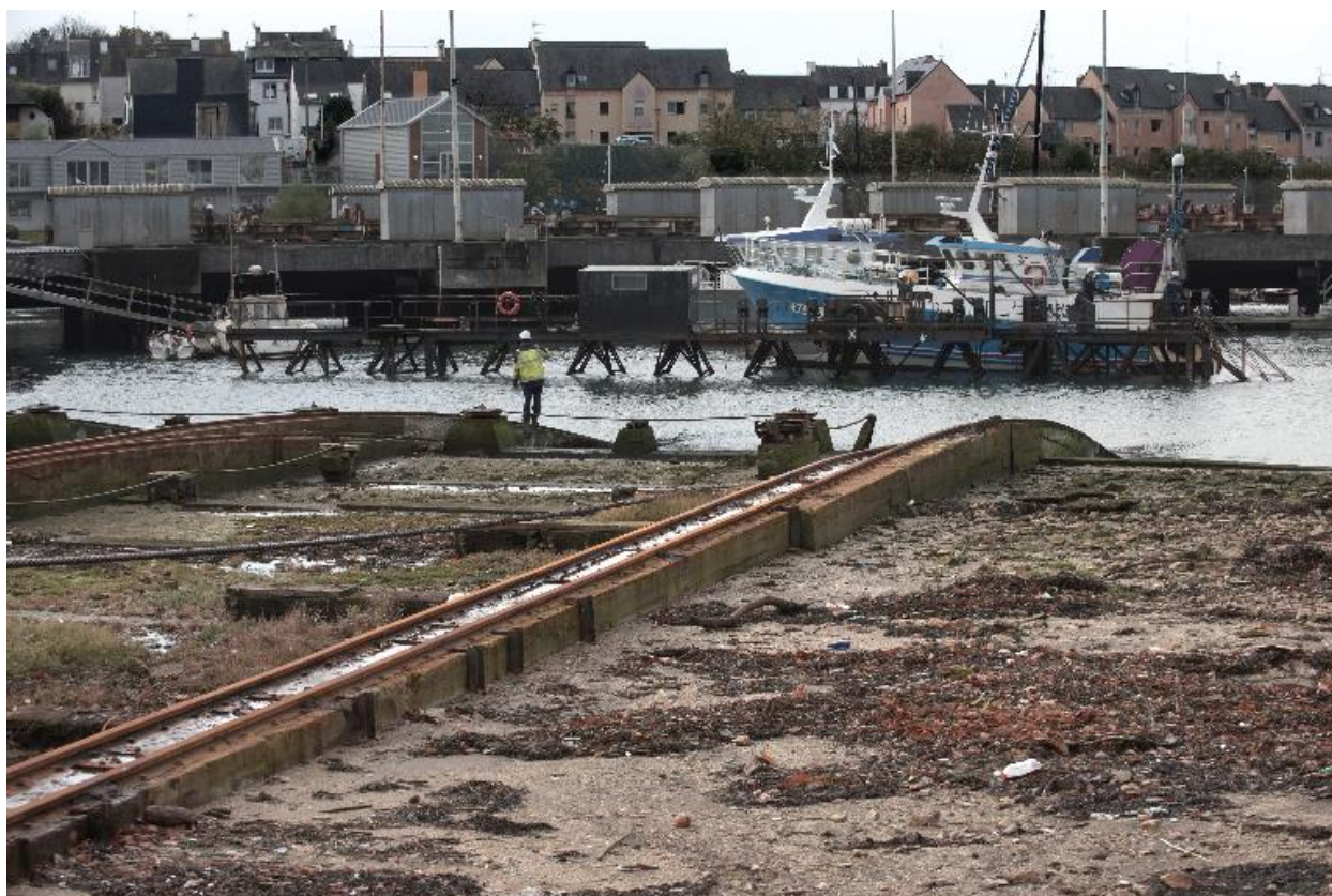
Slipway, rails et câbles
