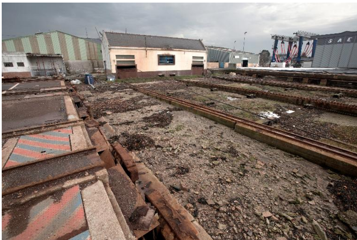
Bâtiment abritant le poste de commande et système de levage de la passerelle
