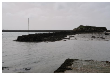
Jetée ouest de pors an eog : blocs de roches (mise en oeuvre en pierres-sèches) protégeant l'anse Phot. Erwana L'Haridon IVR53_20202905397NUCA
