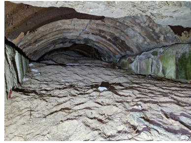
Vue intérieure : salle de garde couverte en tôle métro. En partie disloqué, le bunker est envahi par le sable Phot. Guillaume Lécueillier IVR53_20252910541NUCA
