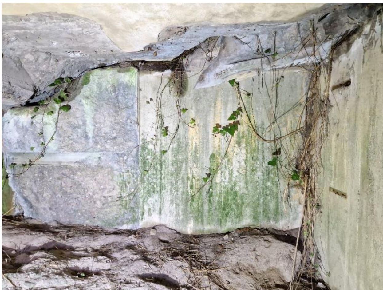
Vue intérieure : entrée de la salle de garde. Le mur du couloir d'accès a été soufflé par une explosion interne. En partie disloqué, le bunker est envahi par le sable
