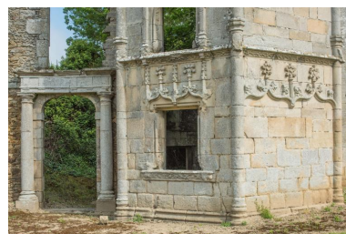
Le château : partie basse de la tour d'escalier Phot. Marie Roullé IVR53_20182200403NUCA
