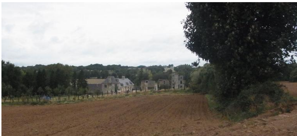
Vue de situation, à gauche, corps de l'hôpital
