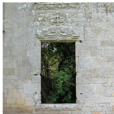
Le château, détail d'une baie du rez-de-chaussée, partie est en gothique flamboyant Phot. Véronique Orain IVR53_20172206312NUCA
