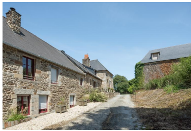
La métairie : vue générale Phot. Charlotte Barraud IVR53_20182200997NUCA
