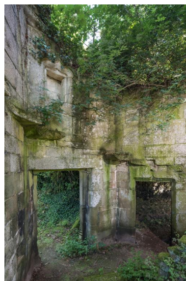
Le château : vue intérieure depuis la tour d'escalier Phot. Charlotte Barraud IVR53_20182200979NUCA
