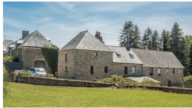
La métairie, vue générale Phot. Charlotte Barraud IVR53_20182200995NUCA
