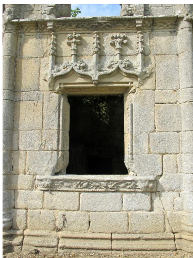
le château, tour d'escalier, détail baie à double accolade gothique Phot. Véronique Orain IVR53_20172206311NUCA
