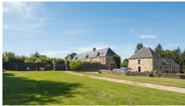
Métairie et commons transformés en hôpital Phot. Charlotte Barraud IVR53_20182200972NUCA
