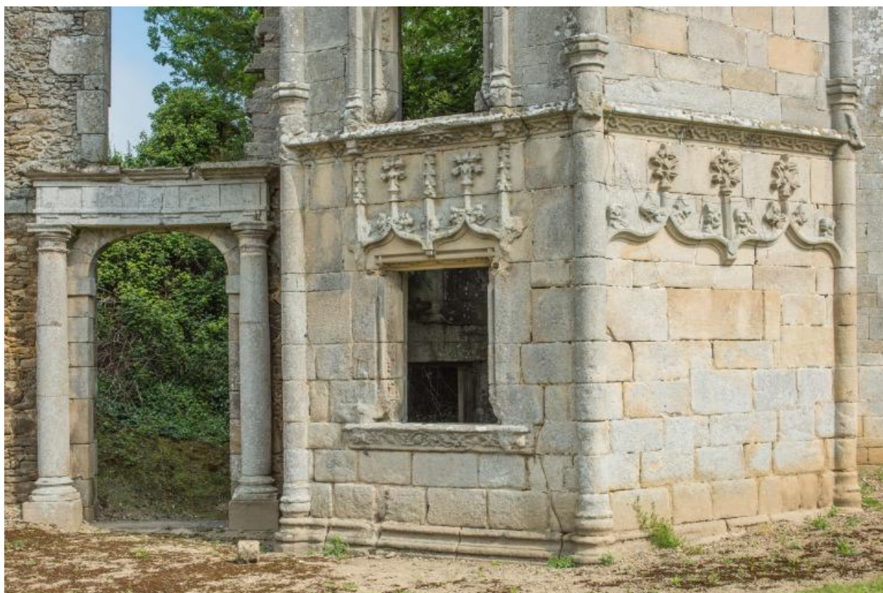
Le château : partie basse de la tour d'escalier
