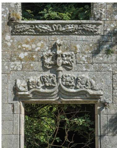
Fenêtre est du rez-de-chaussée, détail de l'accolade et du décor sculpté Phot. Charlotte Barraud IVR53_20182200965NUCA
