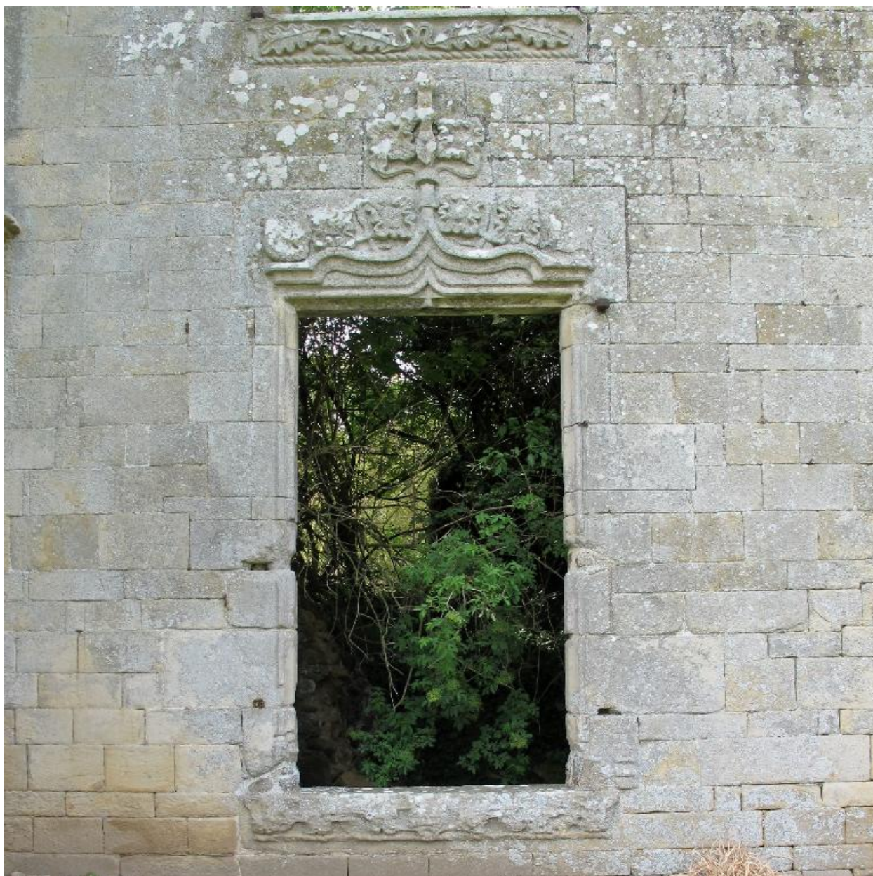
Le château, détail d'une baie du rez-de-chaussée, partie est en gothique flamboyant
