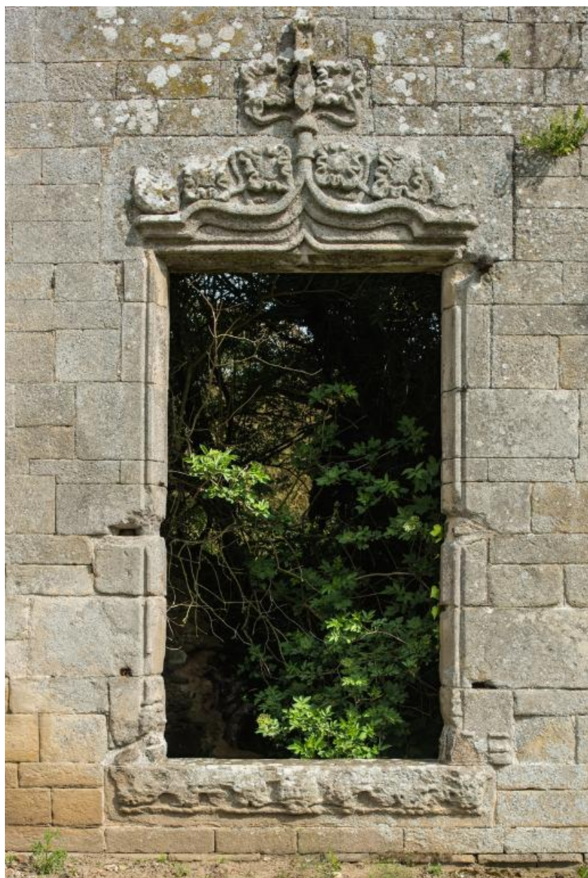
Le château, détail d'une baie du rez-de-chaussée, partie est en gothique flamboyant
