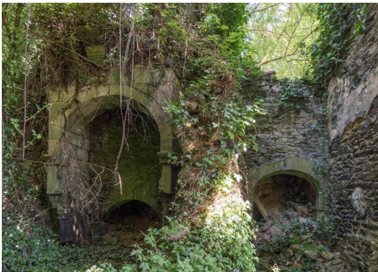
Le château : vue intérieure, partie est, vestiges des cheminées
