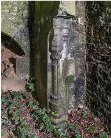
Le château : vue intérieure, partie, cheminée, détail d'un piédroit Phot. Charlotte Barraud IVR53_20182200993NUCA
