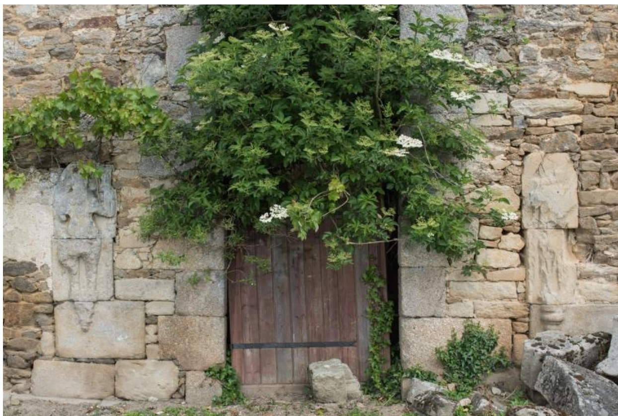
Le château : partie ouest de la façade, porte de la travée centrale
