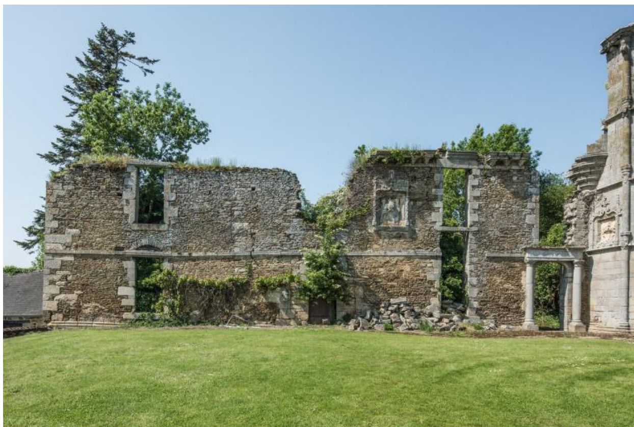
Le château : partie ouest de la façade
