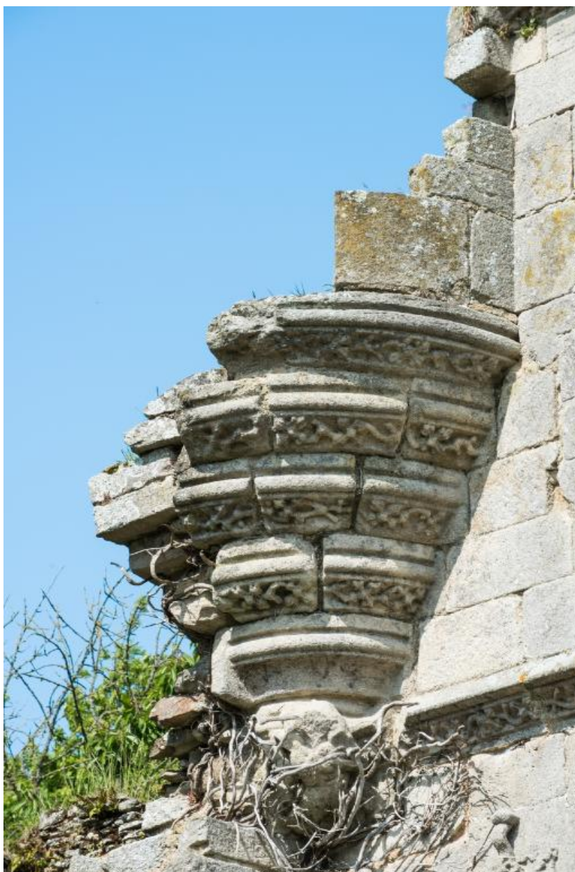
Le château : tour d'escalier et tourelle en encorbellement pour desservir l'étage du comble
