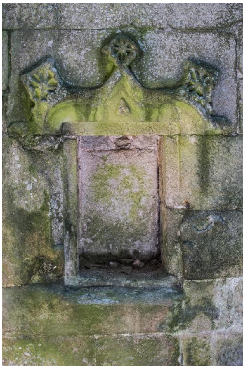
le château : vue intérieure de la tour d'escalier, détail d'une niche
