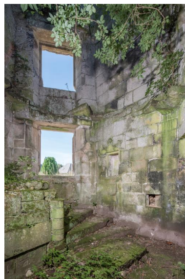
Le château : vue intérieure depuis la tour d'escalier Phot. Charlotte Barraud IVR53_20182200982NUCA
