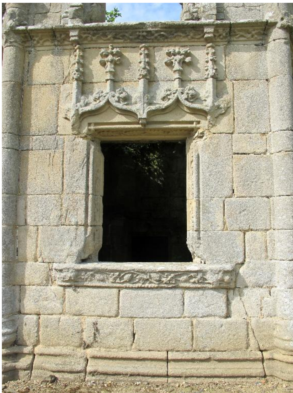
le château, tour d'escalier, détail baie à double accolade gothique
