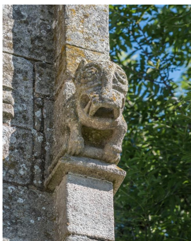
Détail décor de la lucarne Phot. Charlotte Barraud IVR53_20182200969NUCA
