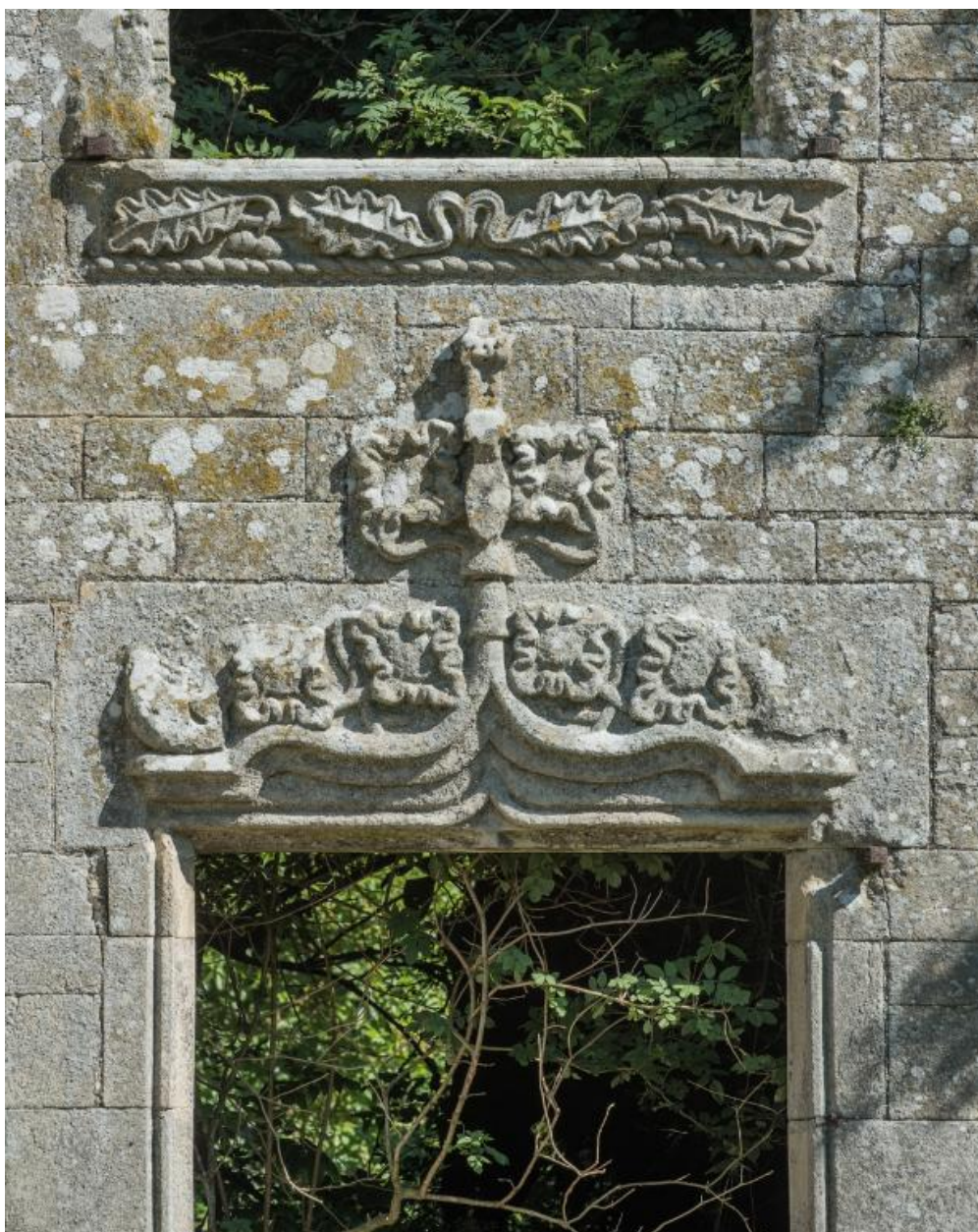
Fenêtre est du rez-de-chaussée, détail de l'accolade et du décor sculpté
