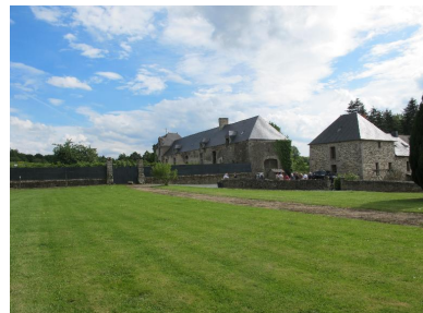
Entre les deux pavillons, l'hôpital Phot. Véronique Orain IVR53_20172206315NUCA
