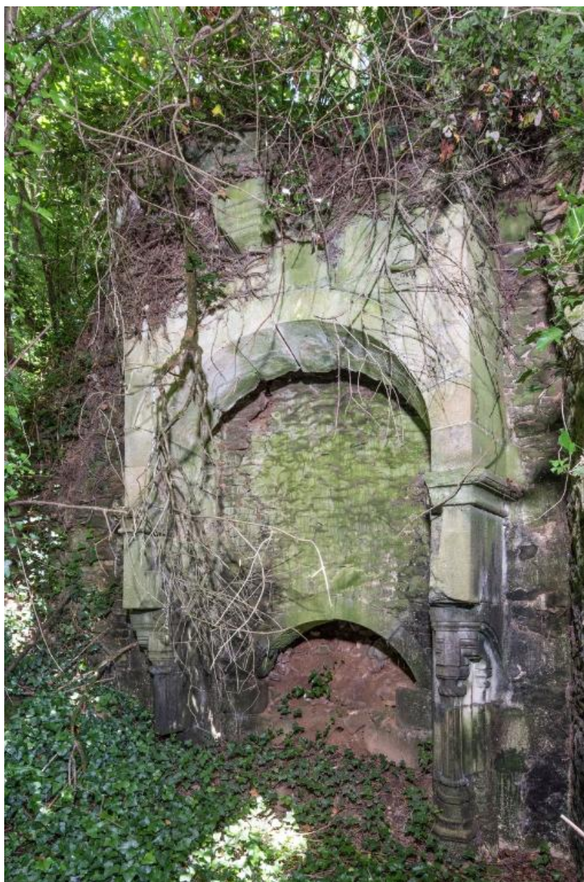
Le château : vue intérieure, partie est, vestiges des cheminées
