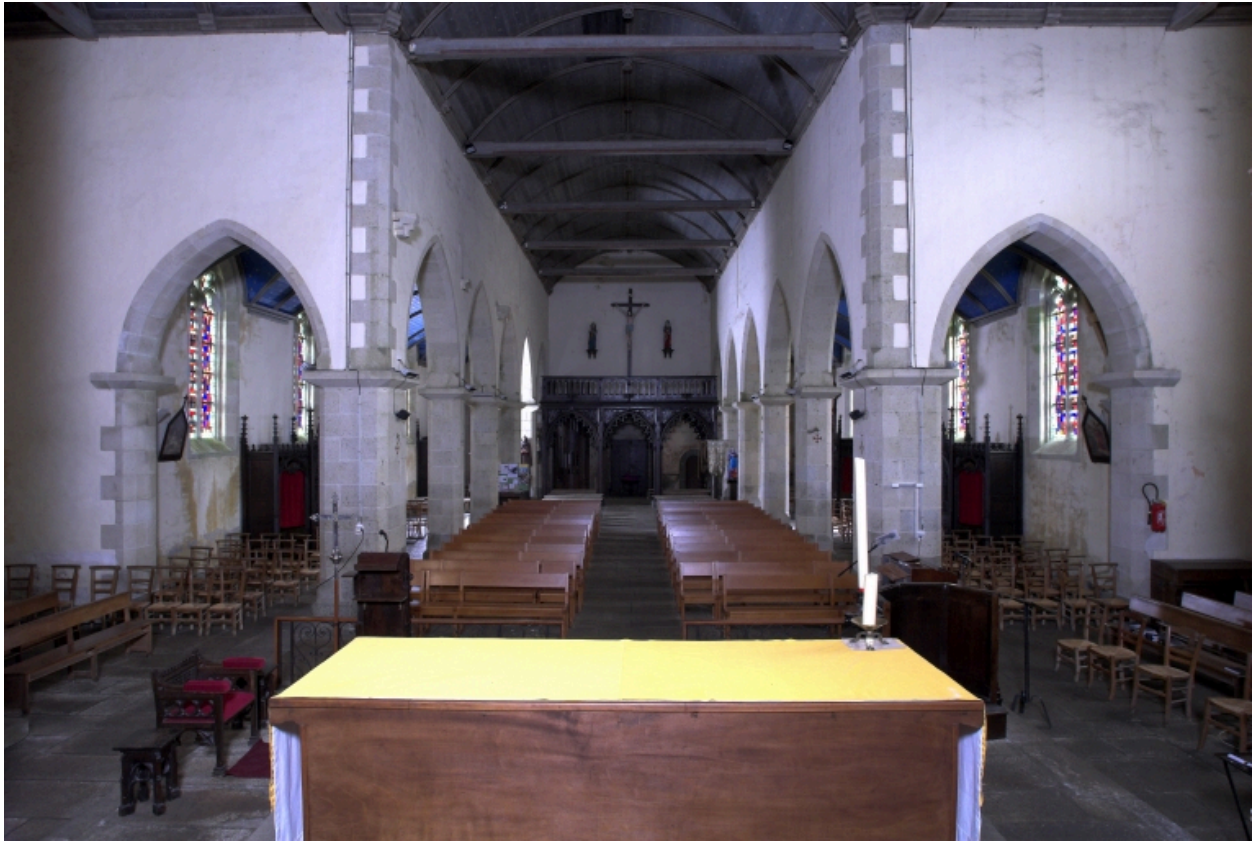
Scrignac, église paroissiale Saint-Pierre : vue axiale ouest, état en 2007
