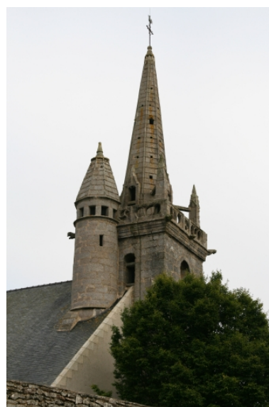
Face nord-ouest du clocher Phot. Florent Maillard IVR53_20082906786NUCA
