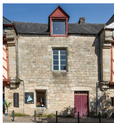
Le débord de la maçonnerie destiné à recevoir la sablière de
