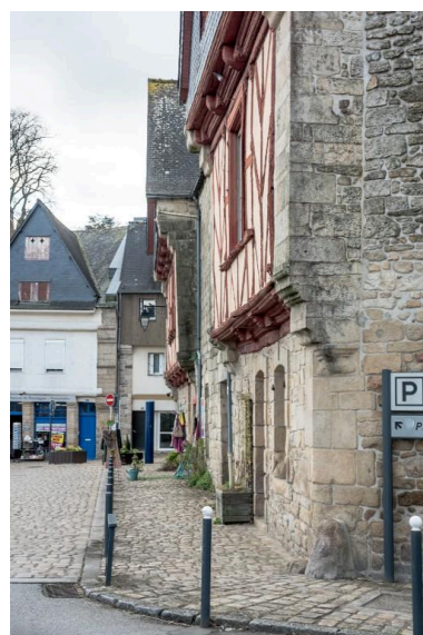
Double encorbellement des premiers étages et des combles. Phot. Hazouard Candice IVR53_20205600283NUCA
