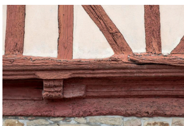
L'encorbellement comporte des entretoises qui masquent l'espace entre chaque solive. Phot. Hazouard Candice IVR53_20205600282NUCA
