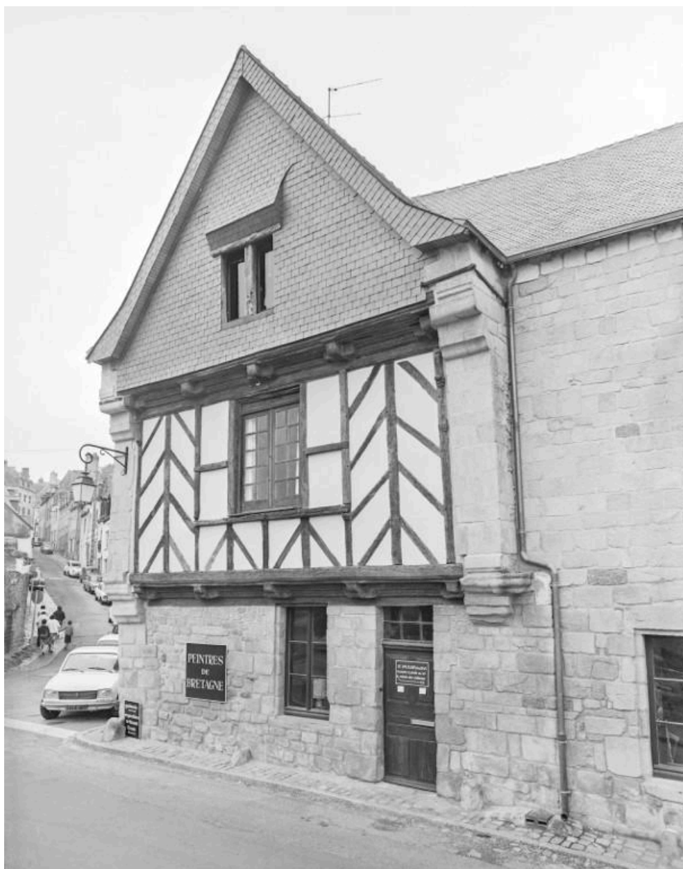
Façade sur rue dont l'étage en pan de bois est en encorbellement (maison de gauche).
