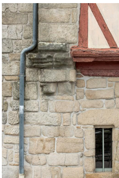
Détail de la jonction entre les sablières et le mur en encorbellement. Phot. Hazouard Candice IVR53_20205600281NUCA
