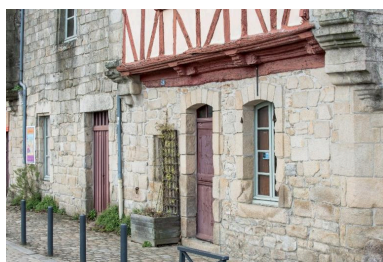
Encorbellement du premier étage, sur solives débordantes. Phot. Hazouard Candice IVR53_20205600280NUCA
