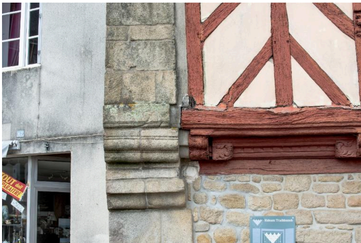
Articulation entre pan de bois et maçonnerie.
