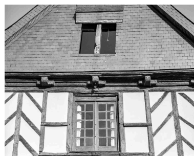
Les éléments de l'encorbellement sont moulurés, avec décor de feuillage sur les congés des entretoises (partie gauche). Phot. François Dagorn IVR53_19785600621X
