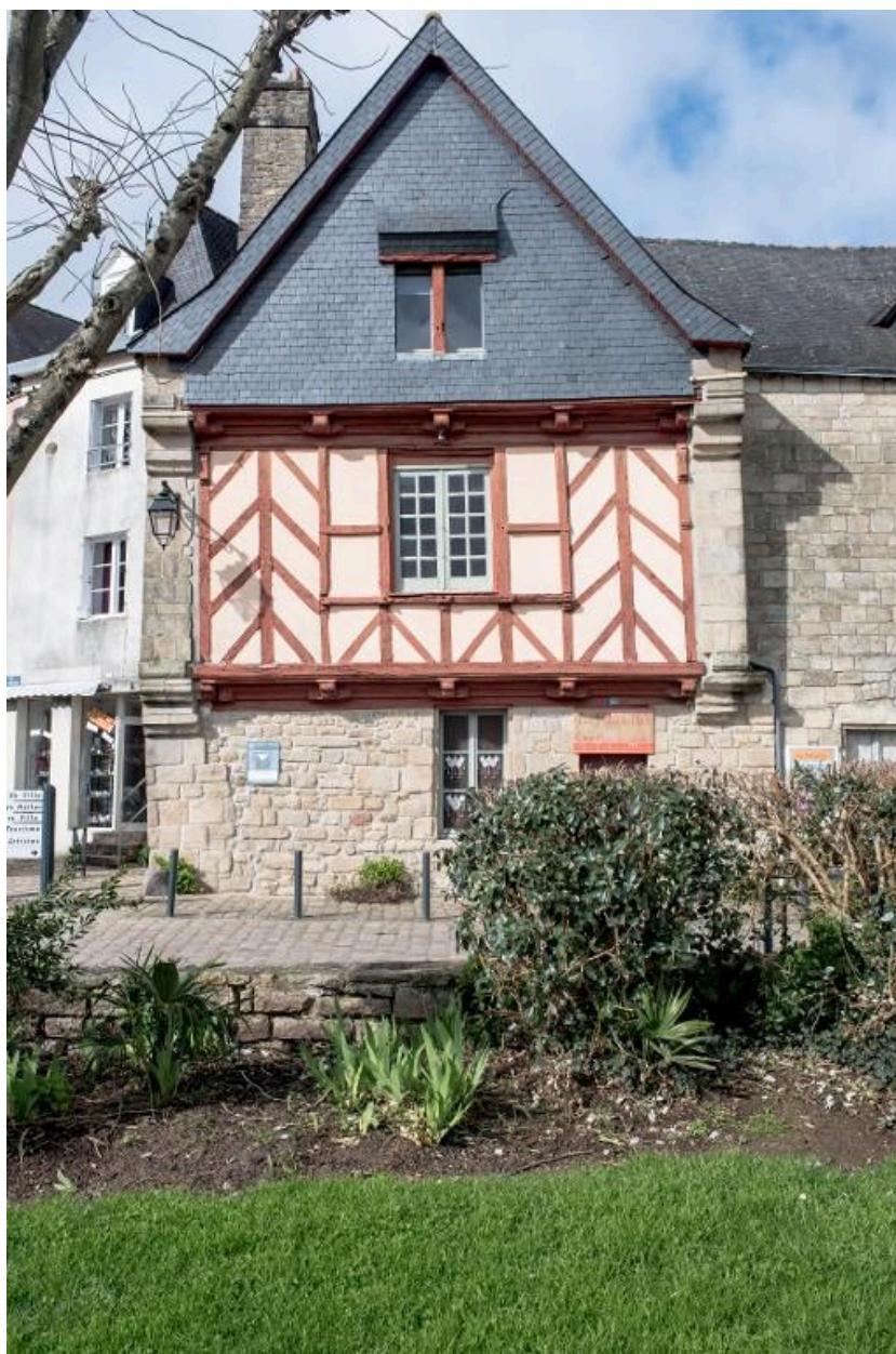
Façade sud-est dont l'étage présente un pan de bois en encorbellement accompagné par les ressauts maçonnés (état en 2020).
