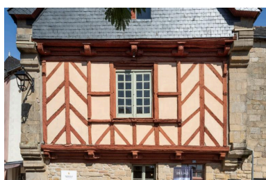
Contreventement de l'étage en chevrons avec initialement quatre travées centrales destinées aux fenêtres. Phot. Léna Leroy IVR53_20255600379NUCA
