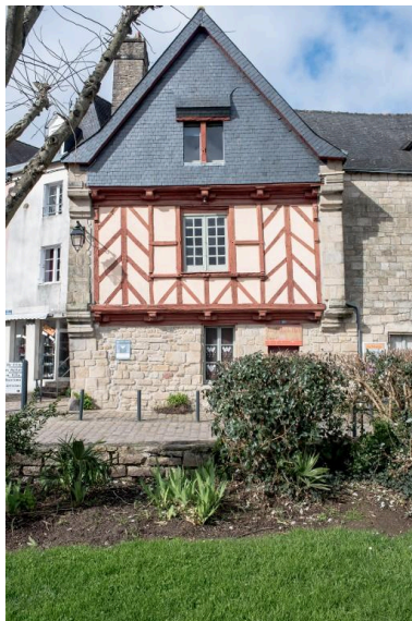
Façade sud-est dont l'étage présente un pan de bois en encorbellement accompagné par les ressauts maçonnés (état en 2020). Phot. Hazouard Candice IVR53_20205600276NUCA
