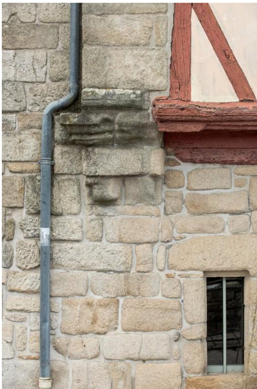
Détail de la jonction entre les sablières et le mur en encorbellement.
