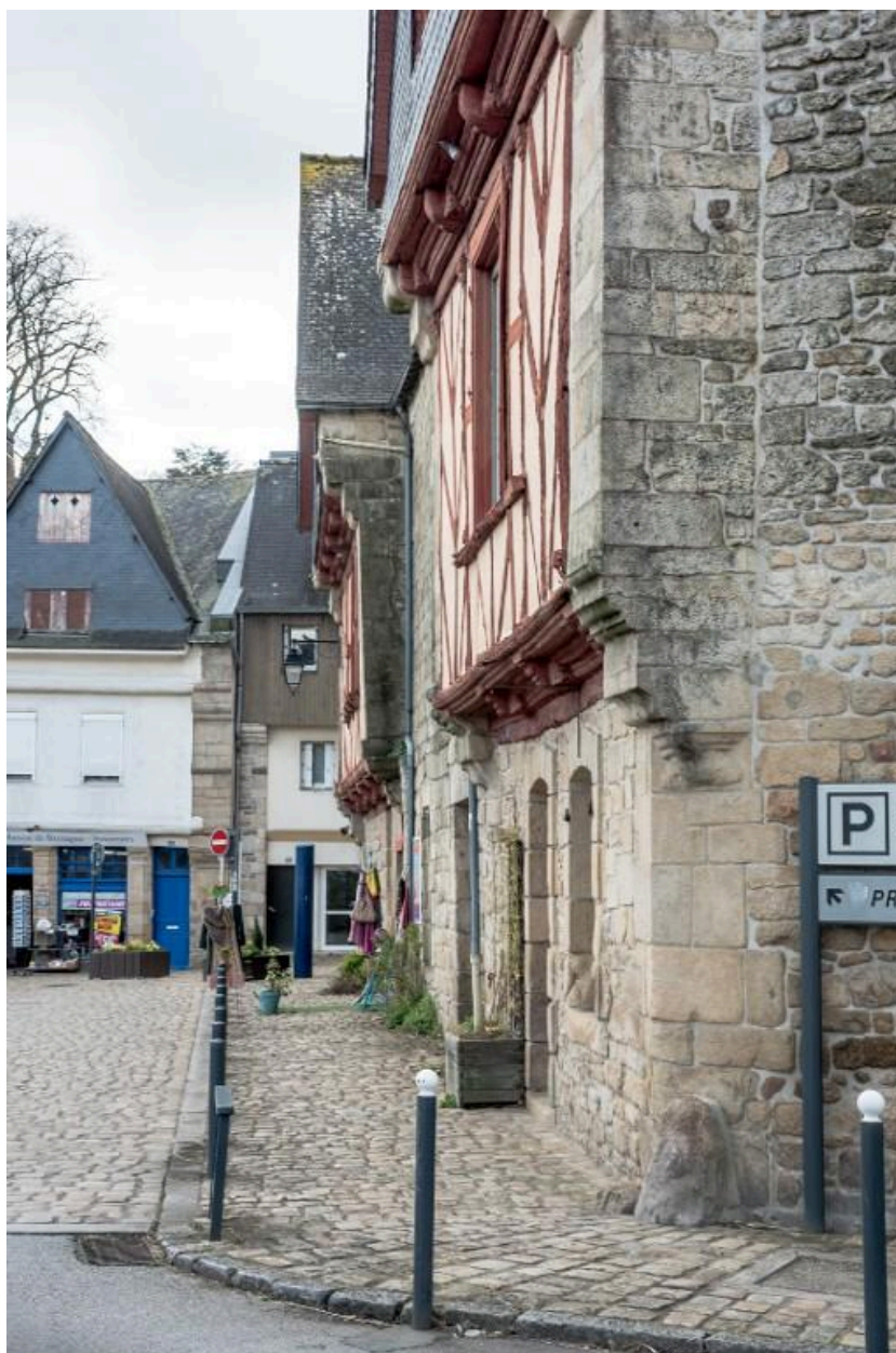
Double encorbellement des premiers étages et des combles.
