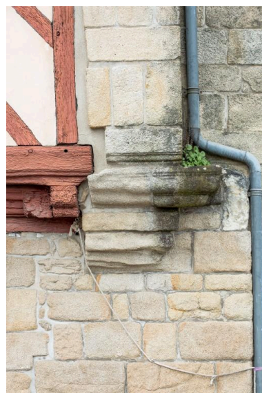
Les sablières de l'encorbellement prennent appui dans le maçonnerie. Phot. Hazouard Candice IVR53_20205600279NUCA
