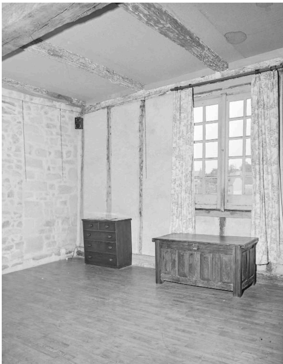
Le pan de bois, vu de l'intérieur (étage, partie ouest).
