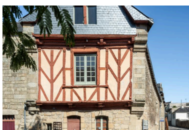
L'aspect des consoles sculptées en tête des poteaux de l'étage est similaire à celui de la façade de gauche. Phot. Léna Leroy IVR53_20255600376NUCA
