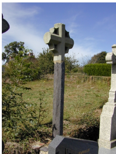
La croix de cimetière ; le fût est en schiste pourpre, la croix est en grès Phot. Elise Lauranceau IVR53_20003510146NUCA
