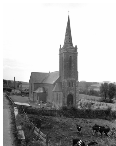
Elévation ouest : vue générale Phot. Guy Artur, Phot. Norbert Lambart IVR53_19943501747X
