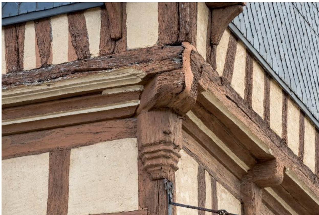
Détail du poteau cornier d'étage et de l'enrayure.
