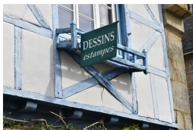
Détail de l'enseigne et d'une structure en croix de Saint-André Phot. Rémy Paurion IVR53_20245610180NUCA
