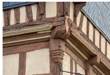
Détail du poteau cornier d'étage et de l'enrayure. Phot. Hazouard Candice IVR53_20205600290NUCA
