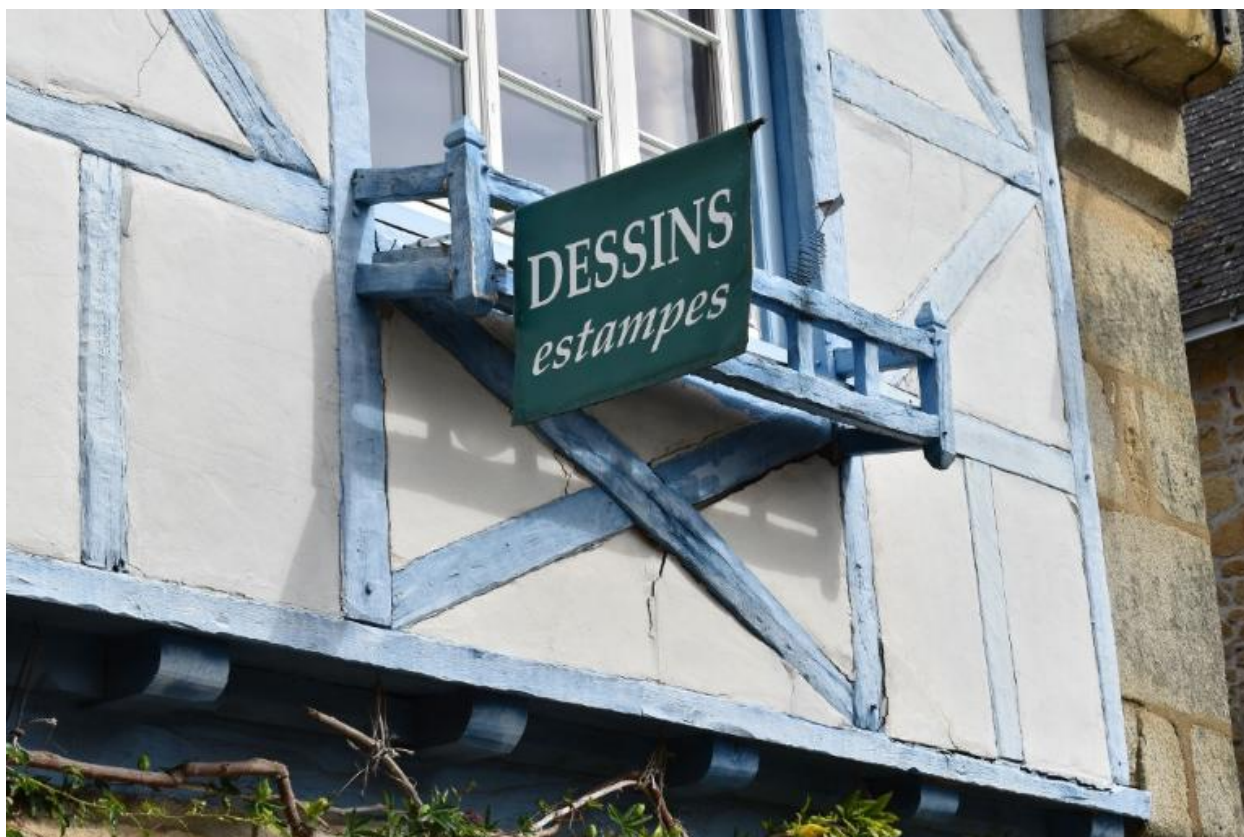
Détail de l'enseigne et d'une structure en croix de Saint-André
