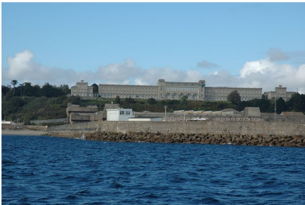
Vue générale depuis la rade en 2008
