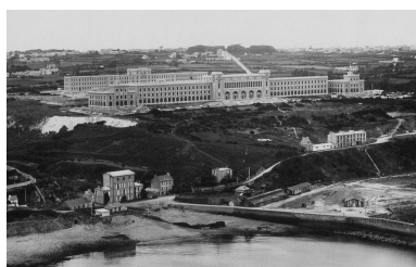
Vue aérienne oblique de l'école Navale de Brest en juin 1936. Au premier plan à droite : le futur site de la base allemande de sous-marins Autr. L'Illustration, Repro. Guillaume Lécueillier IVR53_20042903946NUCA
