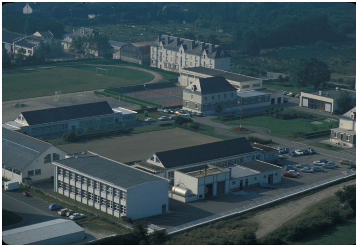
Vue aérienne oblique des bâtiments en 1980 : bâtiments annexes et terrain de sport
