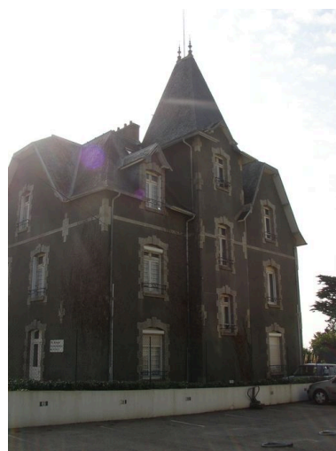
Façades ouest et nord de la villa Kerbugalé Phot. Johan Vincent IVR53_20062908669NUCA
