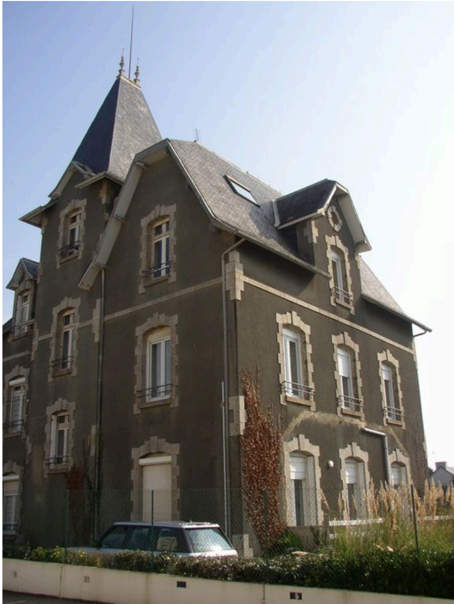
Façades sud et ouest de la villa Kerbugalé
