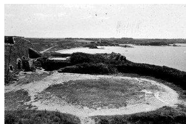
Vue des lignes de Quéléren en 1969 : batterie basse au pied du demi-bastion n° 1 (batterie 9). En arrière plan : l'anse de Camaret, site du débarquement anglo-hollandais de 1694 Phot. Auteur inconnu, Repro. Norbert Lambart IVR53_19692905001Z
