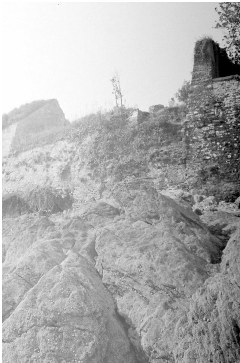
Vue des lignes de Quélern en 1972 : vestiges de la porte de Crozon, extrémité est des lignes
