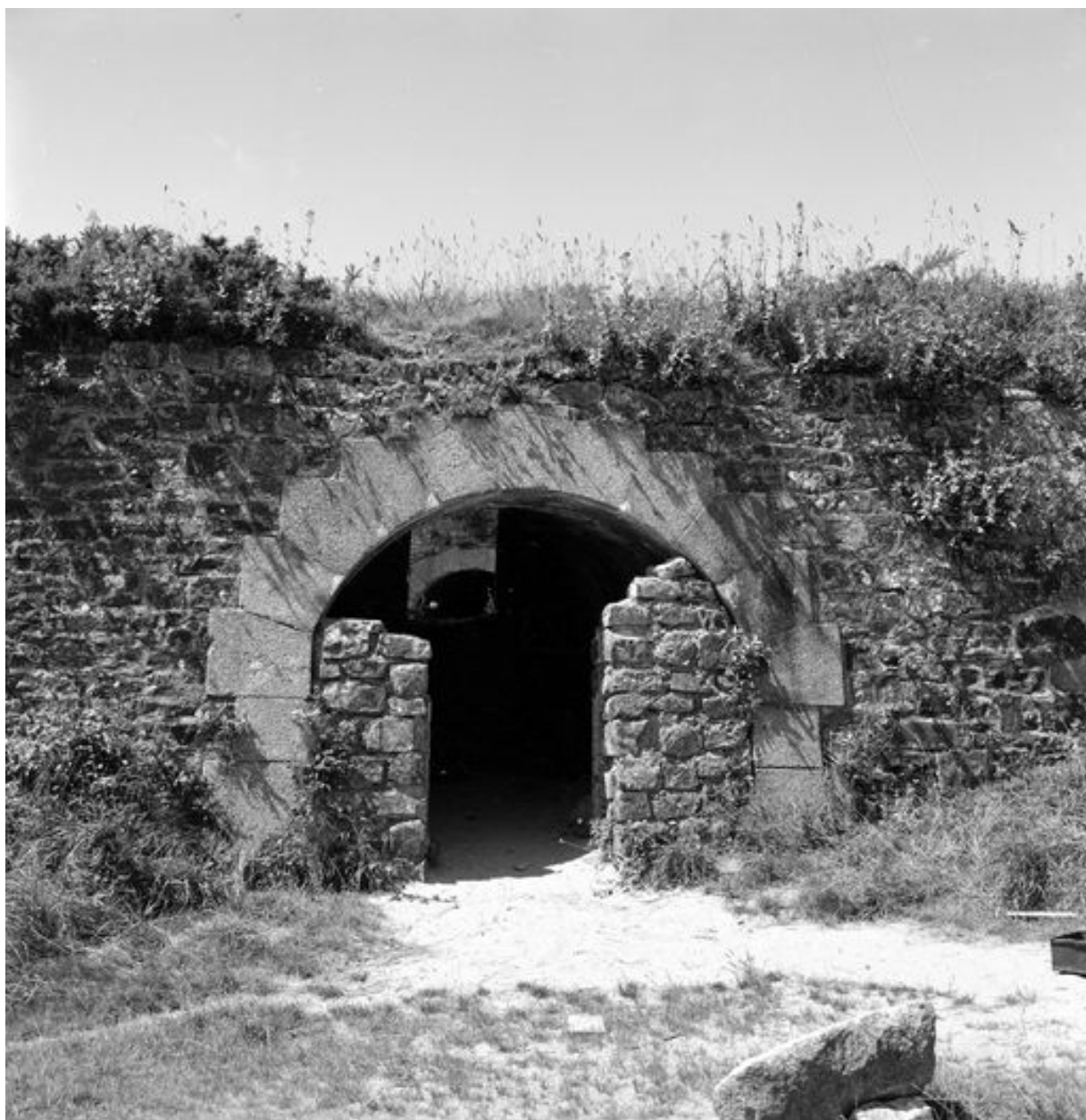
Vue des lignes de Quélern en 1969 : poterne de la tenaille 10
