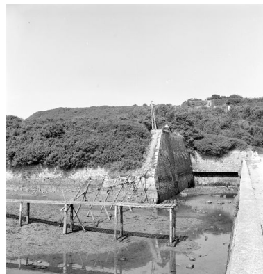
Vue des lignes de Quéléren en 1969 : escarpe de l'orillon 8 au niveau du bassin de retenue des eau Phot. Guy Artur IVR53_19692900147X
