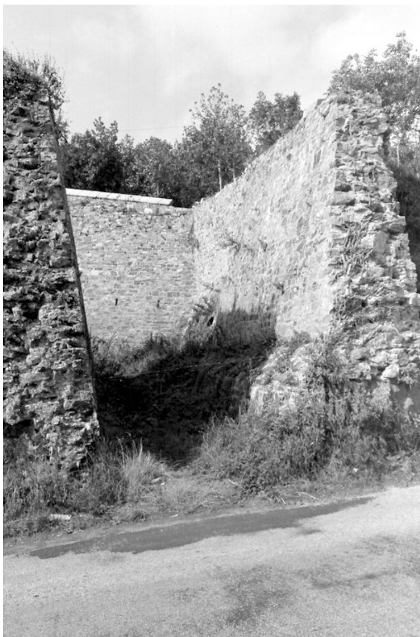
Vue des lignes de Quélern en 1972 : vestiges de la porte de Crozon, fossé
