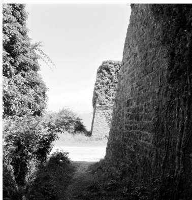
Vue des lignes de Quéléren en 1969 : route de porte de Crozon à la traversée des ouvrages près de l'orillon 8 Phot. Guy Artur IVR53_19692900146X
