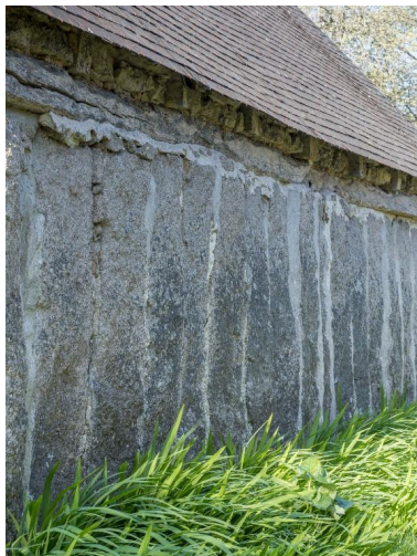
Elévation avec orthostates d'une ancienne grange. Phot. Charlotte Barraud IVR53_20252900845NUCA
