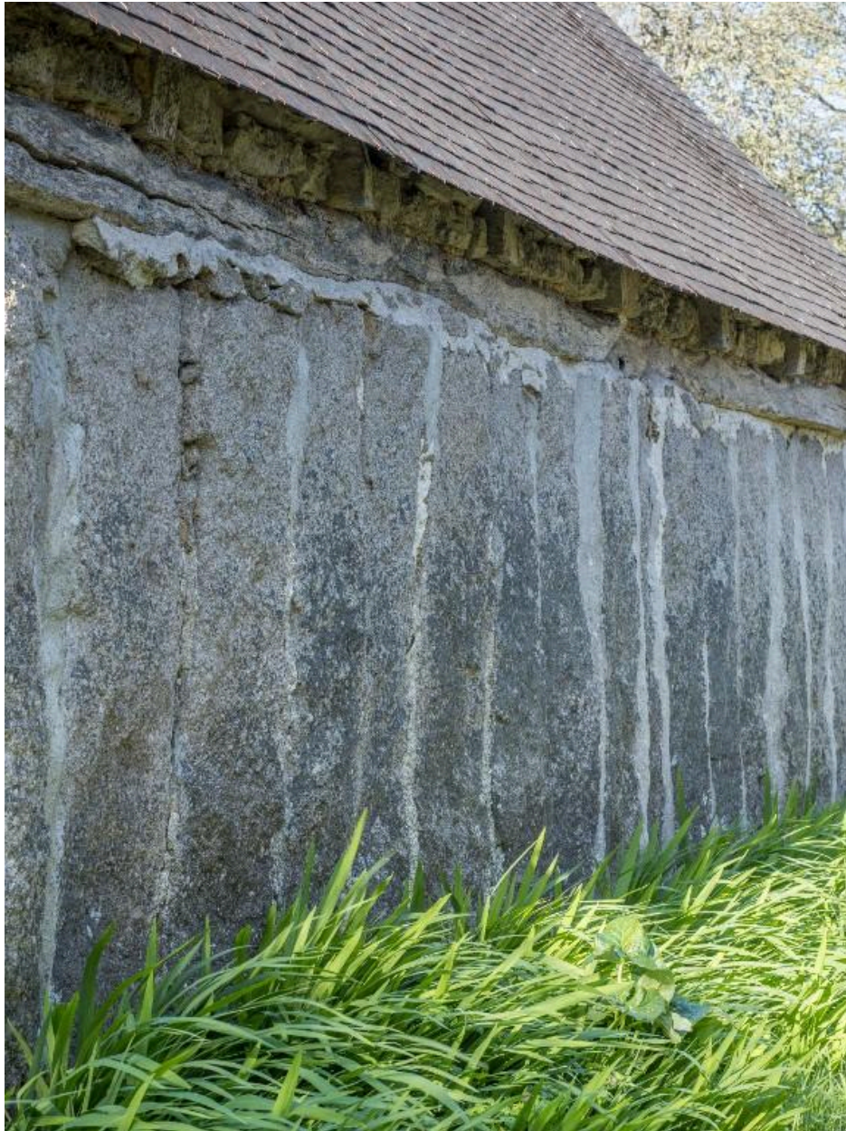
Elévation avec orthostates d'une ancienne grange.
