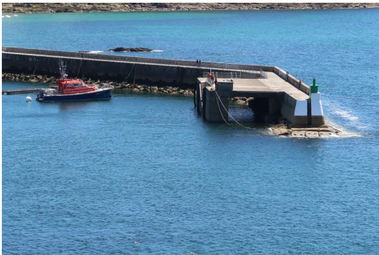
Môle, quai sur pieux béton et feu
