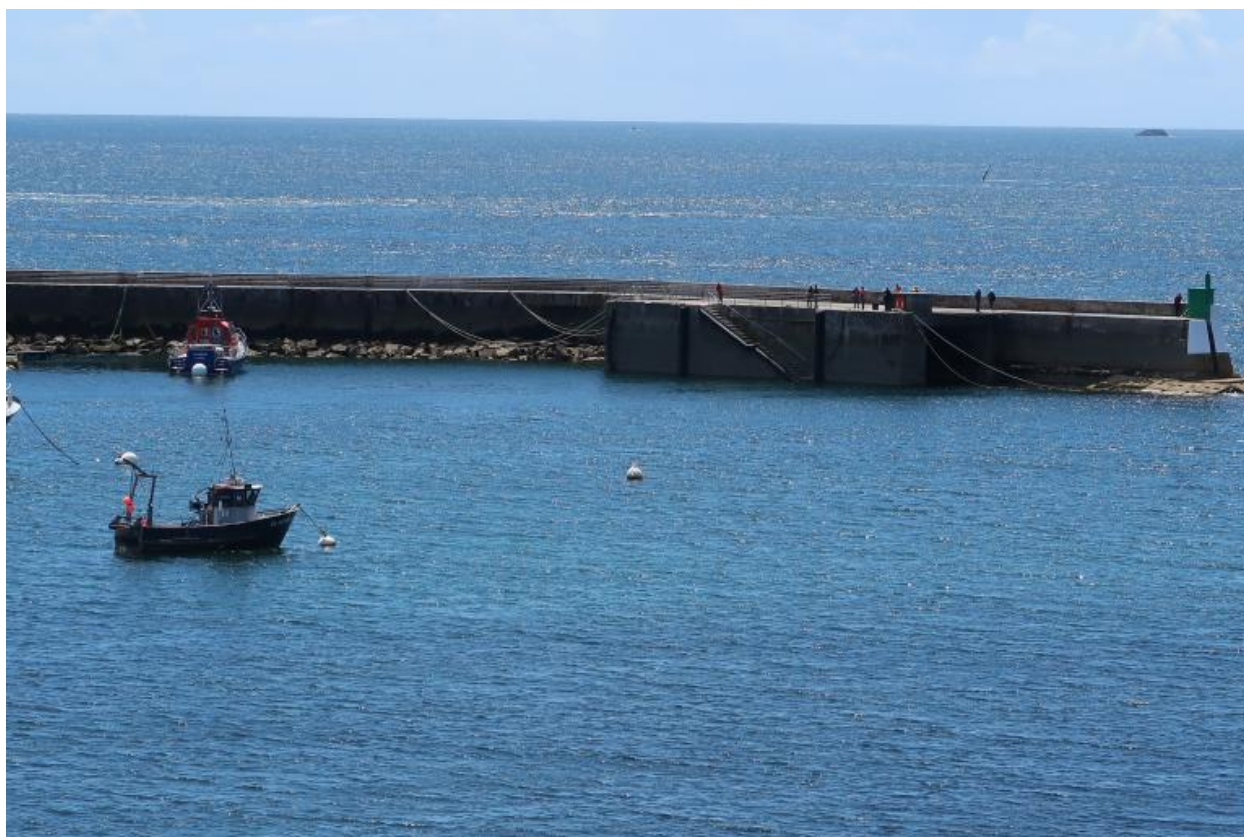
Môle de Sainte-Barbe, quai et feu de chenal, côté est
