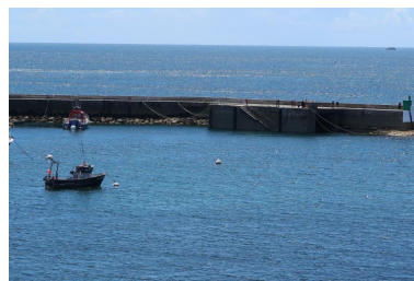
Môle de Sainte-Barbe, quai et feu de chenal, côté est Phot. Erwana L'Haridon IVR53_20232905833NUCA
