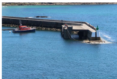
Môle, quai sur pieux béton et feu Phot. Erwana L'Haridon IVR53_20232905832NUCA
