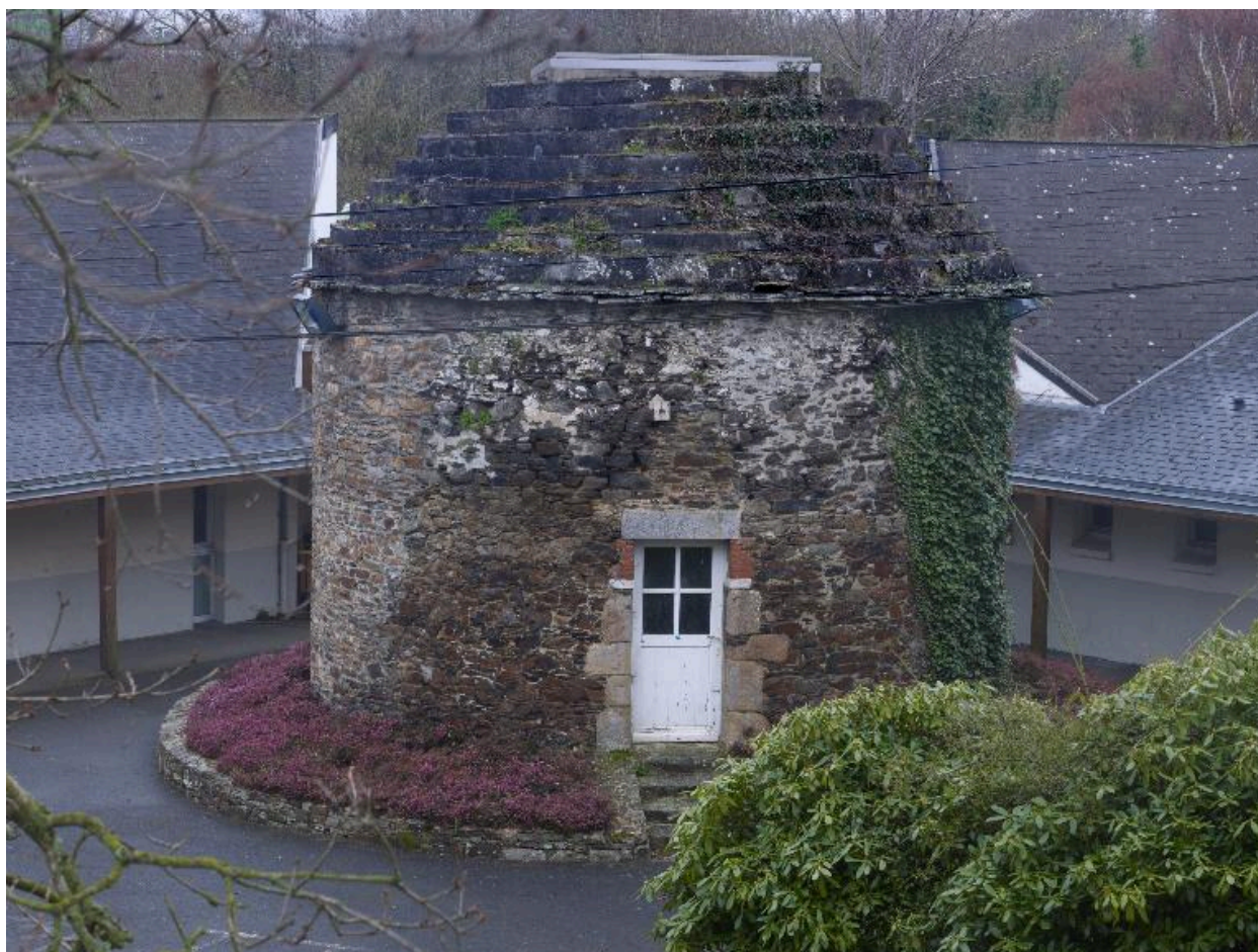
Colombier à l'ouest du château. Vue générale
