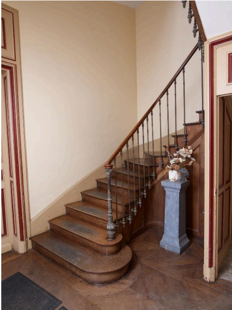
Cage d'escalier située à l'extrémité ouest du château. Vue générale depuis le rez-de-chaussée
