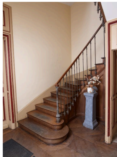
Cage d'escalier située à l'extrémité ouest du château. Vue générale depuis le rez-de-chaussée Phot. Bernard Bègne IVR53_20152200037NUCA
