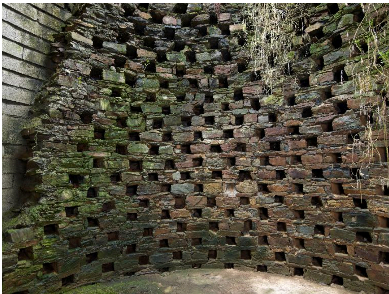
Colombier à l'ouest du château. Vue intérieure
