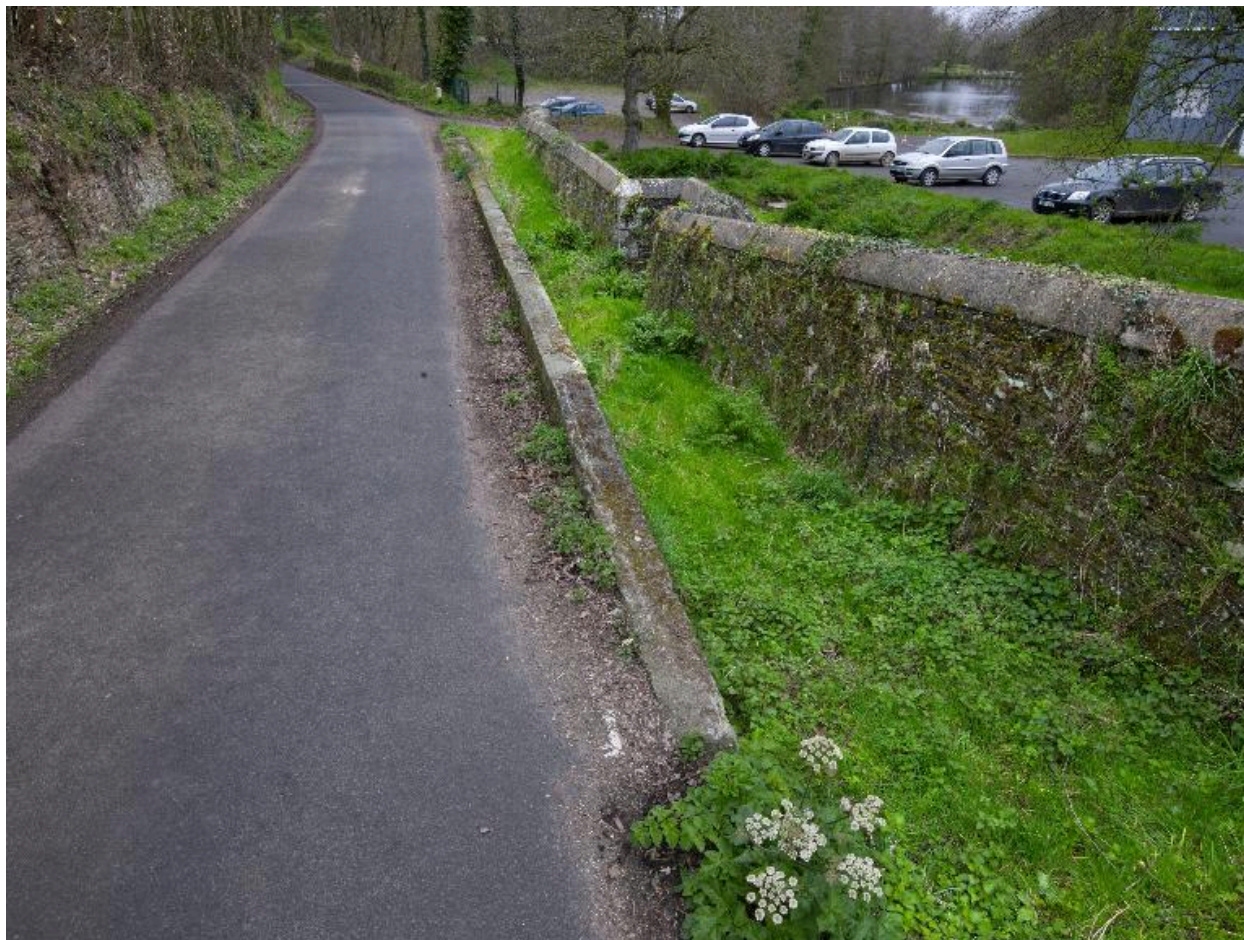
Mur de clôture du parc à l'ouest du château avec encoche pour la fontaine et rampe d'accès. Vue générale sud
