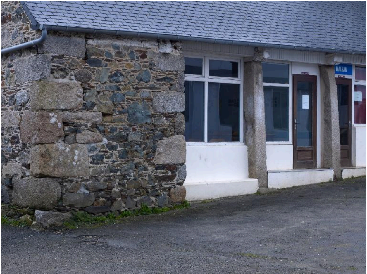
Remise agricole au nord-est du château. Détail
