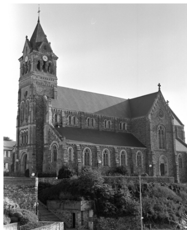
Vue générale sud-ouest Phot. Guy Artur, Phot. Norbert Lambart IVR53_19943500766X
