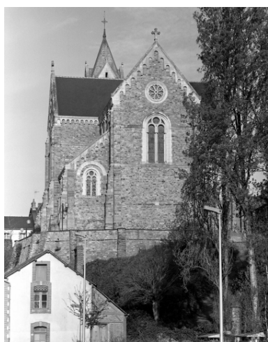
Vue générale est Phot. Guy Artur, Phot. Norbert Lambart IVR53_19943500767X
