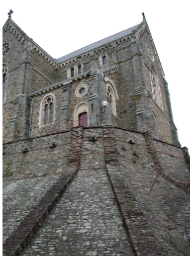
Murs de soutènement Phot. Claude Quillivic IVR53_20013516133NUCA
