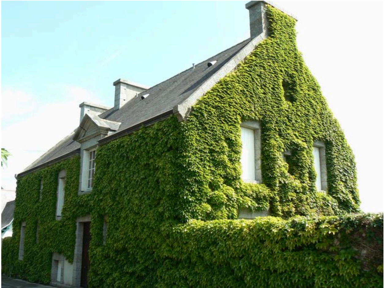
Vue de trois-quarts arrière de la villa Ker Gan Avel, côté terre
