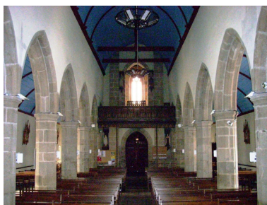
Vue axiale ouest Phot. Gwénaél Fauchille IVR53_20082906552NUCA
