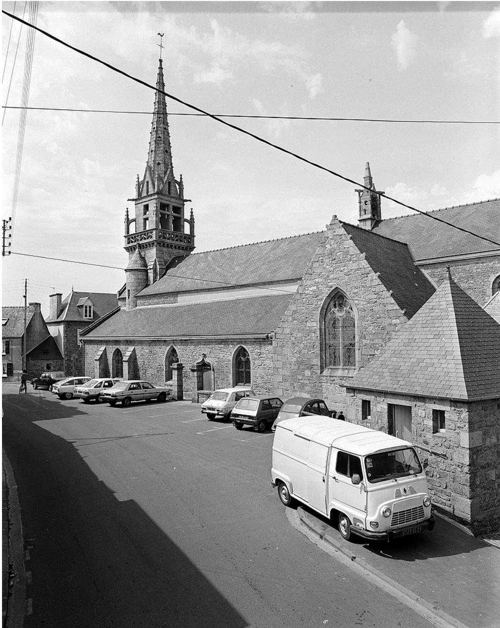
Vue générale du sud-est
