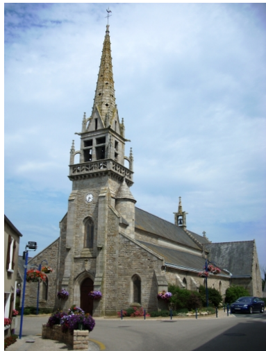
Vue générale sud-ouest Phot. Gwénaél Fauchille IVR53_20082906548NUCA
