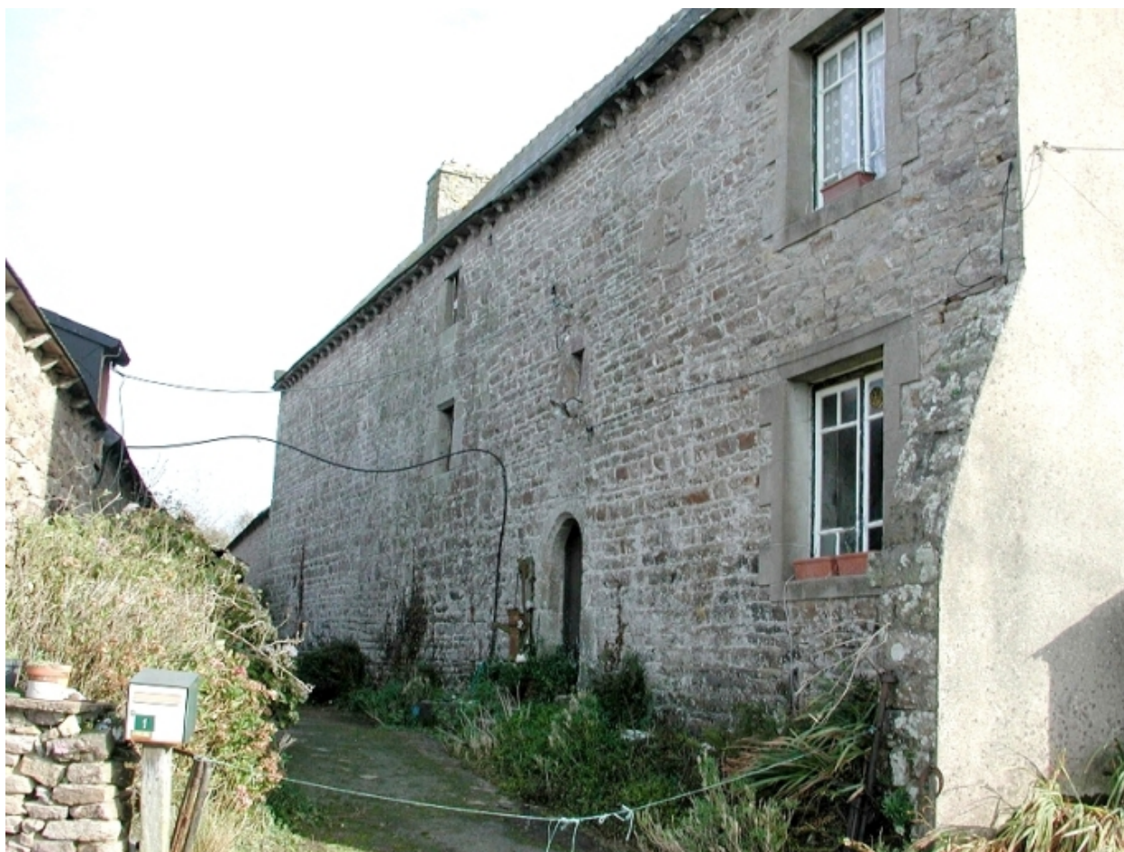
Vue générale de la façade postérieure.
