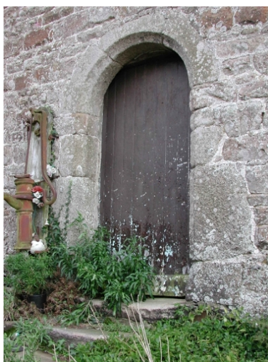
Porte de la façade postérieure. Phot. Patrick Pichouron
