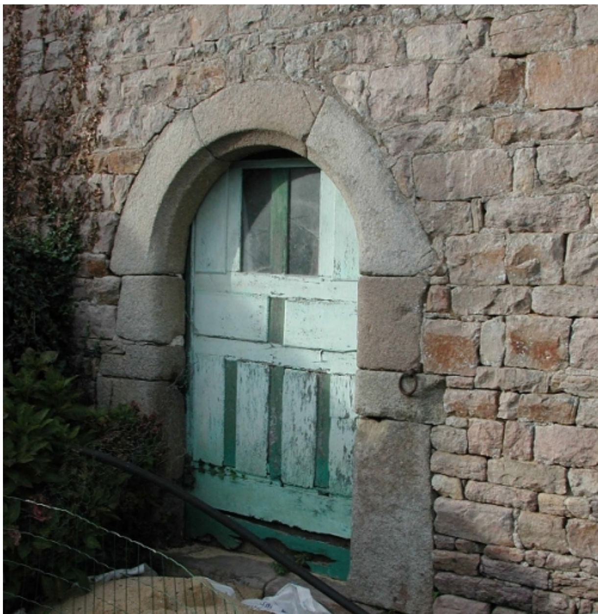
Porte de la façade antérieure.
