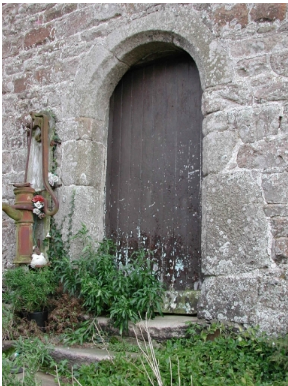
Porte de la façade postérieure.
