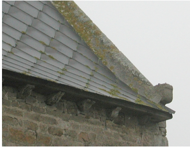
Vue détaillée du rampant et de la corniche. Phot. Patrick Pichouron IVR53_20022215455NUCA
