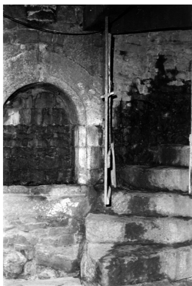
Logis : tourelle d'escalier : vue intérieure Phot. Floc'hlay IVR53_19672200255Z
