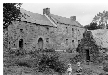
Façade sud et cour pris de l'angle sud ouest Phot. Floc'hlay IVR53_19672200258Z
