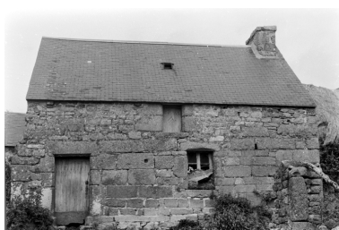
Façade sud Phot. Floc'hlay IVR53_19672200262Z
