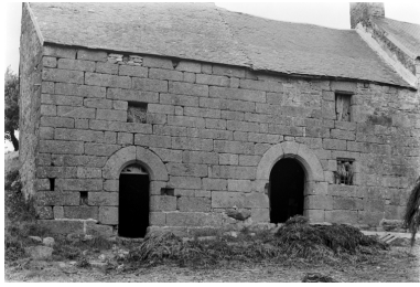
Façade sud Phot. Floc'hlay IVR53_19672200259Z
