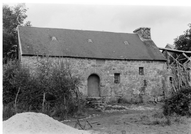
Façade sud Phot. Floc'hlay IVR53_19672200261Z
