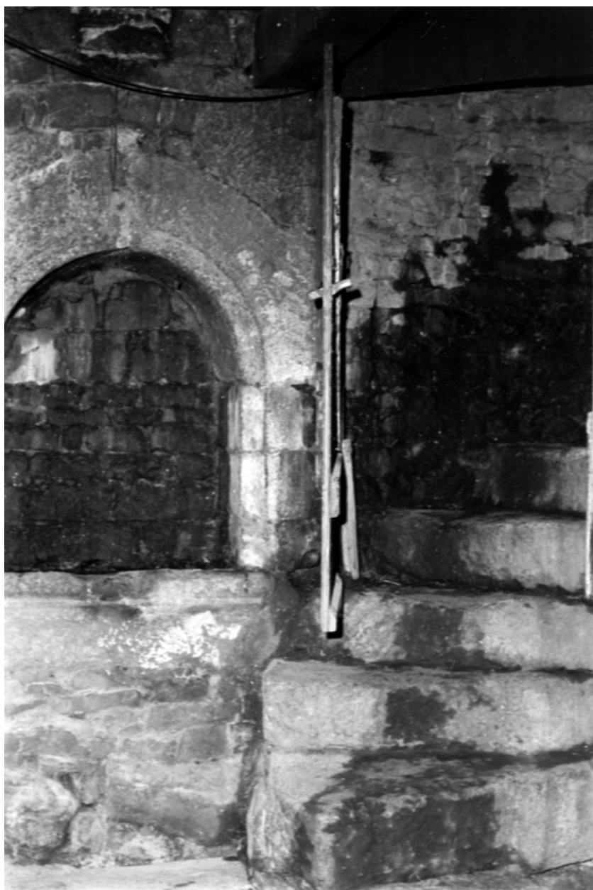
Logis : tourelle d'escalier : vue intérieure
