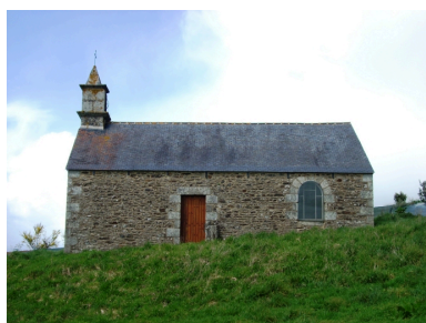
Poullaouen, chapelle Saint- Victor : élévation sud Phot. Gwénaél Fauchille IVR53_20082905798NUCA
