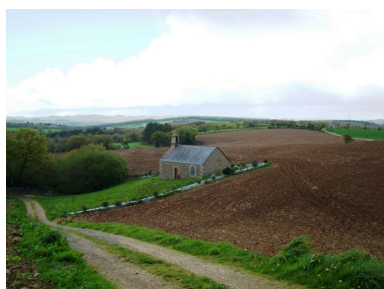
Poullaouen, chapelle Saint-Victor : vue de situation depuis le sud-est Phot. Gwénaél Fauchille IVR53_20082905795NUCA
