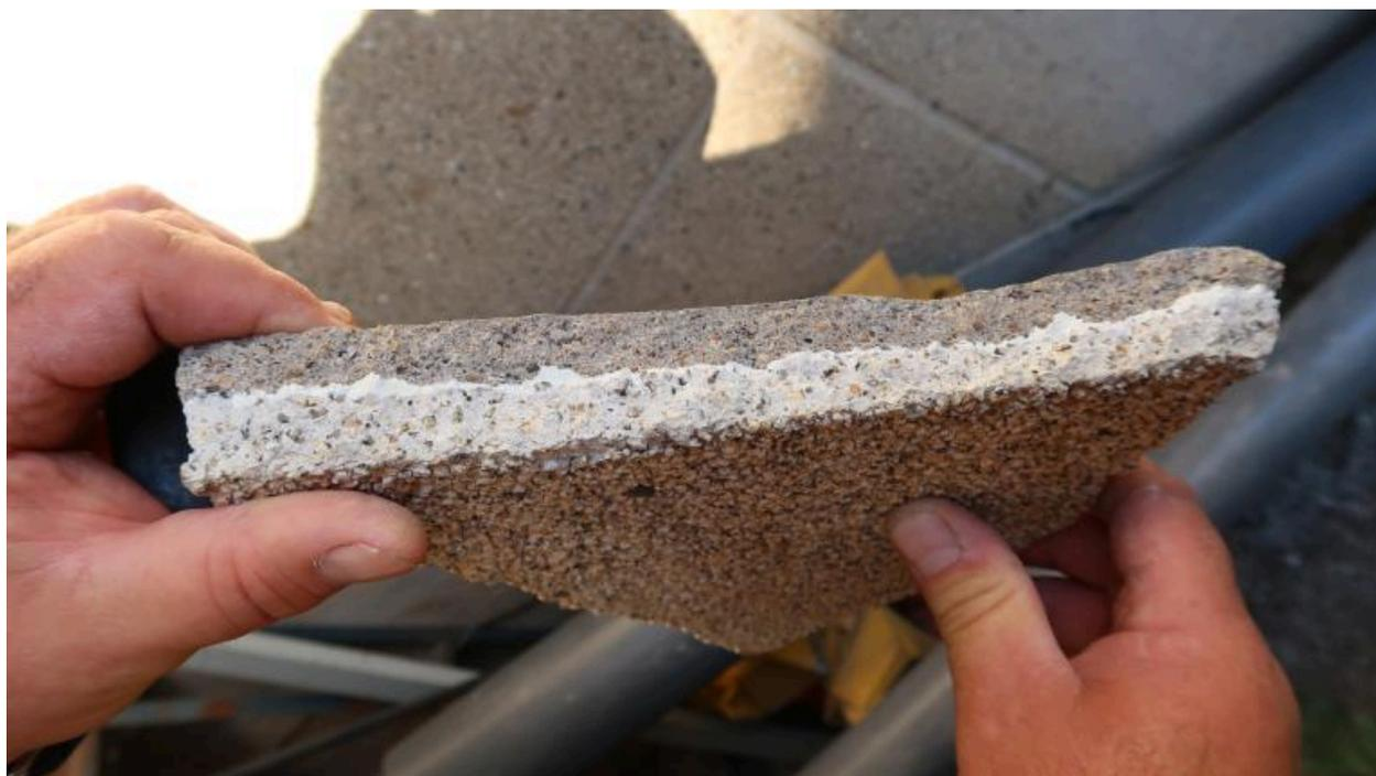
Morceau du revêtement de façade : enduit lavé en gravillon de granite : "portant en valeur la teinte et l'aspect du granulat si caractéristique de la construction bretonne"
