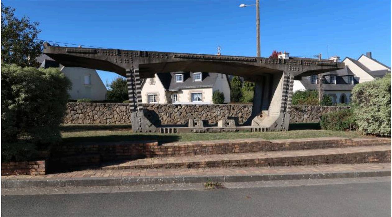
Prototype de voussoir du viaduc du Gouet : "Cette pièce appelée voussoir est le 1er élément réalisé, à titre de prototype, du viaduc du Gouet enjambant le Légué (...) (1980). [II] a été offert au lycée FREYSSINET afin d'illustrer les formations "TRAVAUX PUBLICS" dispensées ici mais aussi en hommage à Eugène FREYSSINET, ingénieur polytechnicien inventeur du béton précontraint."
