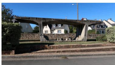
Prototype de voussoir du viaduc du Gouet : "Cette pièce appelée voussoir est le 1er élément réalisé,
