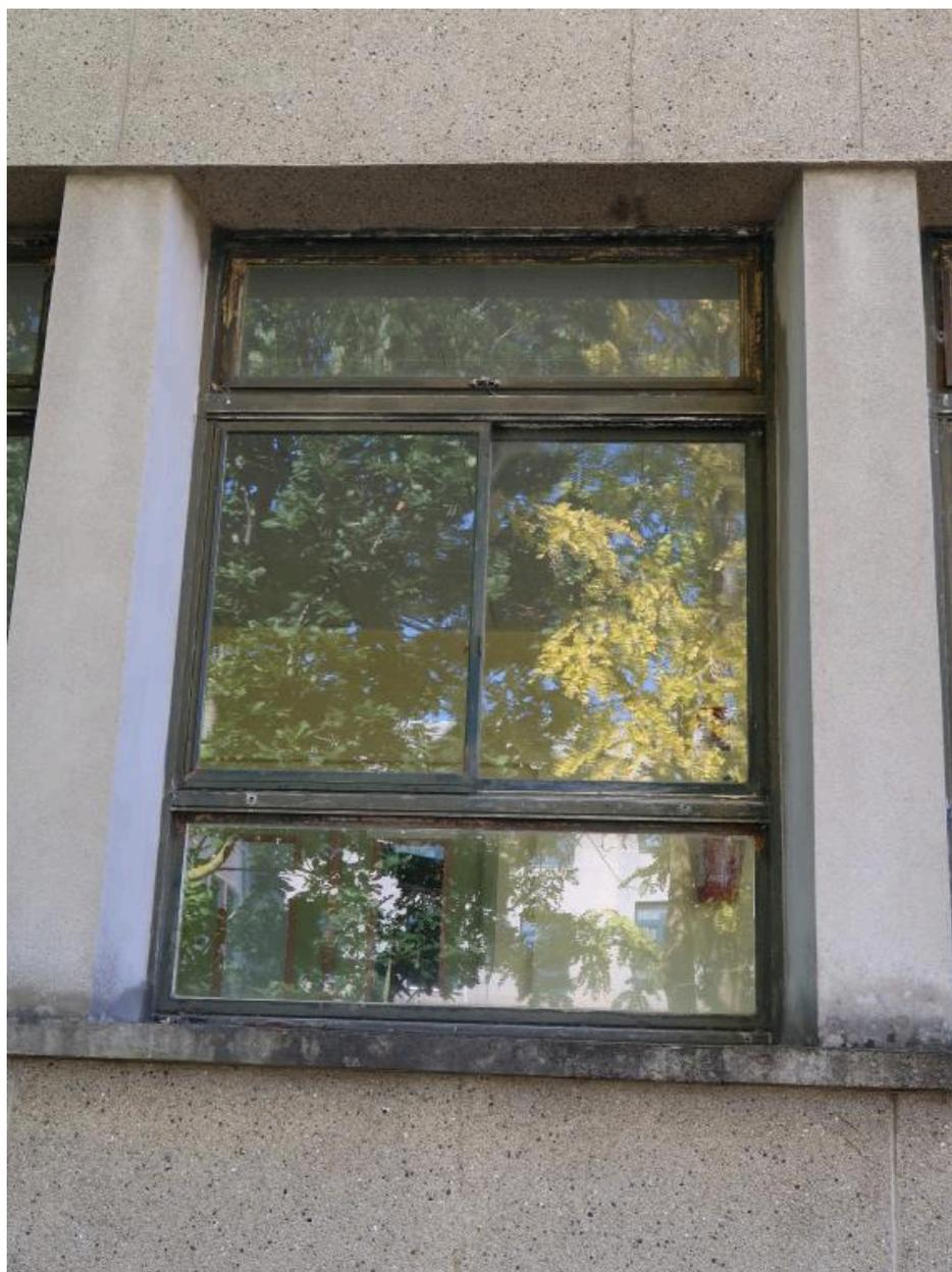
Une fenêtre d'origine, bâtiment D : menuiserie métallique.
