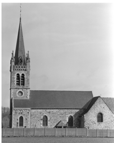
Elévation sud, partie ouest ; vue générale Phot. Guy Artur, Phot. Norbert Lambart IVR53_19943500775X
