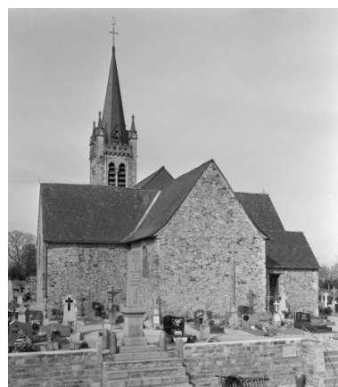
Elévation est ; vue générale Phot. Guy Artur, Phot. Norbert Lambart IVR53_19943500777X
