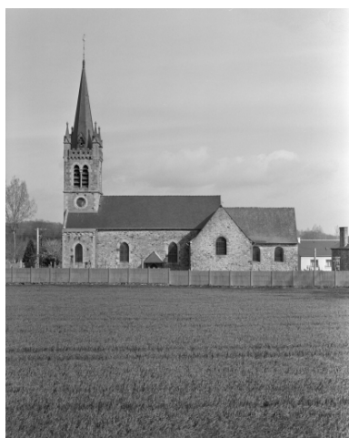
Elévation sud ; vue générale Phot. Guy Artur, Phot. Norbert Lambart IVR53_19943500776X
