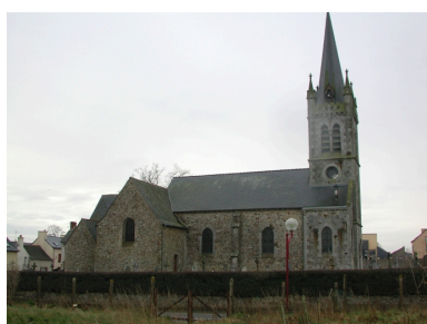
Vue générale nord Phot. Claude Quillivic IVR53_20013506266NUCA
