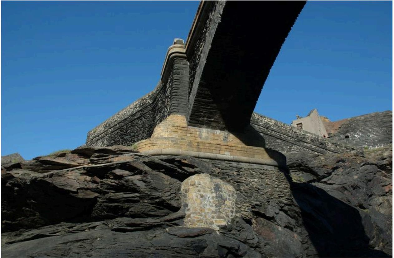
Vue du pont à une seule arche en appareil de schiste renforcé par une maçonnerie en grès de l'îlot des Capucins. Il porte au sud la date de 1861 et les lettres G M pour Génie Maritime
