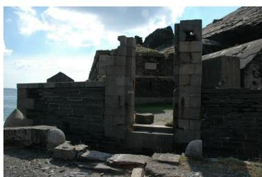
Vue de l'entrée monumentale avec piédroits en granite. Le mur d'enceinte est appareillé en schiste avec chaînage d'angle en granite
