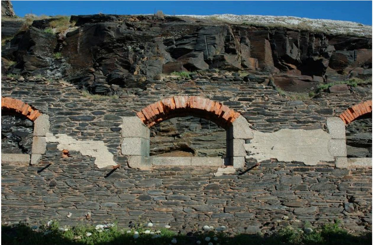
Vue d'une baie de la caserne. Les baies ébrasées vers l'intérieur sont voutées en segment à claveaux : appui, piédoits en granite et arc en brique
