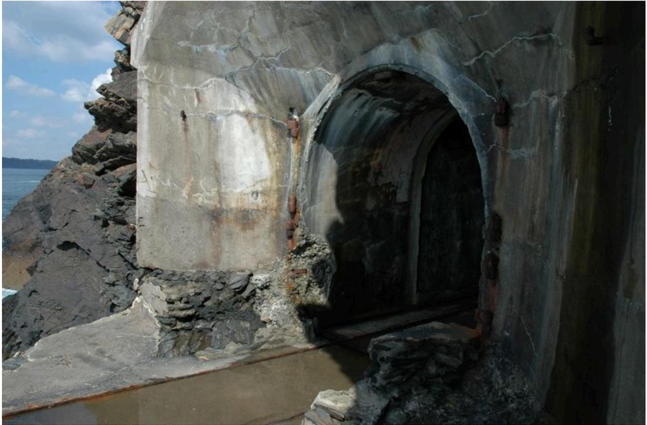
Vue de l'abri de jour et poste de combat pour projecteur de 150 cm situé au ras de l'eau. On distingue au sol, les rails qui permettaient la manutention du projecteur
