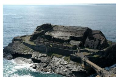
Vue générale de l'îlot des Capucins. Le rocher protège particulièrement bien les casernements contre un bombardement naval. La solution est inspirée du plan de la batterie rasante de l'ingénieur Traverse approuvé par Vauban en 1696 mais non réalisé
