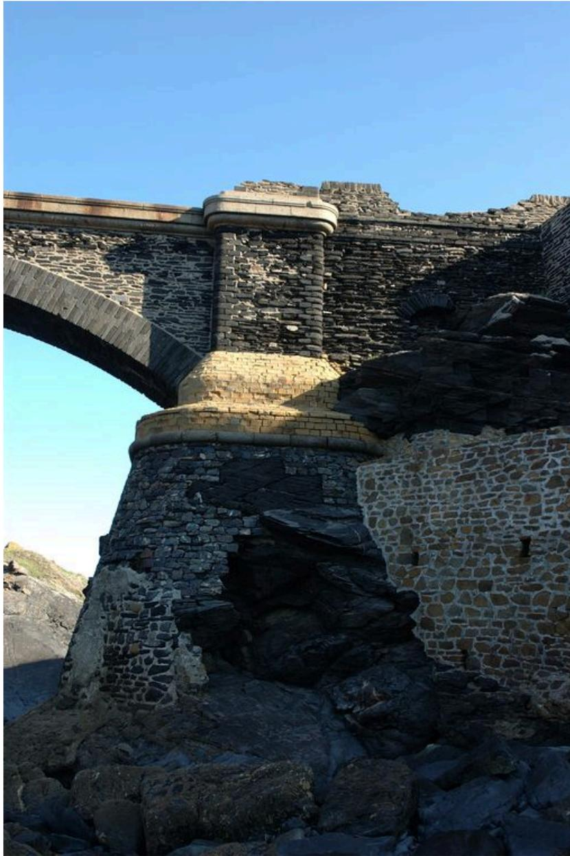
Vue du pont à une seule arche en appareil de schiste renforcé par une maçonnerie en grès de l'îlot des Capucins. Il porte au sud la date de 1861 et les lettres G M pour Génie Maritime
