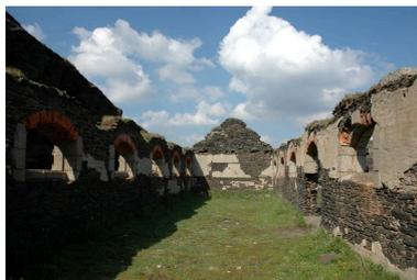
Vue intérieure de la caserne. De forme rectangulaire, elle est à soubassement continu de granite avec les chaînages d'angle, la corniche et l'encadrement des ouvertures. Les appuis de fenêtre forment un bandeau continue
