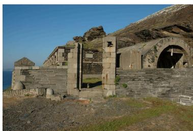
Vue du dispositif d'entrée : mur d'enceinte, bâtardeau surmonté de deux dames, fossé sec, pont-levis et portail monumental d'entrée
