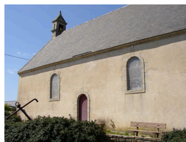
Vue latérale de la chapelle Notre-Dame de Bon Voyage Phot. Johan Vincent IVR53_20065606575NUCA
