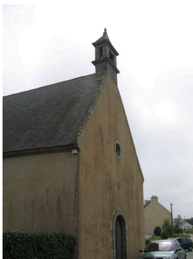
Vue générale de la chapelle Notre-Dame de Bon Voyage Phot. Françoise Péron IVR53_20075605723NUCA
