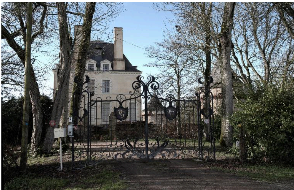
Vue de la façade est du château
