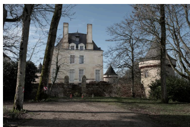
Vue de la façade est du château Phot. Bernard Bègne IVR53_20163500154NUCA
