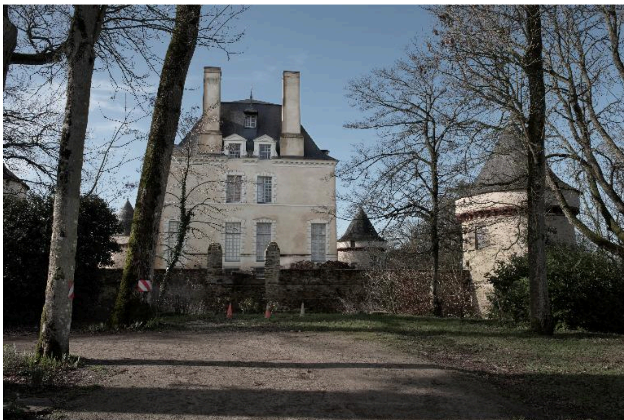
Vue de la façade est du château
