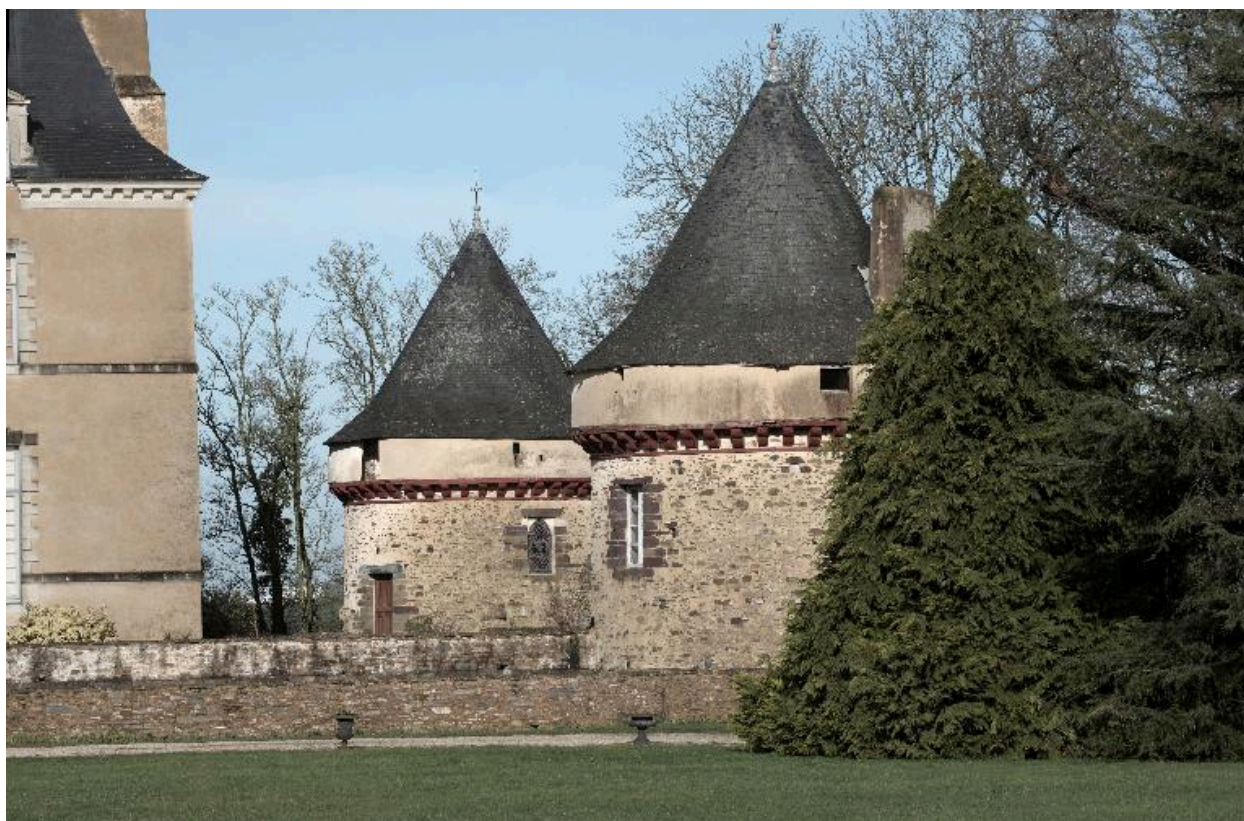
Vue des tours à l'est du château
