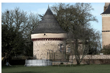
Vue de la tour sud-ouest du château Phot. Bernard Bègne IVR53_20163500158NUCA
